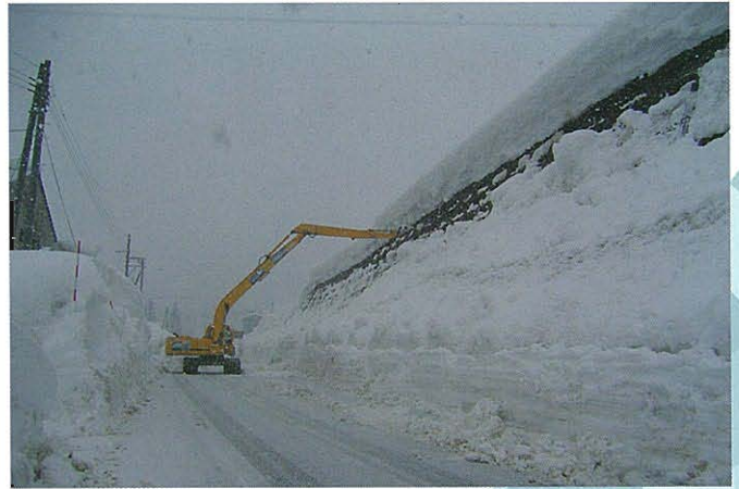
⇩ロングリーチバックホーによる法面雪庇落とし作業
