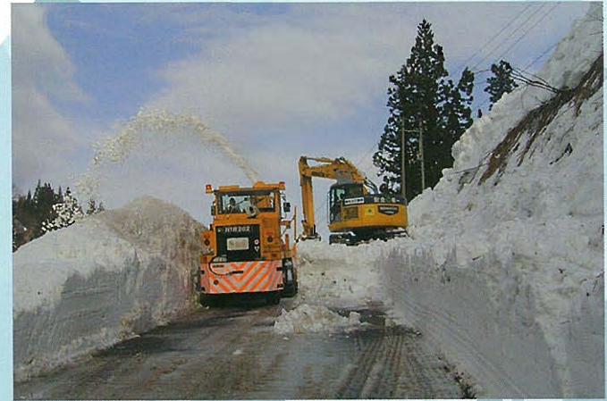
⇩通行止めにして法面雪庇落とし後の排雪作業
