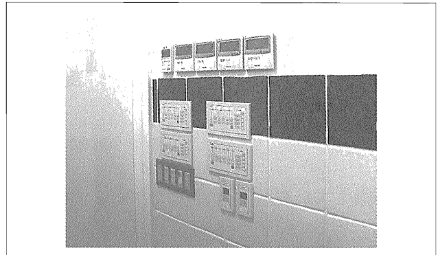
写真-5 自動調光システムのコントロールスイッチ
