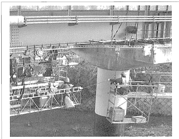
写真—11 作業床のスルー状況
