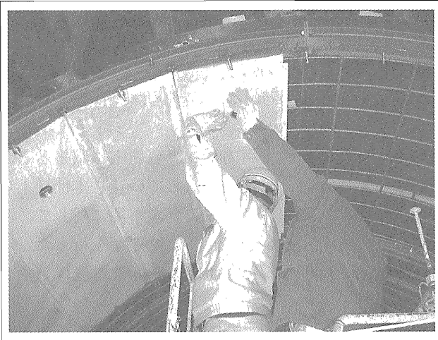
写真一 覆工板の取付け状況
