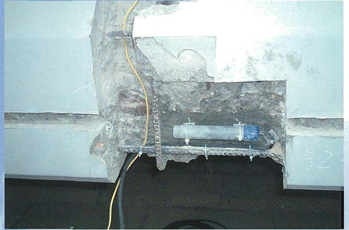
↑照合電極設置
