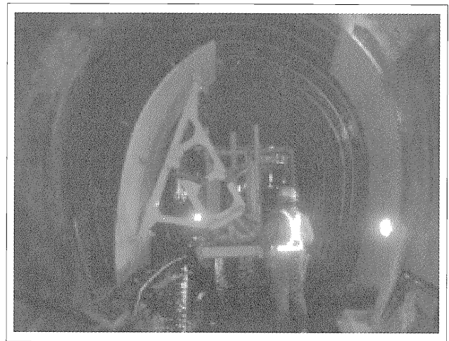
写真-5 パネル組立て状況
