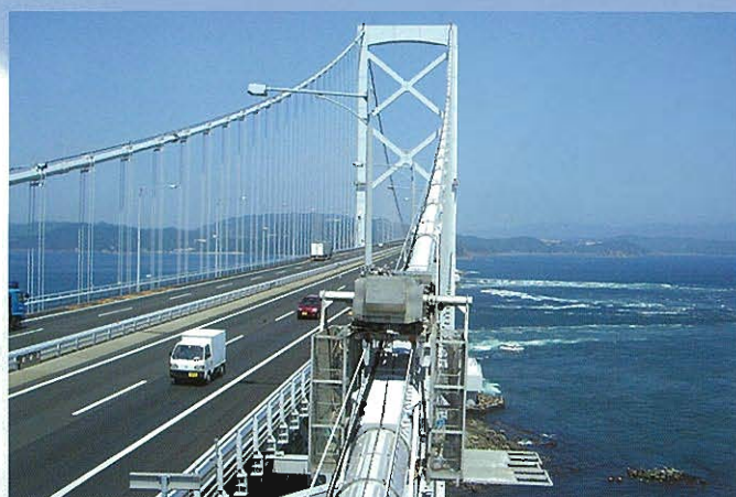
⇩大鳴門橋:ケーブル作業車
