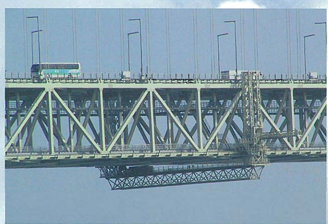
⇩明石海峡大橋:橋梁点検補修作業車(桁外面作業車)による点検
