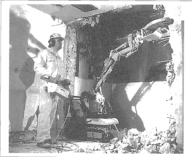
写真-21 電動式遠隔解体装置（ユアサ商事）
