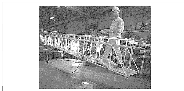
写真—8 作業床の平衡保持状況
