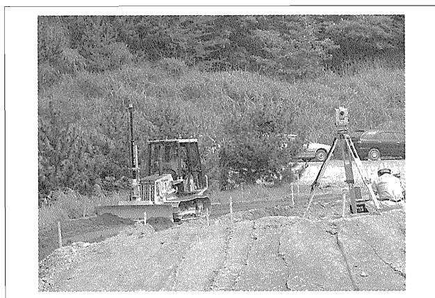
写真-5 トータルステーション(右)と6トン級ブルドーザ(左)の自動追尾によるコントロール
