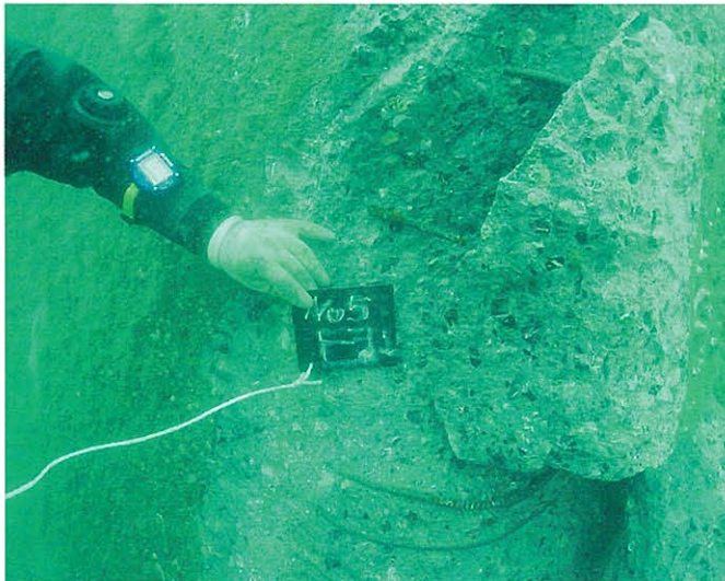
⇨NO.5 ケーソン砕岩状況
