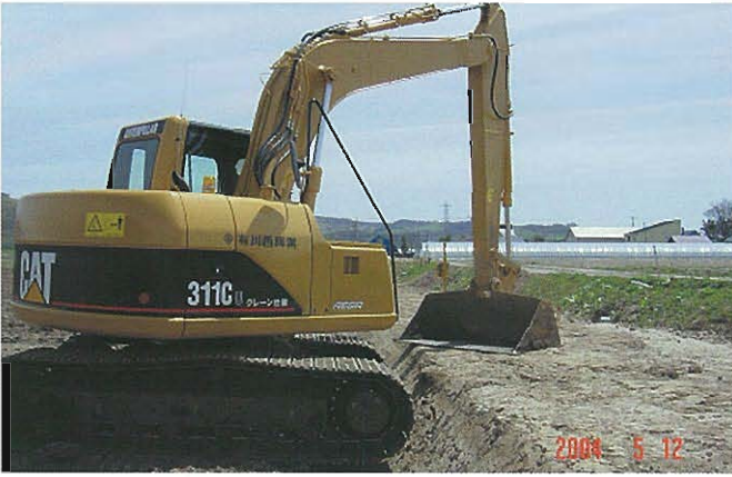
⇩ 畦畔造成における天端の均平化
