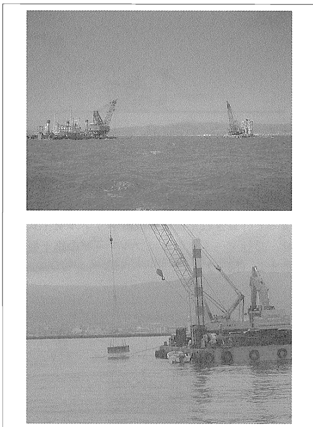
図-11 ケーソン撤去状況
