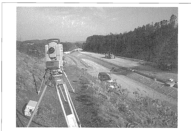
写真-1 情報化施工の路盤整正作業
