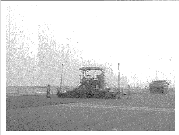
写真-4 mmGPS-MC アスファルトフィニッシャの施工状況
