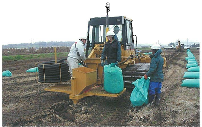
⇩ 新しい暗渠排水工法（ベスト・ドレーン）
