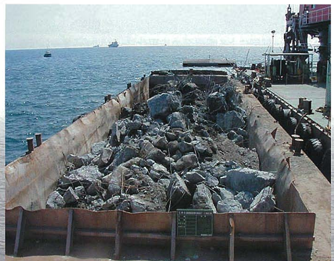
⇨バージ船積込状況(砕岩したケーソン)
