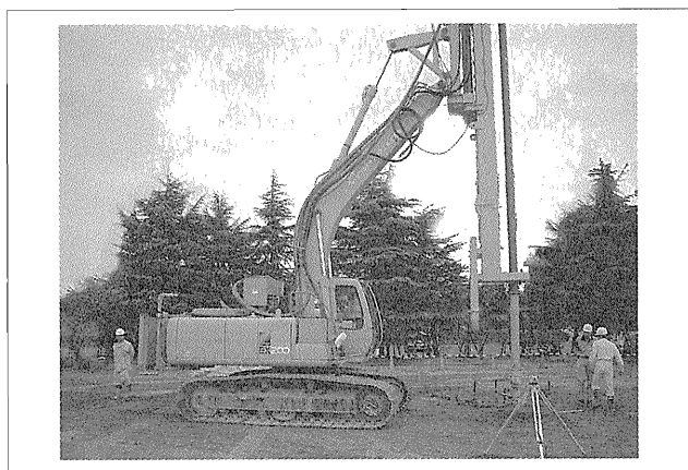
写真-4 土壤浄化状況
