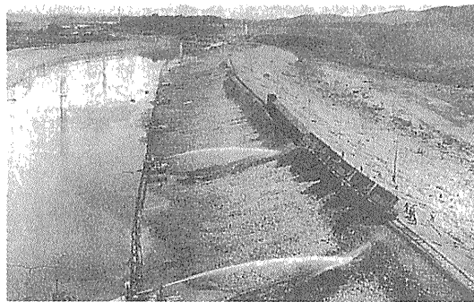
写真—4 台車の転倒作業とジャイアントポンプによる射水作業 （古川勝三著「台湾を愛した日本人」より転載）
