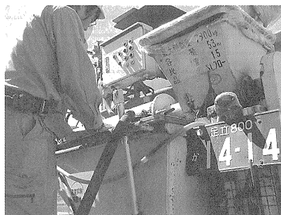
写真—8 ローリ車によるモルタル圧送
