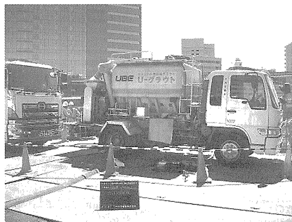
写真—7 ローリ車によるモルタル製造
