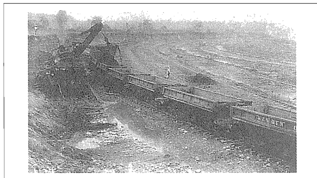
写真一7 スチームショベルによる大内庄での土砂採取現場 (古川勝三著「台湾を愛した日本人」より転載)
