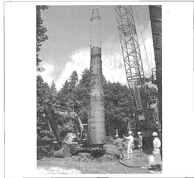
写真-4 掘起こし杭
