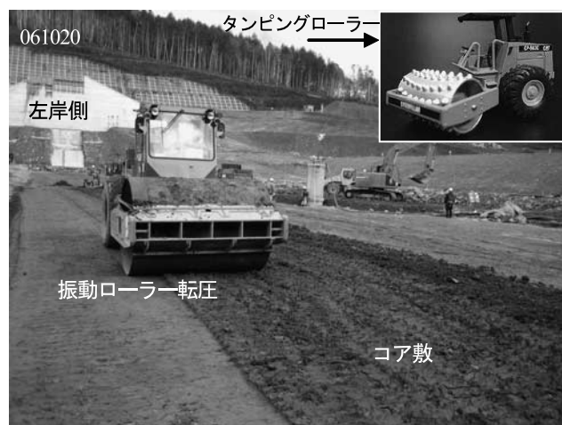
写真一17 振動ローラーコア部転圧、西岡ダム
