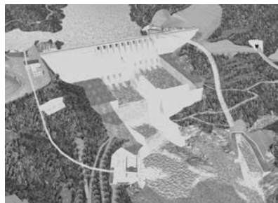
⑬ 本体工事5年目（洪水期）
