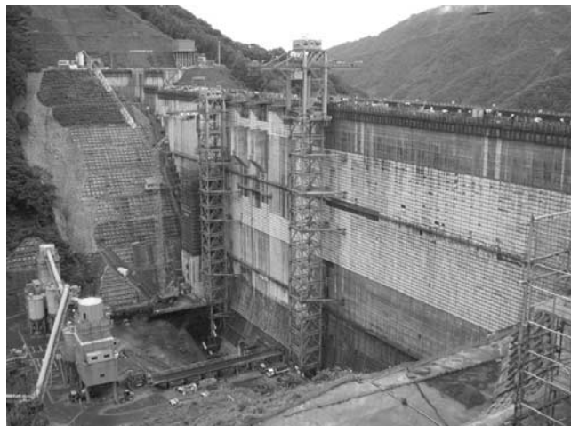
写真—1 堤体高標高部の打設状況 (右岸側テルハ型クレーンのみ稼働)
