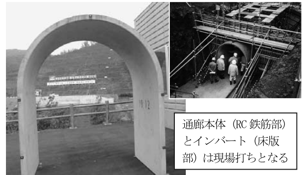
写真—20 通廊用プレキャスト型枠、梶谷ダム
