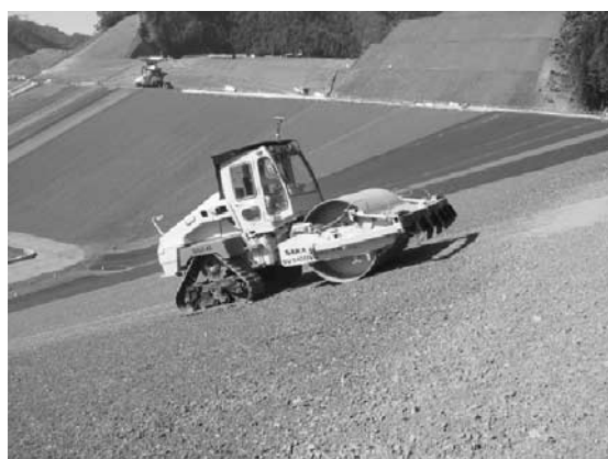
写真ー3 締固め管理システム搭載の斜面用ローラ
