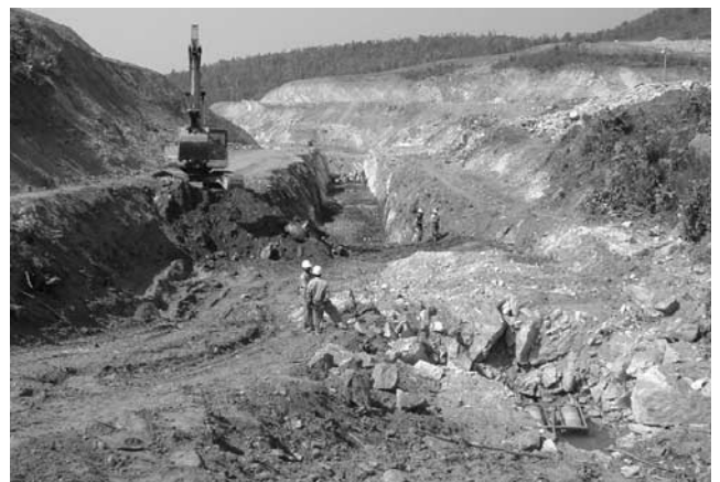
写真—1 掘削状況（上流側より下流を望む）
