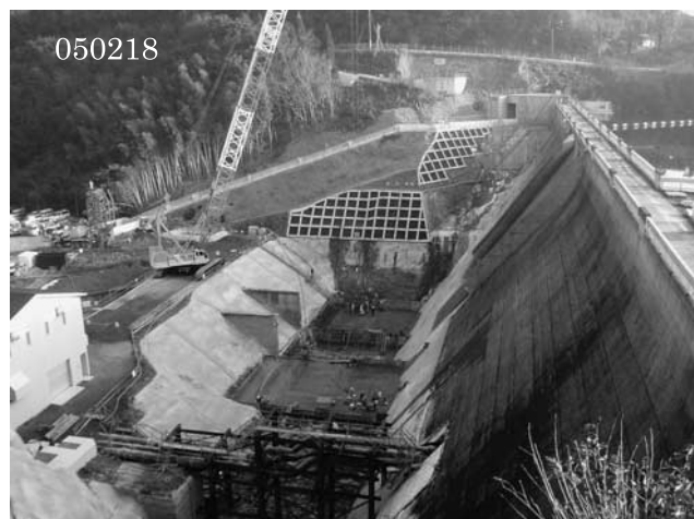
写真—26 堤体嵩上げ高5.9m, 下の原ダム
