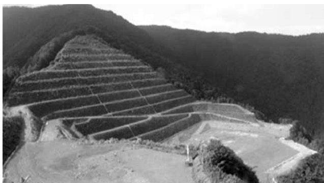
写真一 原石採取工
