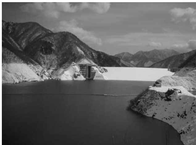
写真—1 試験湛水状況
