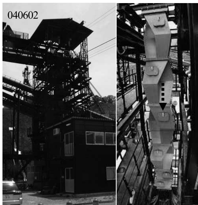
写真—11 木戸ダム、左：コンクリート連続練りシステム、右：重力式ミキサー
