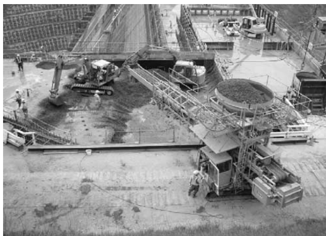
写真—6 スプレッダコンベヤによる打設状況
