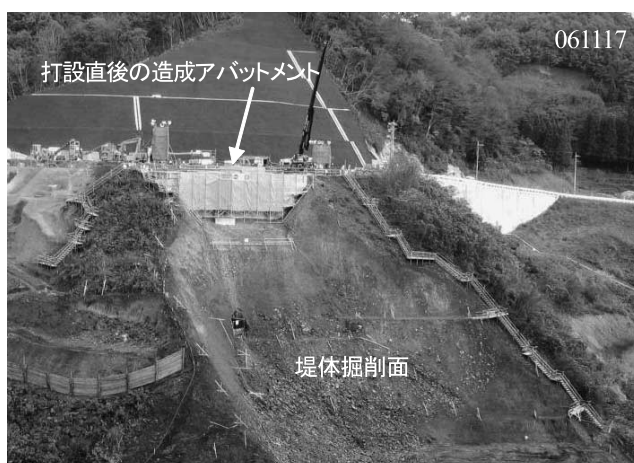
写真二 標準型造成アバットメント、北河内ダム
