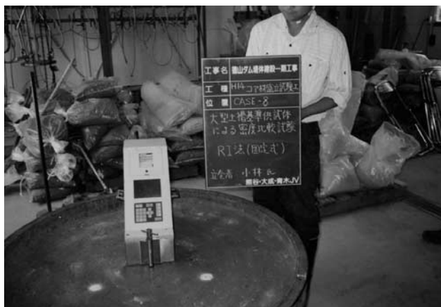
写真—7 固定式 RI による現場密度試験
