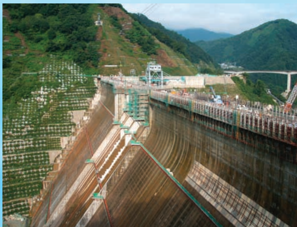
⇩ 打設完了間近の堤頂部施工状況
