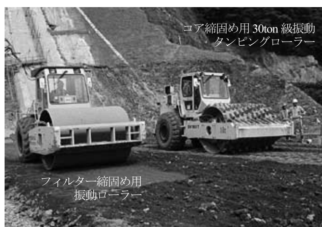
写真一18 締固め用振動ローラー、徳山ダム
