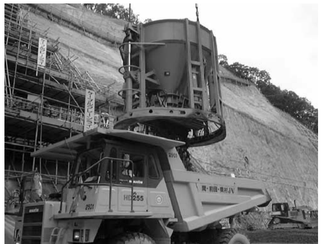
写真—4 自重蓄圧開閉方式 9 m 3 油圧バケット
