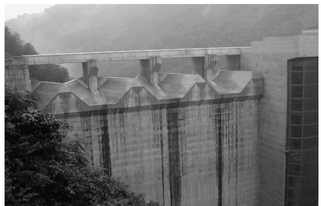
写真一25 ラビリンス型越流頂の上流側、苫田ダム
