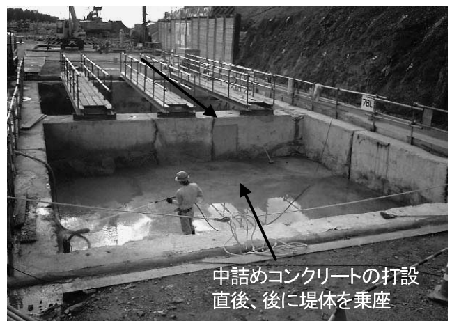
写真五 箱型連続地中壁、岩井川ダム右岸
