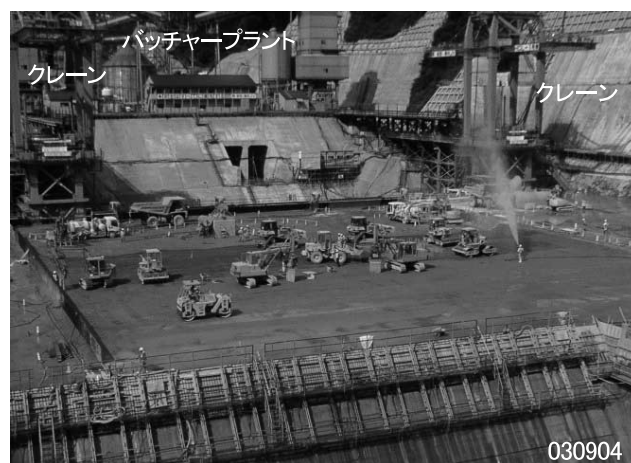
写真—8 連続 RCD 工法による打設、長井ダム
