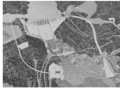
②仮排水路トンネル
