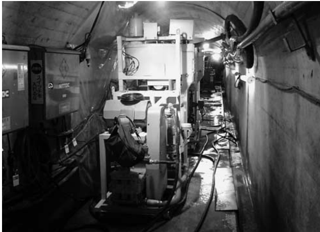
写真一 リムトンネル内ユニット設置状況
