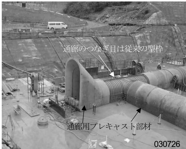
写真一 14 プレキャスト通廊，木戸ダム
