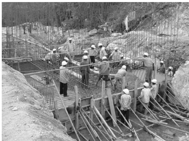
写真—6 コンクリート打設状況
