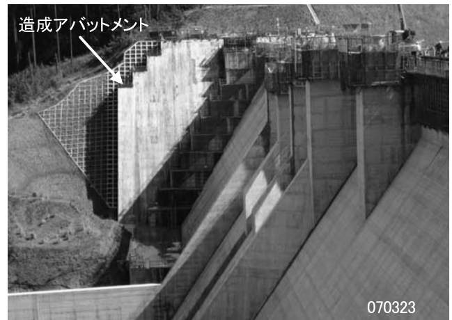
写真三 傾斜型造成アバットメント、稲葉ダム
