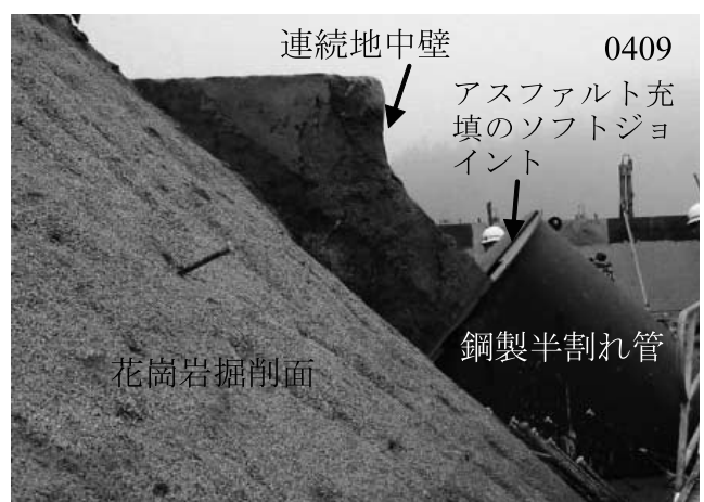
写真四 連続地中壁、小山ダム
