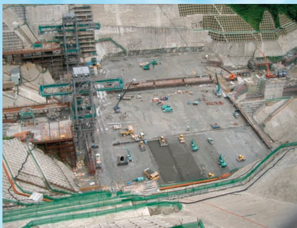
⇩ 低標高部の RCD 工法施工状況 (全平面を 3～4 分割, 打込厚 1.0 m)
