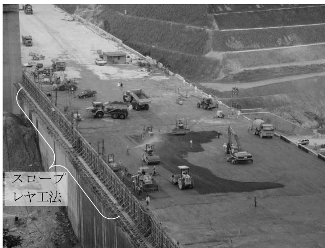
写真—9 RCC 工法，スンガイキンタダム
