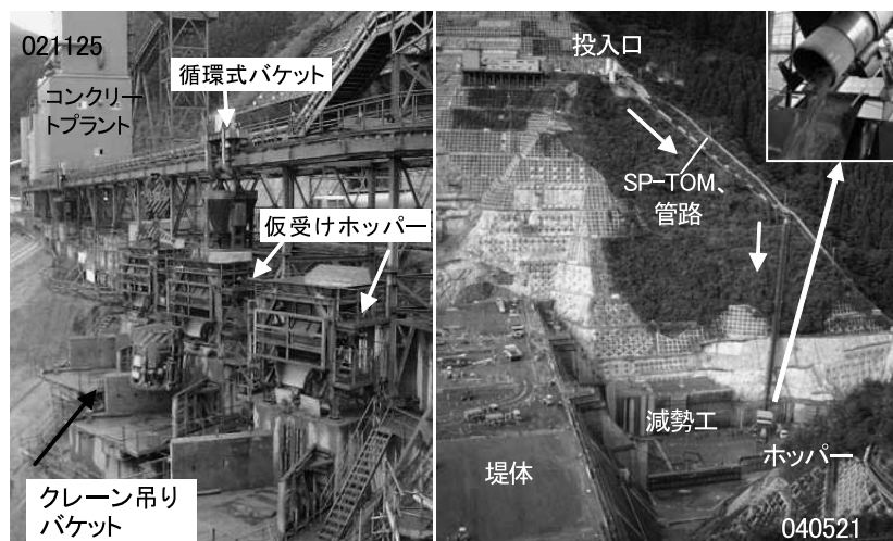
写真—12 滝沢ダム、左：複雑な動きを自動化した循環式の3連バケット、右：スパイラル式コンクリート連続運搬システム
