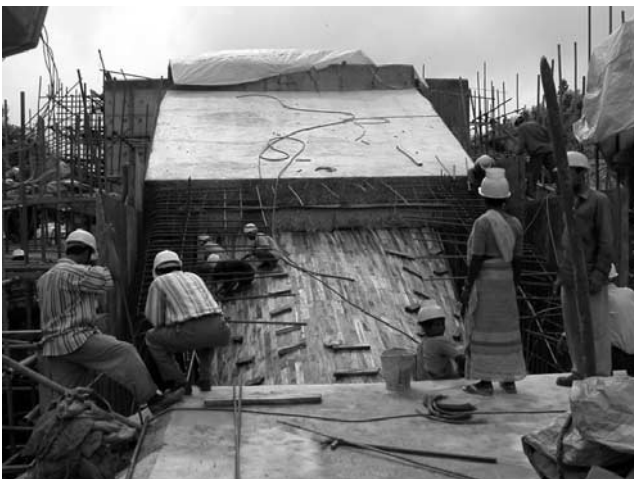
写真—8 セントル漸変部
