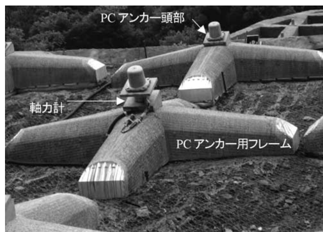
写真—7 PC アンカー工、奥胎内ダム
