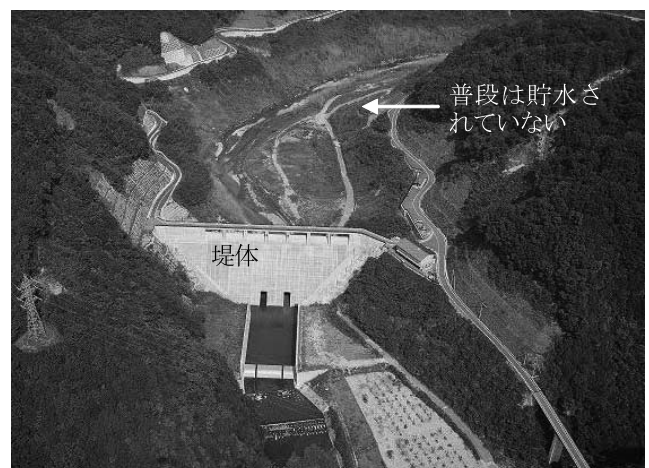
写真—29 河床穴あきダム，益田川ダム
