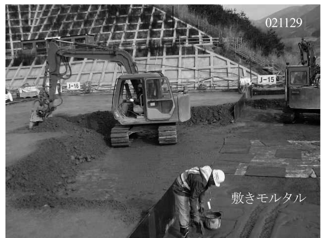
写真—10 拡張レヤ工法，鷹生ダム
