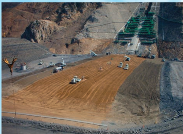
⇩低標高部の盛立施工状況
