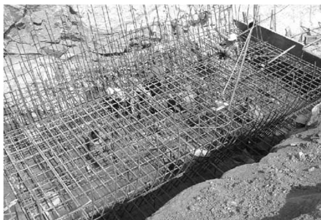
写真—4 打設前清掃状況
