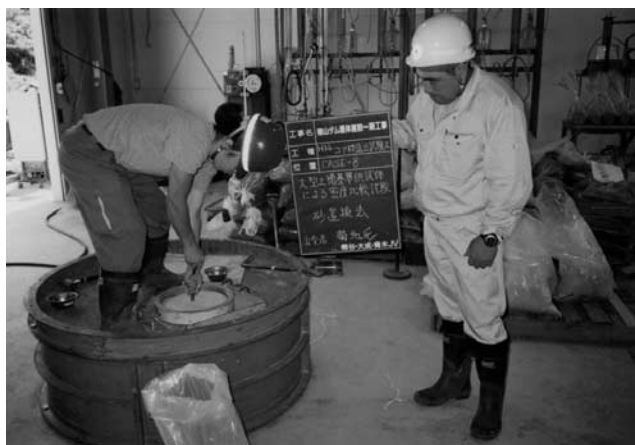
写真—6 砂置換法による現場密度試験
