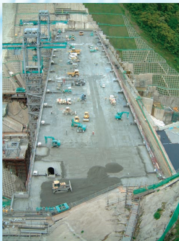
⇩ 全面連続打設の RCD 工法施工状況 (全平面を分割なし, 打込厚 0.4 m)
