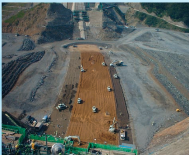
⇩中標高部の盛立施工状況
