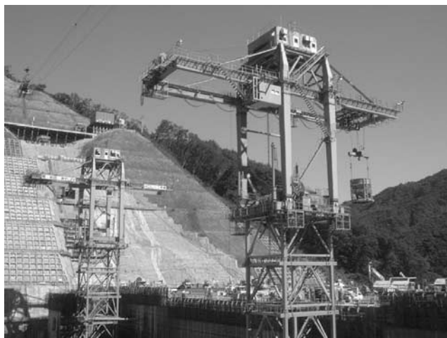
写真—2 テルハ型クレーン2基による打設状況
