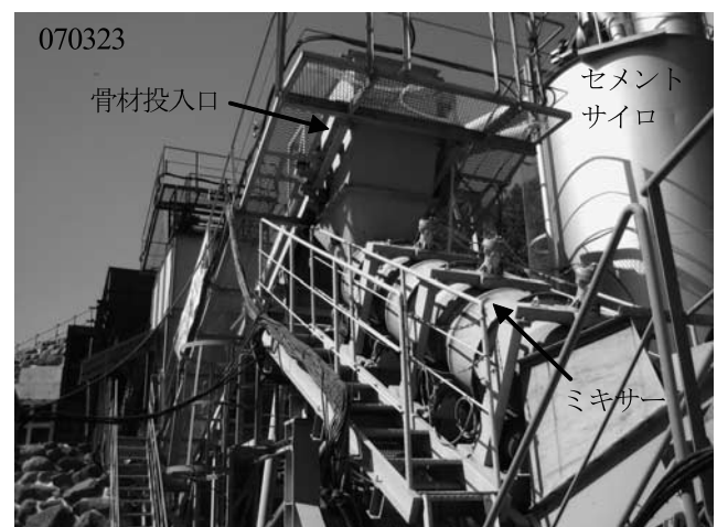
写真一 15 スパイラル式 CSG ミキサー，稲葉ダム
