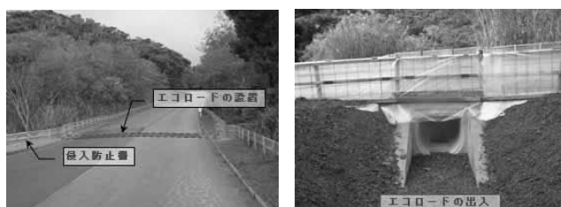
写真—2 エコロード設置状況
