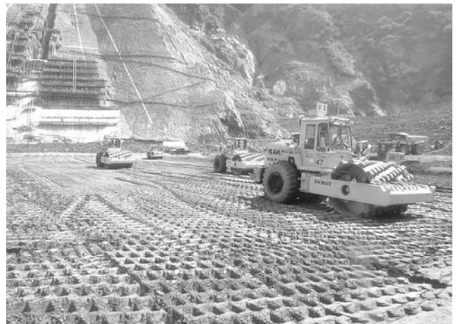
写真—3 18t級振動タンピングローラ
