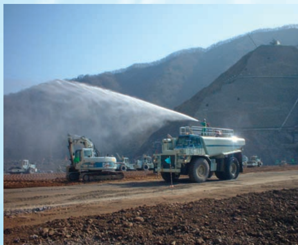
⇩コア盛立面の散水状況（CAT773 改造車）
