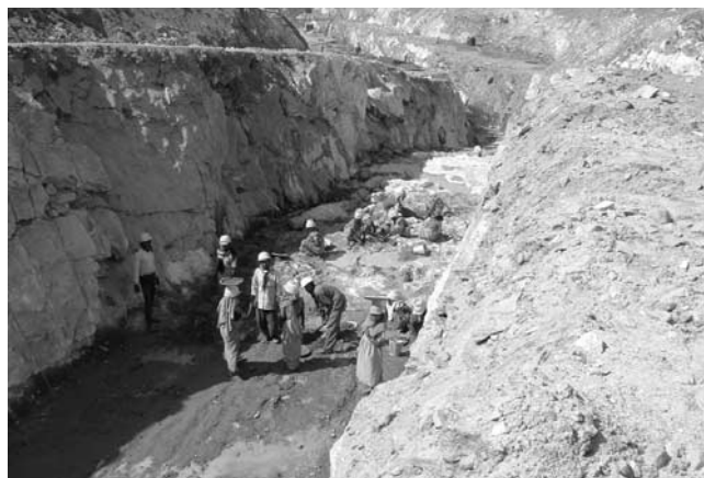
写真—3 岩盤清掃状況
