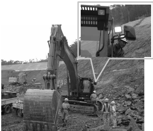
写真—4 重機安全ライト設置状況
