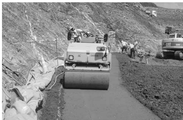
写真—5 4t 級振動ローラ
