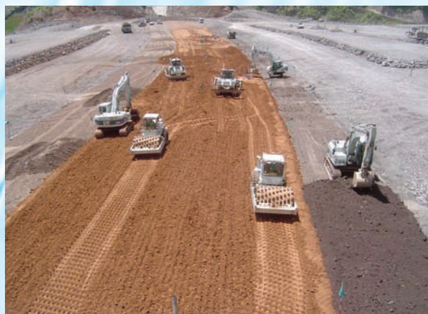
⇩コア材の転圧施工状況
