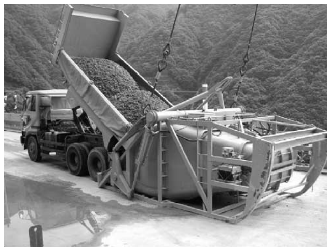
写真—5 水平バケットへのコンクリート積替え
