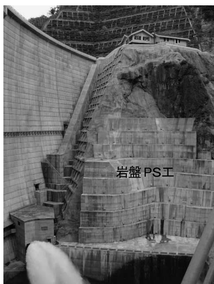
写真—6 岩盤 PS 工、奥三面ダム
