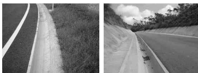
写真—1 小動物保護型側溝
