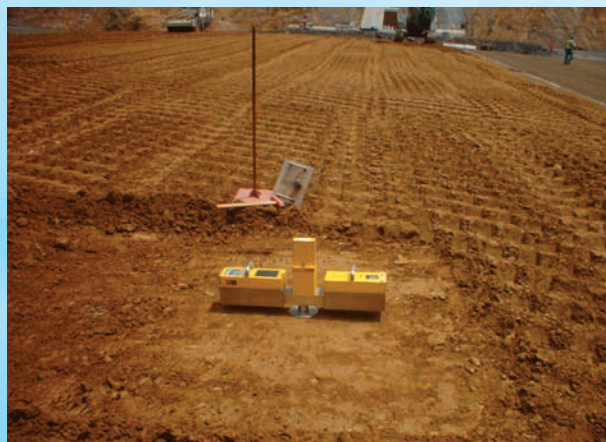
⇩コア盛立面 RI 計測状況
