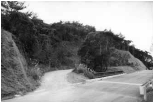
写真—7 着手前状況
