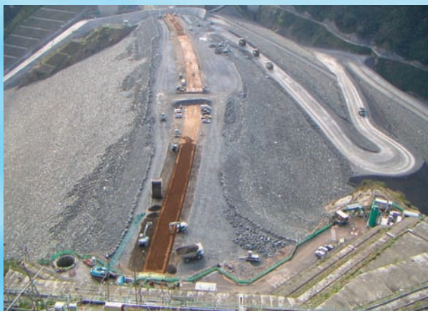
⇩堤頂部の盛立施工状況
