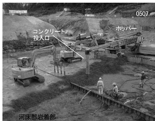
写真—13 自走式ベルトコンベア打設機、徳富ダム
