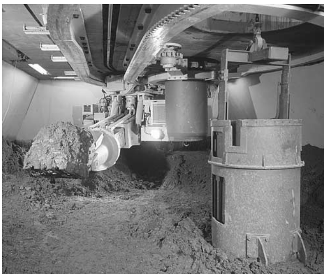
写真—3 底開バケット式土砂積替え装置
