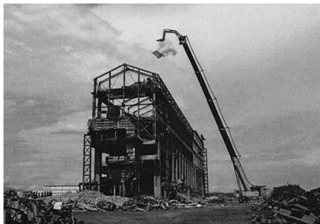
写真—4 鉄骨造建屋解体状況
