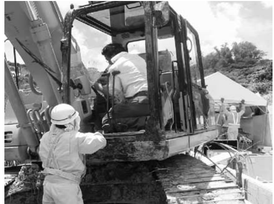
写真—5 現場でのロボ Q 組立状況
