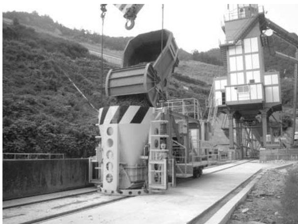
写真—1 トランスファーカによるコンクリート積込状況（自動運転）
