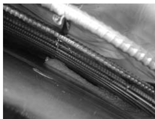
写真—3 打設状況
