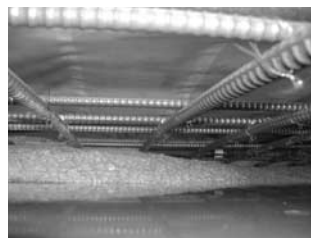
写真—4 圧入状況
