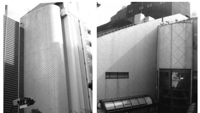
写真-4 強い曲率の壁面（左）と傾斜パラペットの壁面（右）
