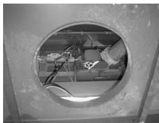
写真—1 アーチ部吹上げ口
