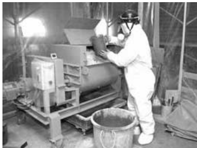
図―6 固型化作業（混練）
