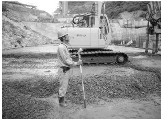
写真—2 コンクリート打設位置指示状況
