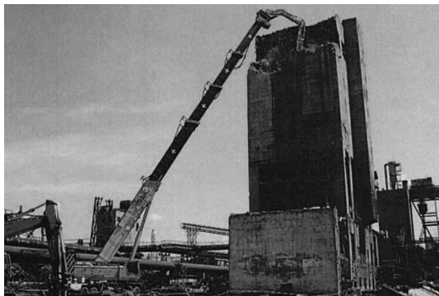
写真—5 コークス装入炭槽解体状況
