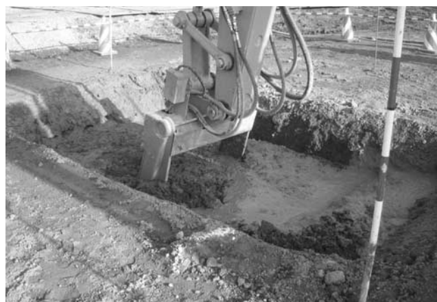
写真三 地盤改良状況
