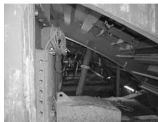
写真—2 アーチ部吹上げ口全景
