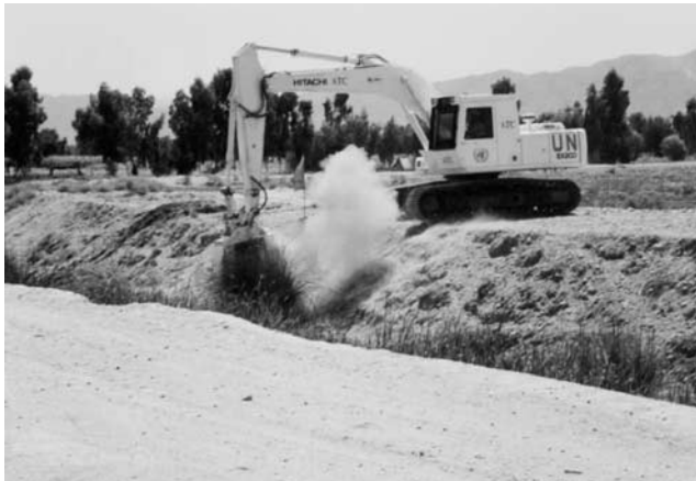
写真—2 河川の法面部の地雷の撤去
