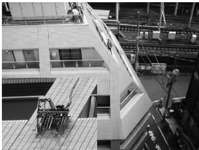
写真—2 斜壁におけるロボット診断
