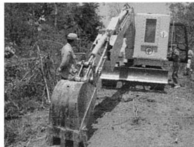
地雷原への進入路を建設中
