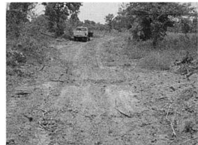
建設された進入路
