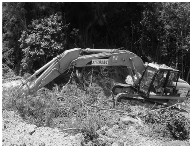
写真—4 沖縄県中城村での災害復旧状況
