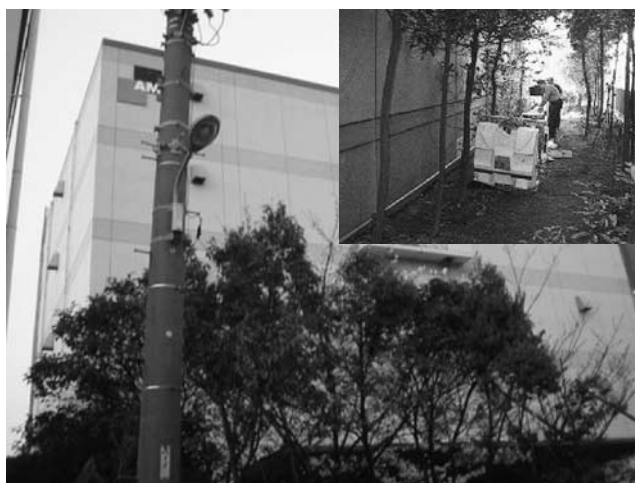
写真—1 木立に囲まれた物件におけるロボット診断
