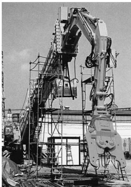
写真—3 ロボットアームおよび油圧破碎機
