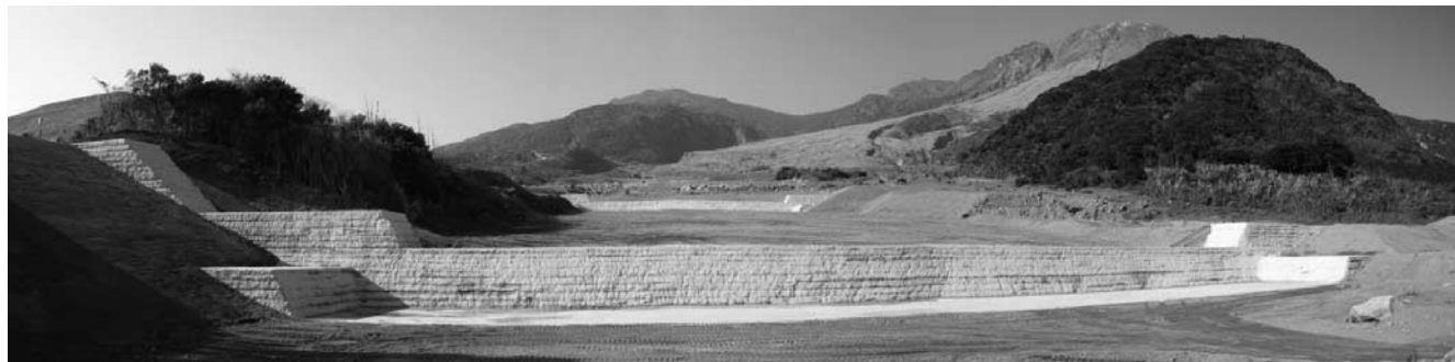
写真—1 赤松谷川1号床固工
