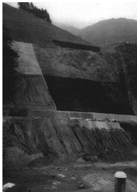
写真—1 大規模な法面の例
