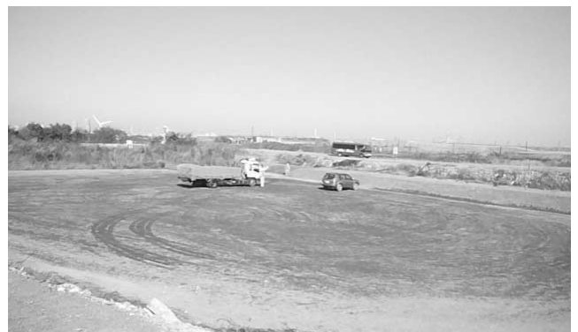
図—5 東京都中央防波堤外側埋立処分場
