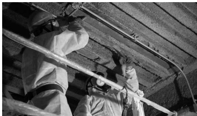
図—1 アスベスト除去工事
