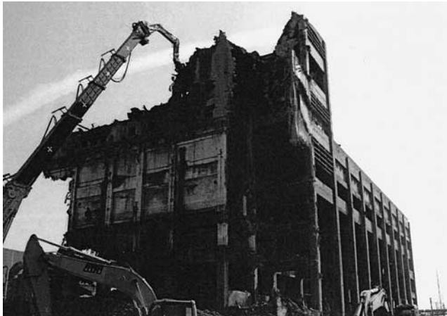
写真—6 燃結工場解体状況
