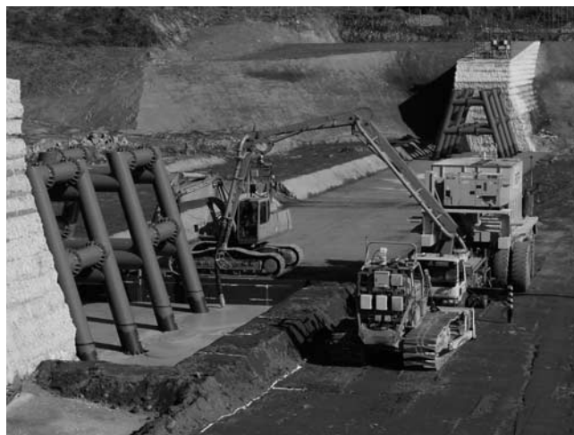
写真—6 アジテーター機能を具備した無人コンクリート運搬車と無人ポンプ車による高流動コンクリート打設
