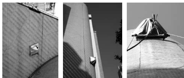
写真—5 施工状況 (左：傾斜パラペット部、中央、右：曲面部)
