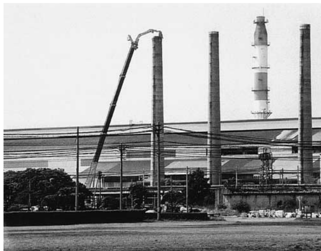
写真—1 親日鐵八幡旧 1 分塊均熱炉煙突 RC 造 H = 55 m
