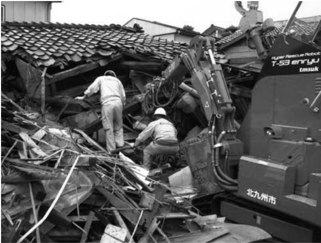
写真—8 “53” による安全確保
