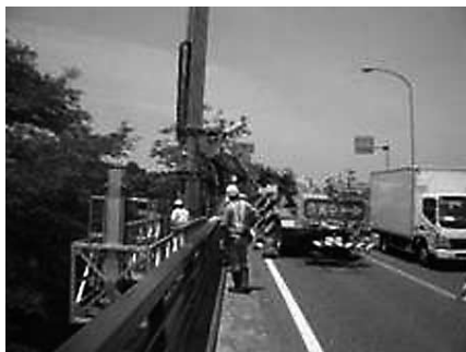
写真—10 橋梁点検車による緊急点検状況
