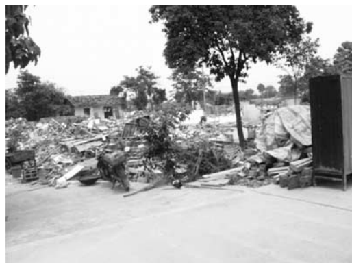
写真—4 郊外の被害の様子 (綿竹市)
