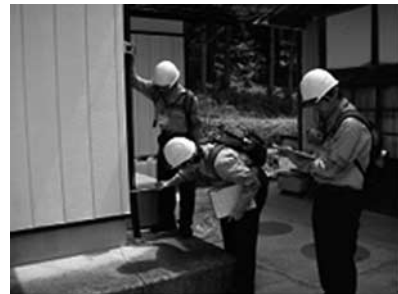
写真—7 被災状況調査班（建築）による調査状況
