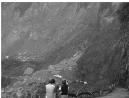
写真—8 都江堰郊外の山間地での土砂崩れ落石
