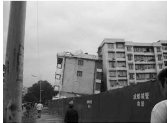
写真—1 倒壊した建物（都江堰）
