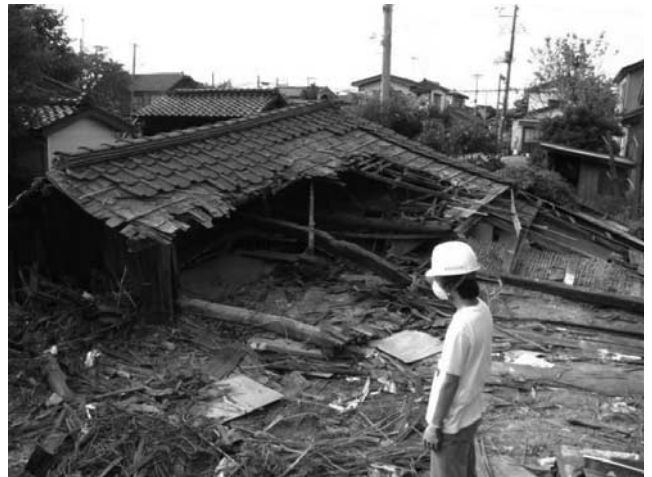
写真—10 作業終了時の倉庫 B
