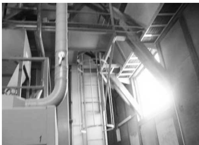
写真—4 被害のなかった精米工場
