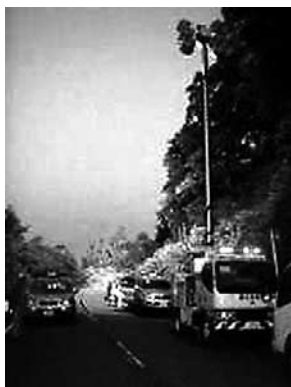
写真—11 照明車による夜間作業支援
