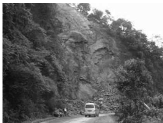
写真—7 都江堰郊外の山間地での落石
