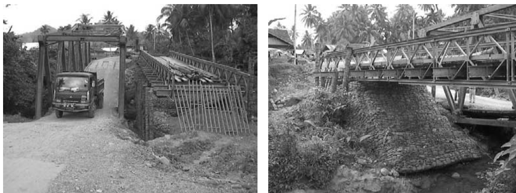
図—6 ニマス島沖地震で沈下したトラス橋梁：この橋梁の脇に建設中の橋の基礎がまた滑っている(右)。この問題への技術指導に対しニマス県知事から礼状(写真提供：飛鳥建設技術研究所 三輪滋氏)
