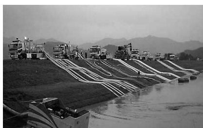
写真二 ポンプ車による緊急排水
