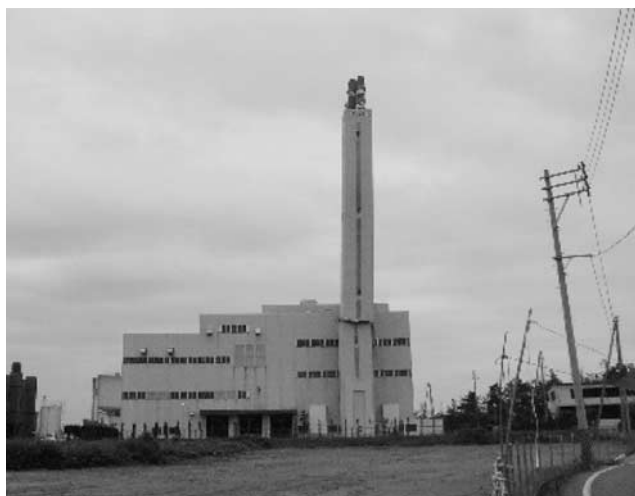
写真—7 折損したごみ焼却場の煙突 (柏崎市提供)
