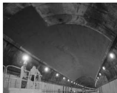
写真—17 炭素繊維による補強状況
