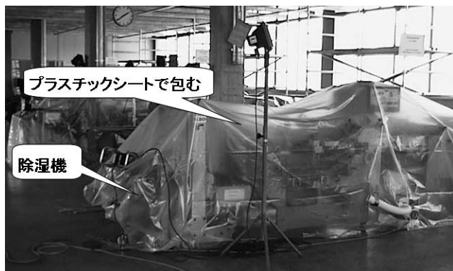
写真—4 汚染した機械の除湿
