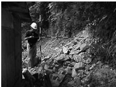
写真—5 被災状況調査班（土砂災害危険箇所）による調査状況
