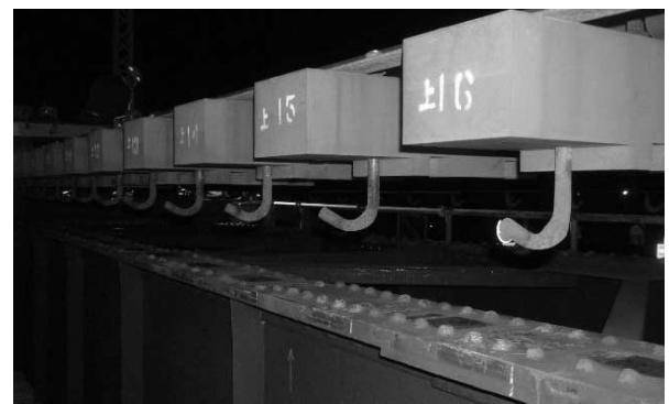
写真—5 軌道扛上完了
