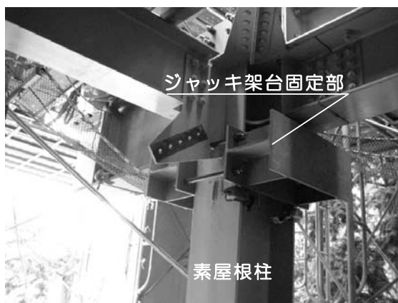
写真-10 ジャッキ架台固定部詳細
