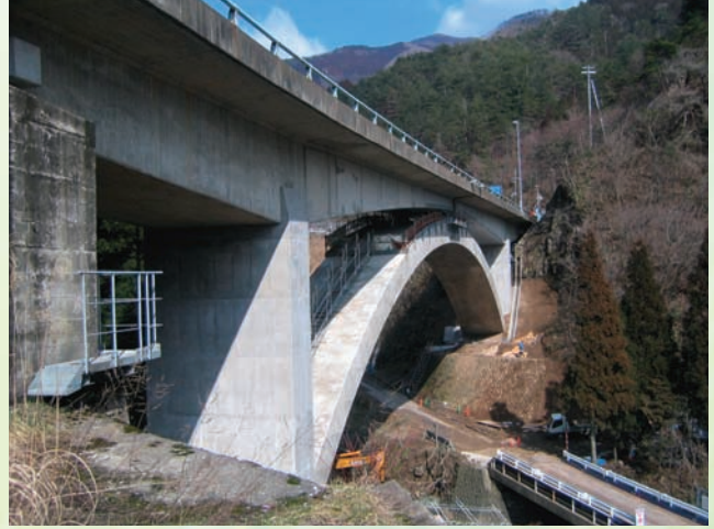
⇧アーチ完成状況その 2
