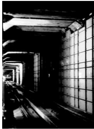
写真-3 囲い込み状況
