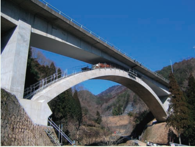
⇧アーチ完成状況その 1
