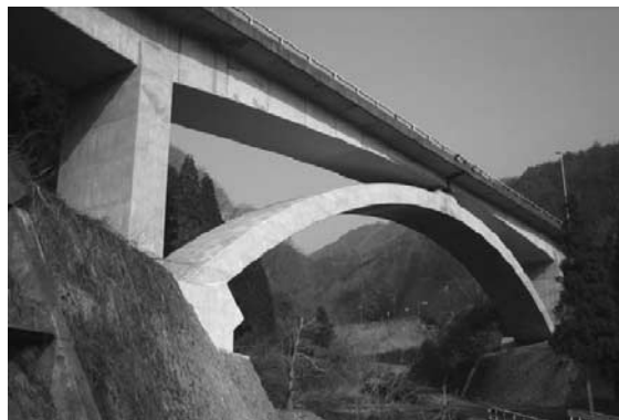
写真-6 完成写真
