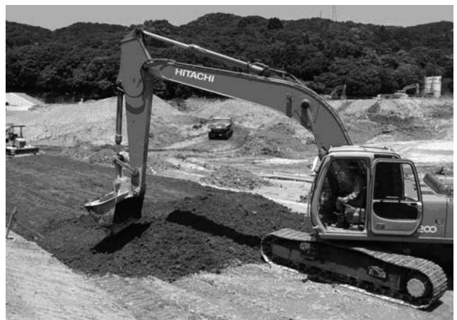
写真—4 解砕土層均一化のためのバックホウによる撒出し
