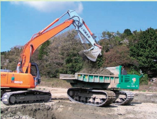
⇧ バケット式解砕機による初期固化土の解砕状況
