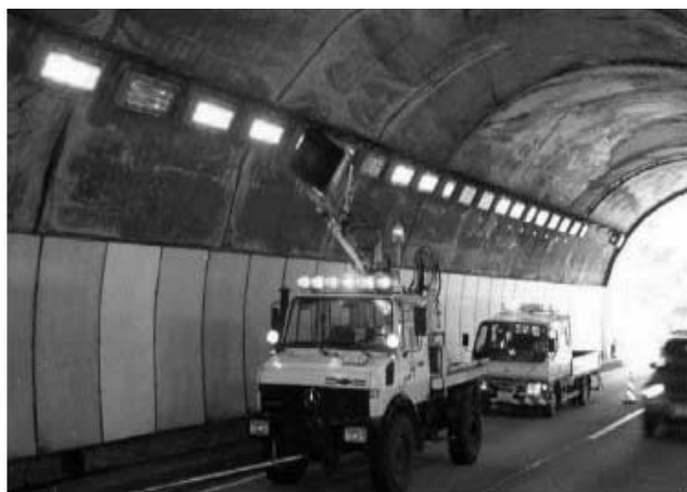
図一 1 トンネル照明器具の清掃状況
