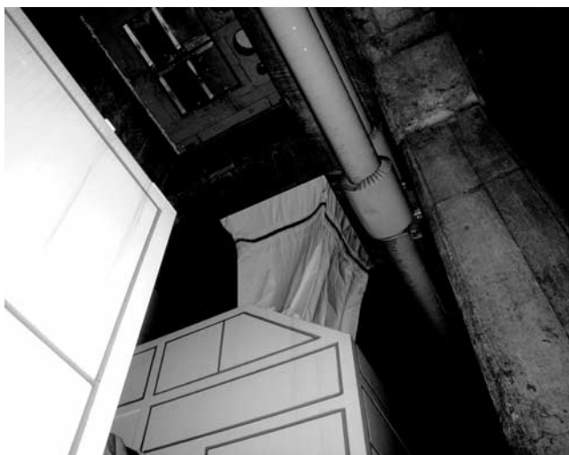
写真—6 縦型換気口養生シート接続状況
