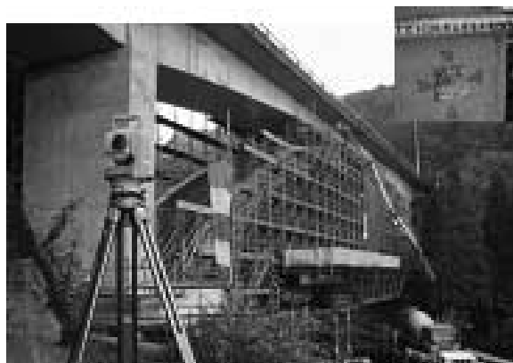
写真-5 動態観測状況
