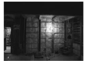
1階洋室の構造・断熱補強
