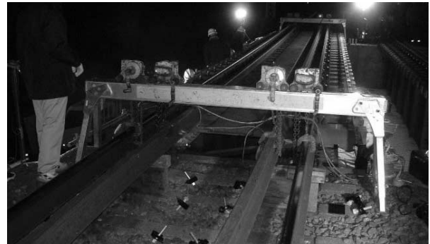
写真—4 軌道扛上状況
