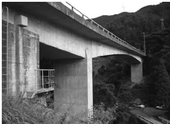
写真—1 矢井原橋アーチ補強前全景
