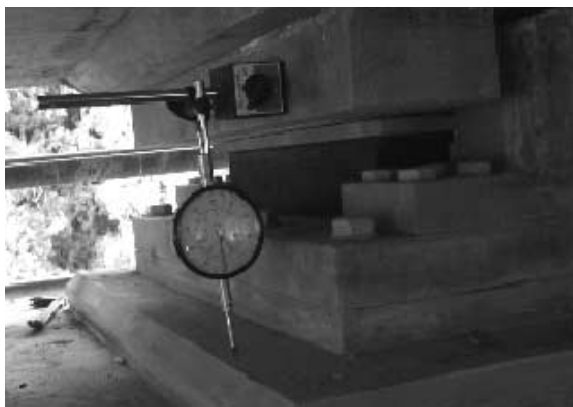
写真-4 計測状況
