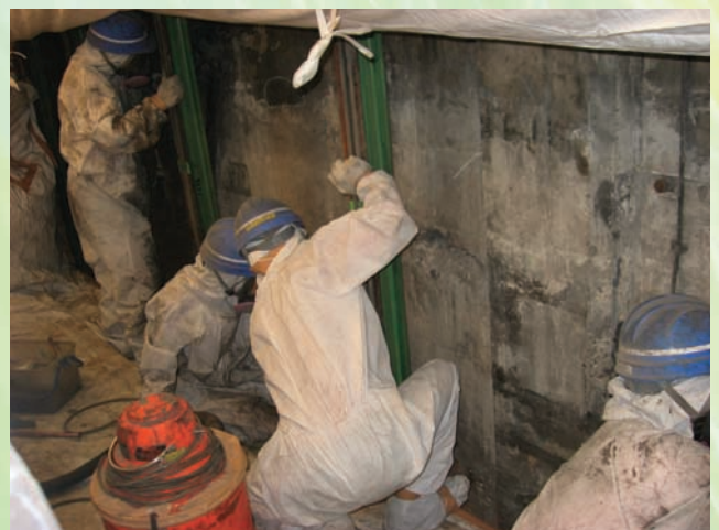
⇧ トンネル部石綿除去作業
