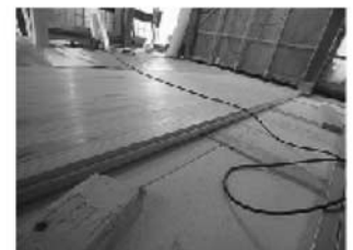
床材に45mmの杉板を使用
