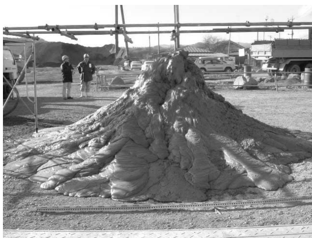
写真—2 試験施工状況（急勾配隔壁形成の確認）
