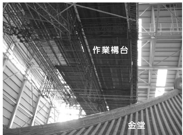
写真一4 作業構台
