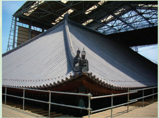
⇧素屋根解体により 8 年ぶりに日に当たる金堂
