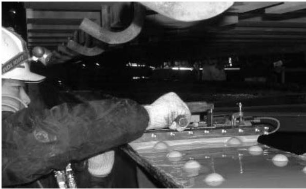
写真-7 ライニング状況
