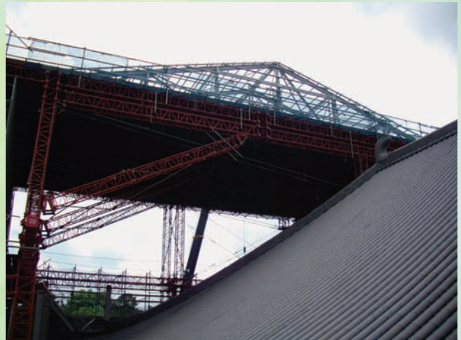
⇧作業構台上で素屋根解体状況
