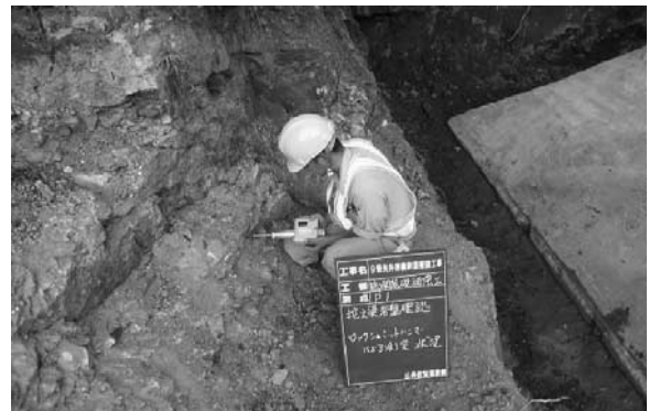
写真-2 岩盤確認
