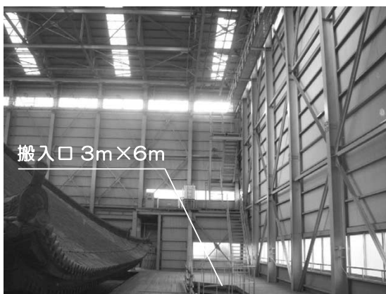
写真—12 内部部材搬入口
