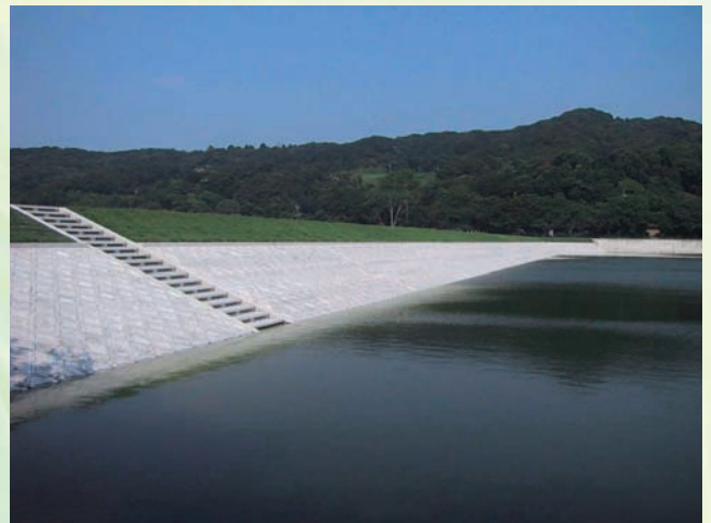
⇧ 耐震補強完了後の堤体上流側の状況
