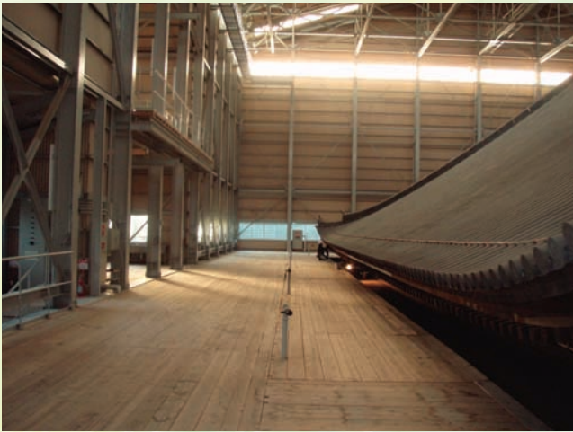
⇧素屋根解体前内部状況
