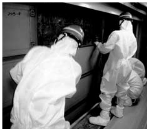
写真-5 囲い込みパネル撤去状況
