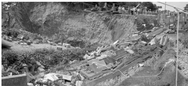
写真—1 陥没被害例（地下碎石場跡）
