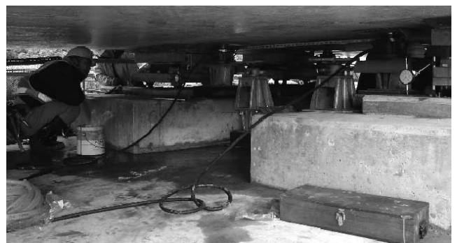
写真一三 ジャッキアップ状況
