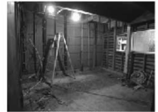
1階洋室の解体後の様子
