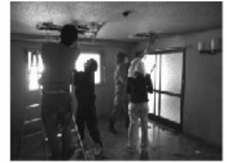
1階洋室の解体作業をする学生
