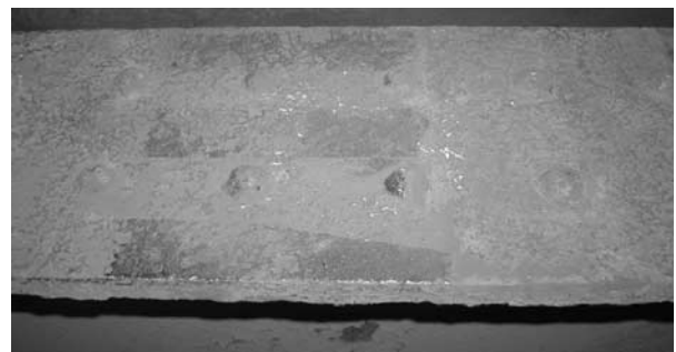
写真—6 下地処理完了
