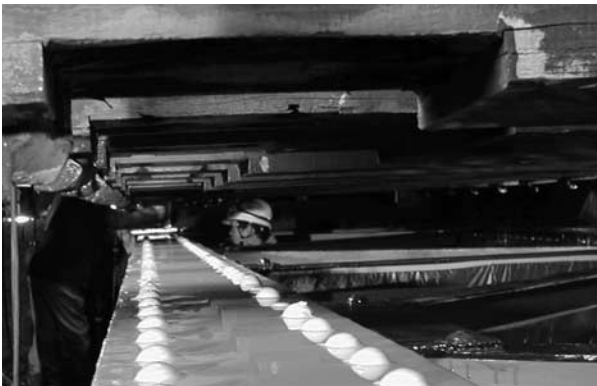
写真-8 ライニング完了
