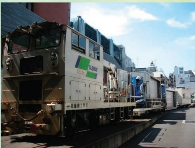
⇧ トンネル部石綿除去車両
