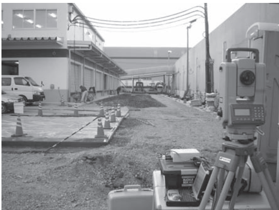
写真—4 一般駐車場舗装工事
