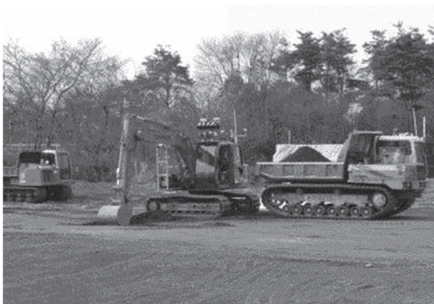
写真-2 掘削積込状況
