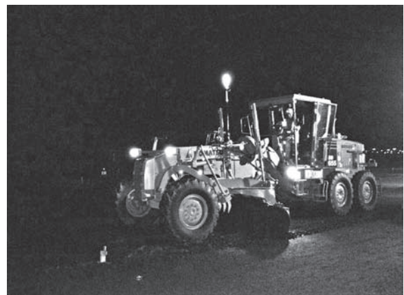
写真一7 3D-MC グレーダによる夜間工事
