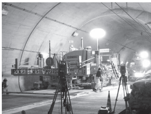
写真—12 施工状況
