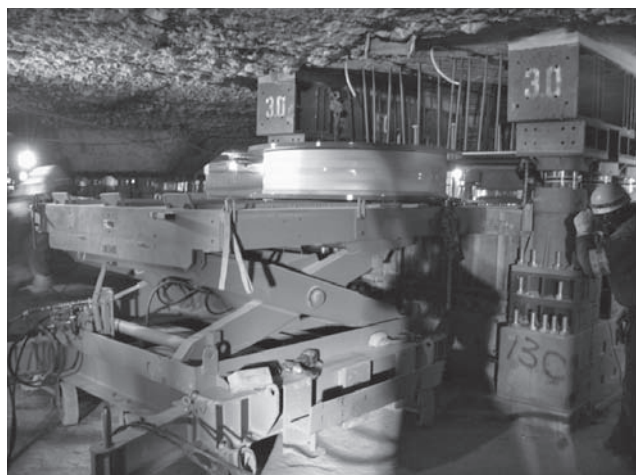
写真—6 免震装置据付
