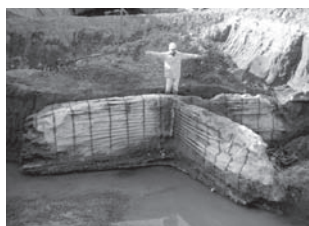
写真—2 口径仕様の3方向改良体
