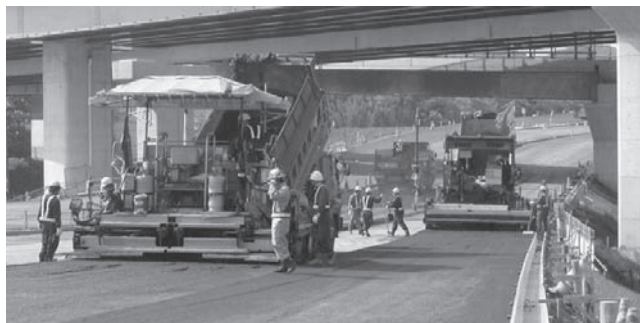
写真—8 3D-MC のフィニッシャへの応用
