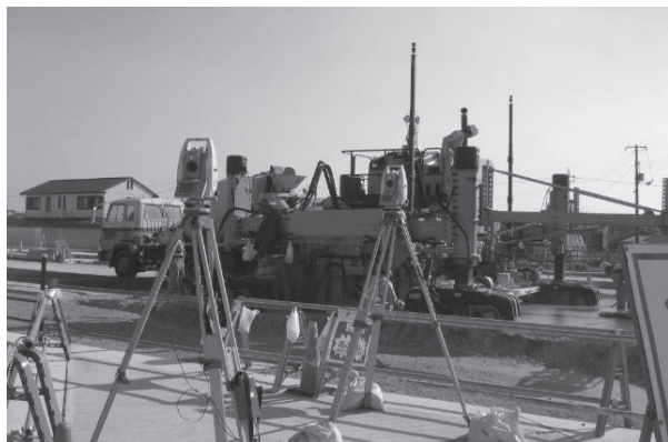
写真—9 施工状況
