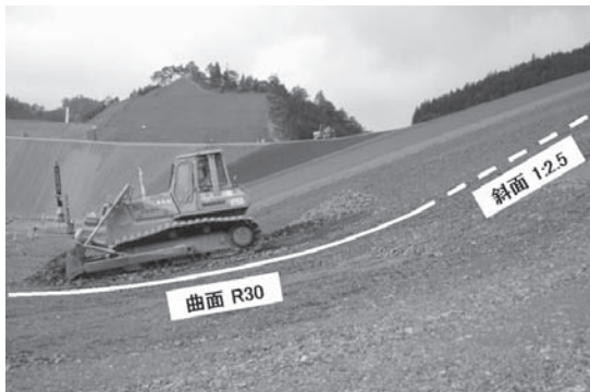
写真一5 3D-MC ブルドーザによる緩和区間の施工
