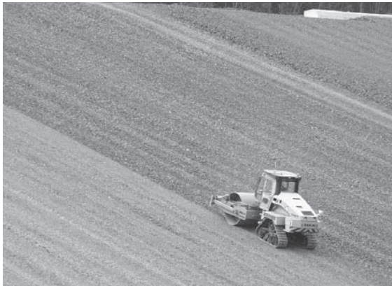
写真一4 転圧管理システムを搭載した法面ローラ
