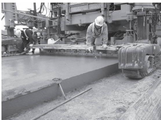
写真—10 出来形測定状況
