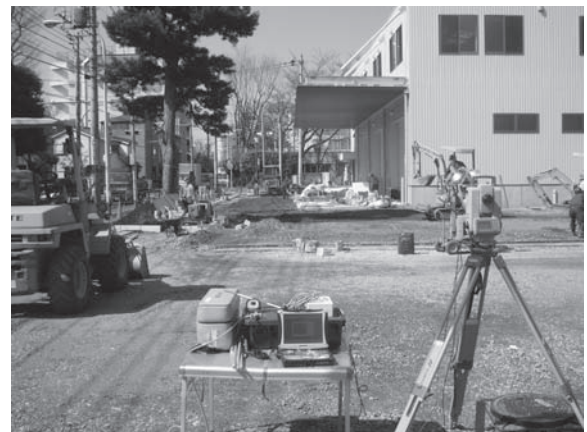
写真—6 倉庫外構舗装工事
