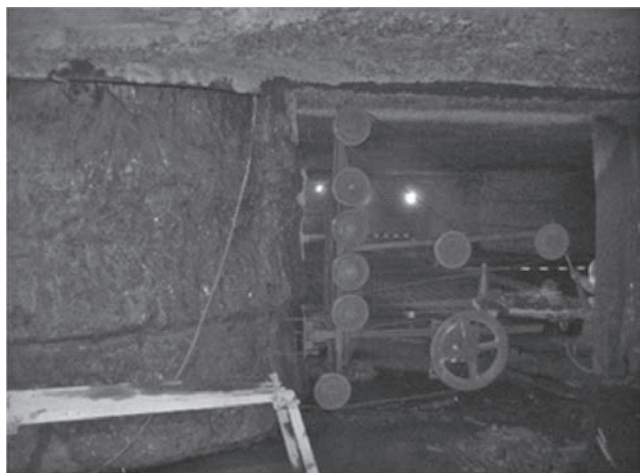
写真—2 ワイヤソーによる解体
