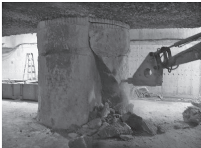
写真—4 油圧ブレーカによる解体
