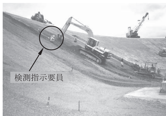
写真—1 法面整形作業
