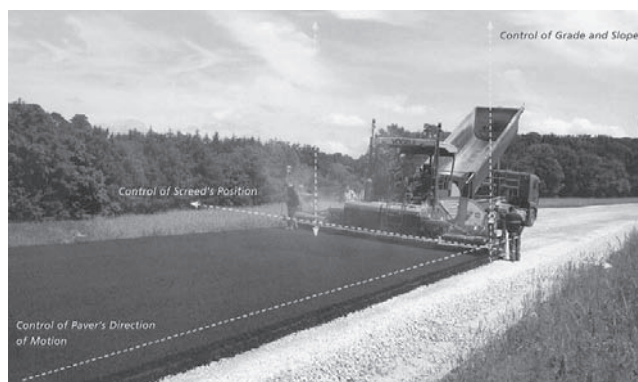
写真—9 ステアリング制御機能を備えた 3D-MC
