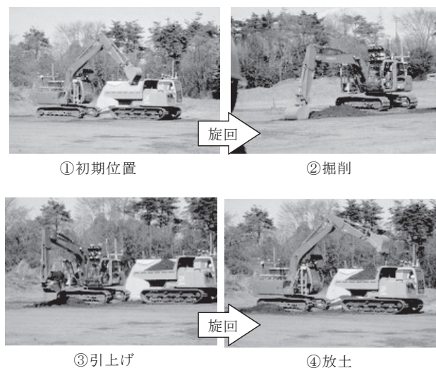
図一10 一連の掘削作業状況
