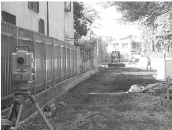
写真—3 一般通路舗装工事
