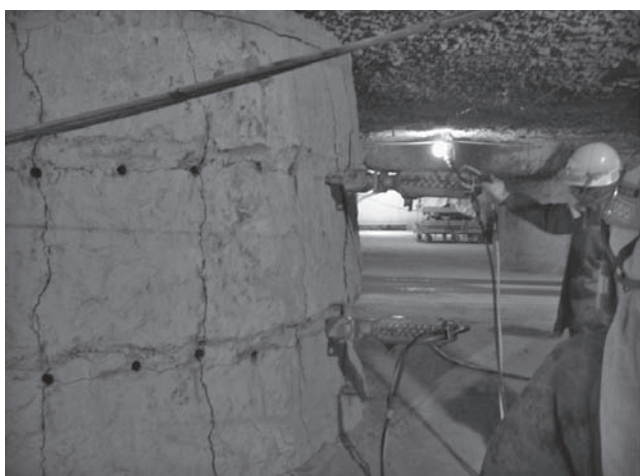
写真—3 ロックジャッキによる解体
