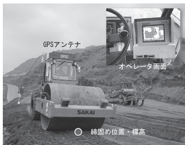
写真-1 GPS搭載振動ローラ
