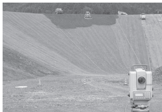
写真—3 TS-3D-MC ブルドーザの施工状況
