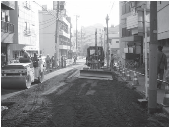
写真—2 路面補修工事
