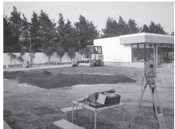
写真—5 コンビニ駐車場舗装工事
