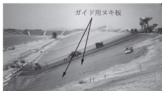
写真—2 法面に設置されたヌキ板
