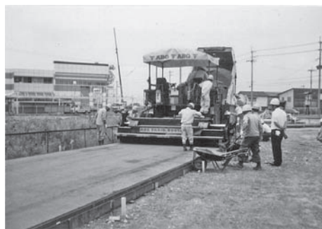
写真2—14 ABG(独) TITAN411 RCCP施工
