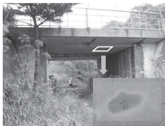
図-3 欠陥検出例
