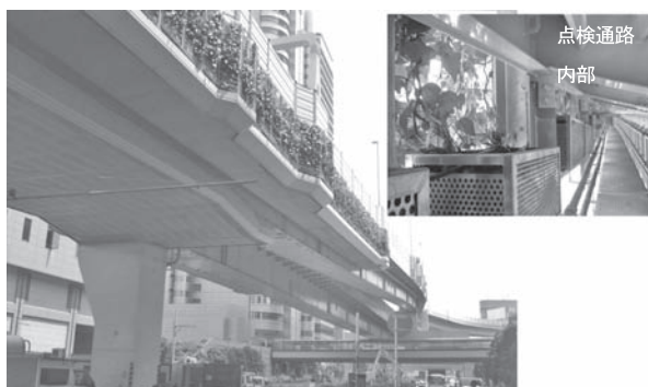
写真-3 西新宿ジャンクションの緑化（桁区間）
