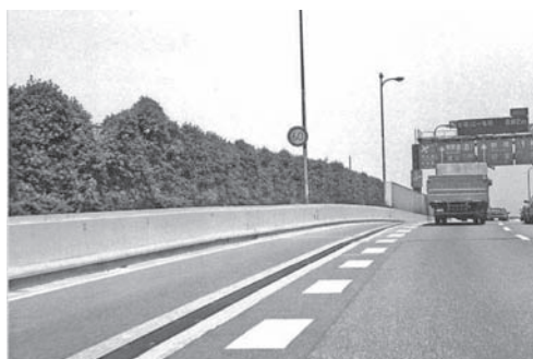
写真—2 1号羽田線高架部の緑化
