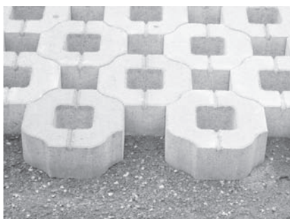
写真一4 ブロック敷設
