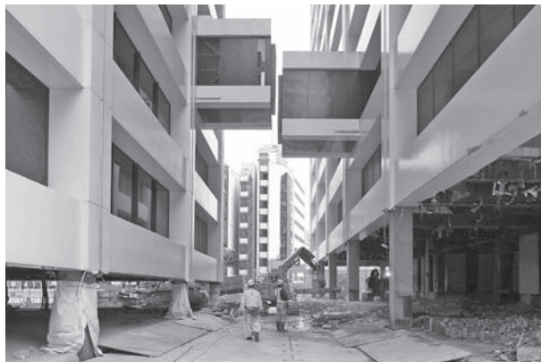
図ー2 ジャッキダウン中の渡り廊下
