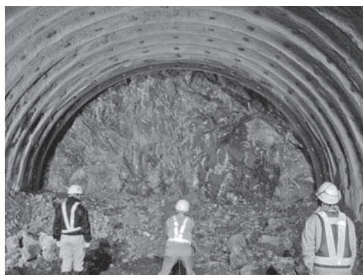
写真—2 南島 BP1 号トンネル
