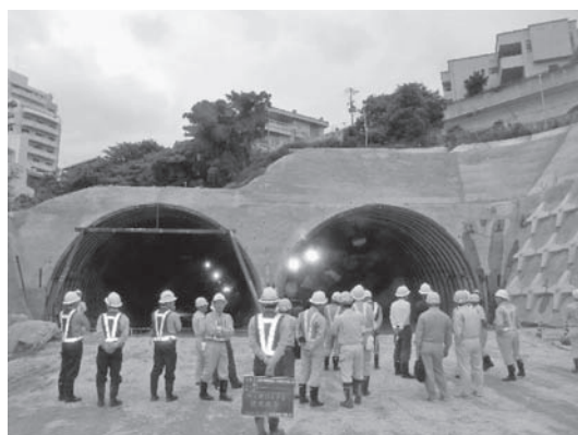
写真—3 識名トンネル
