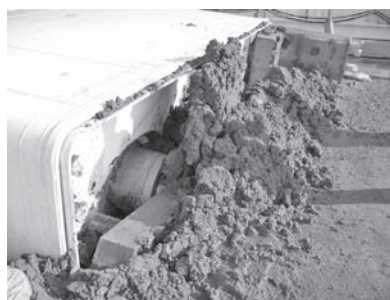
写真—4 アプローチ区間掘進状況
