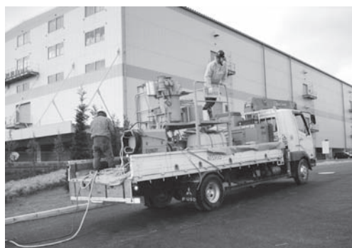
写真二 フォトリード工法施工プラント（トラック搭載部分）
