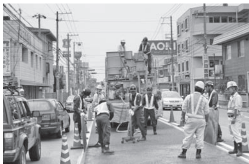
写真一 フォトリード工法施工状況
