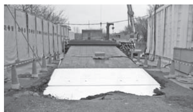
写真—5 地中貫入状況
