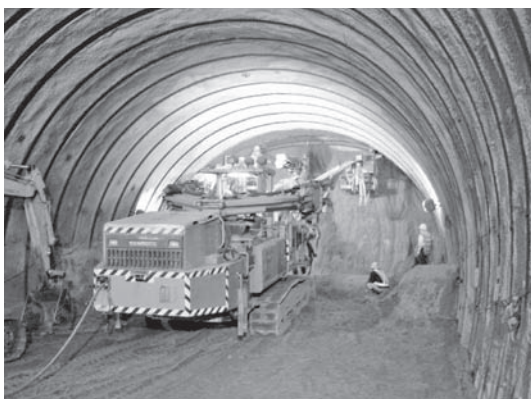
写真—5 新武岡トンネル
