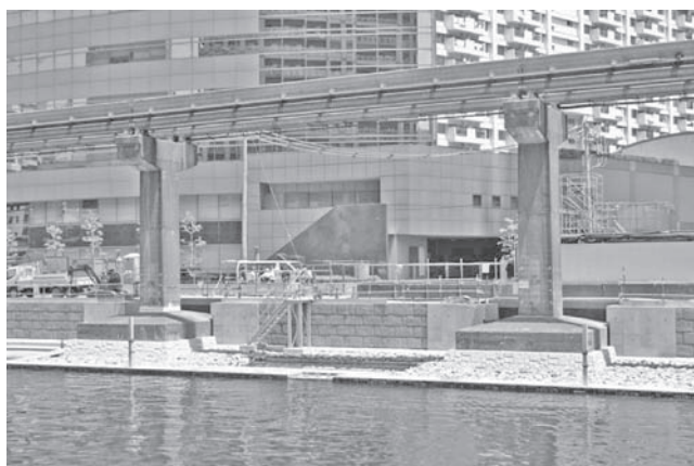
写真—3 カニ護岸設置箇所
