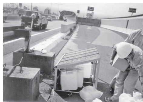
写真—3 高速道における NO x 処理量測定状況
