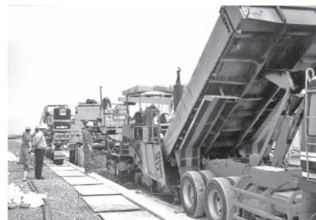
写真2—15 ABG(独) TITAN411 均しコンクリート施工、後方は表層スリップフォーム施工
