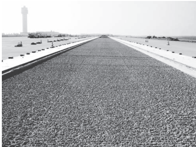
写真-2 表面処理が完了し、コンクリート打設前の状況
