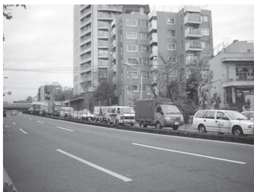
写真—5 施工後の状況 (都内)
