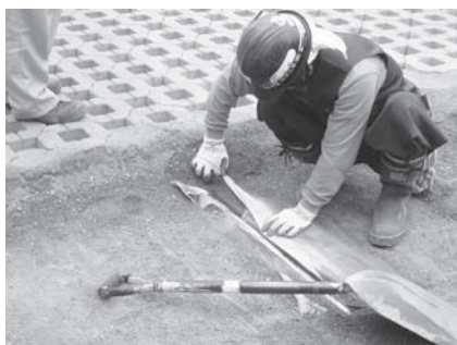
写真一3 給水パイプ敷設
