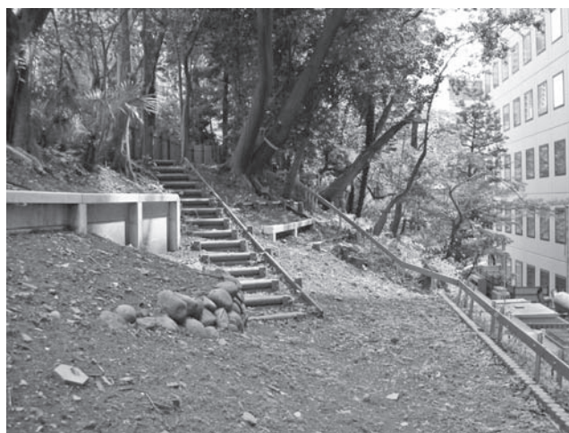
写真—1 既存林・石積み等の保全
