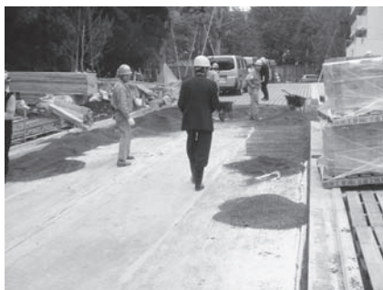
写真一2 導水シート敷設
