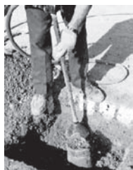
埋設物損傷事故防止対策機 Seeker (シーカー)
