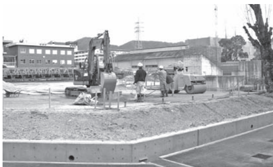
写真—2 実工事への適用（現場適用性試験状況）
