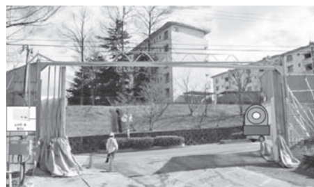
車両出入口警報システム（イメージ写真）
