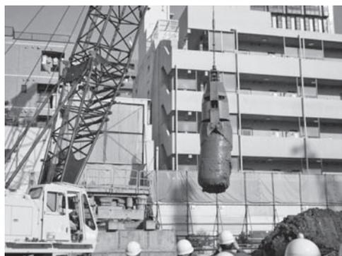
写真-3 切断した杭の除去
