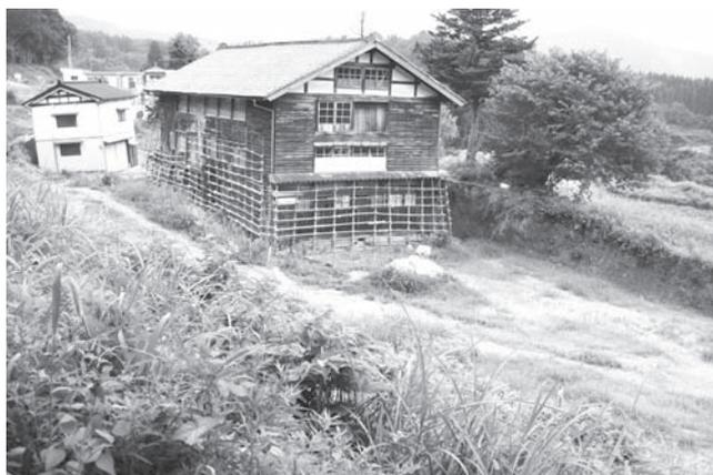
写真一1 家屋の陥没・最大3m程度
