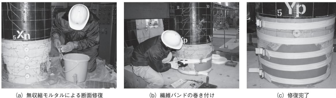
図一6 曲げ破壊した柱基部の提案工法による修復
