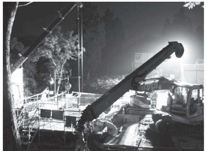
写真—6 集水井の夜間掘削作業
