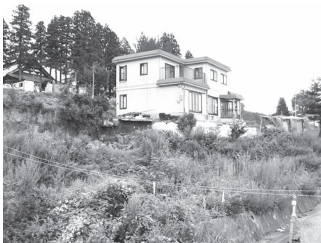
写真一3 家屋の基礎部分崩壊 3.5m程度
