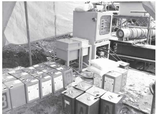
写真一〇 ウレタン注入機械と混合液の空缶
