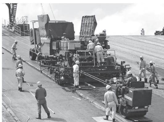
写真4-25 斜面舗装施工状況
