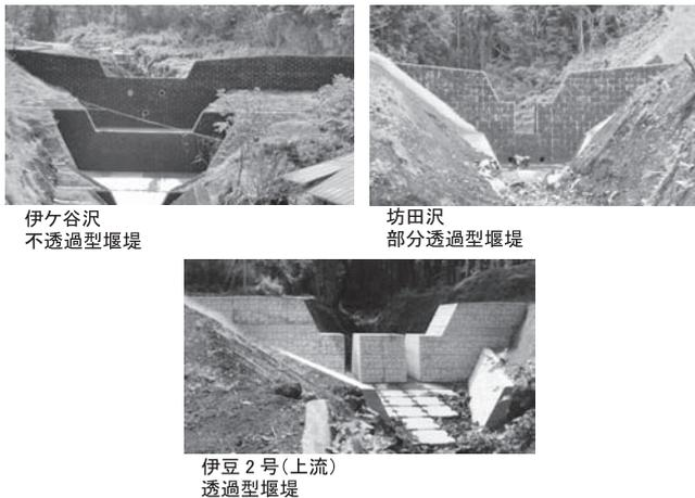
図一6 不透過型・透過型・部分透過型堰堤
