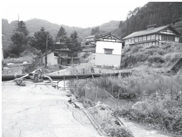
写真一2 道路の寸断・最大段差3.5m程度
