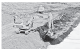
土砂型枠整形状況
