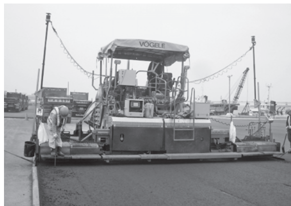
写真—5 GNSS式基層施工状況
