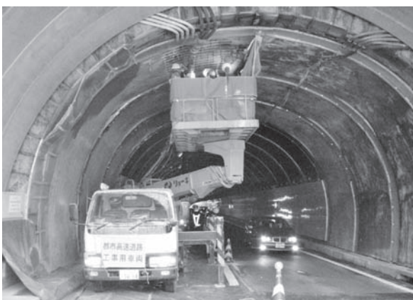
写真—3 TDR ショット工法吹付け状況
