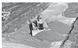
RCC 敷均し状況
