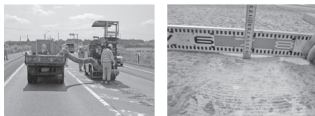
写真—4 施工時の粉塵吸引状況（左）と深さ12mmのランブルストリップス（右）
