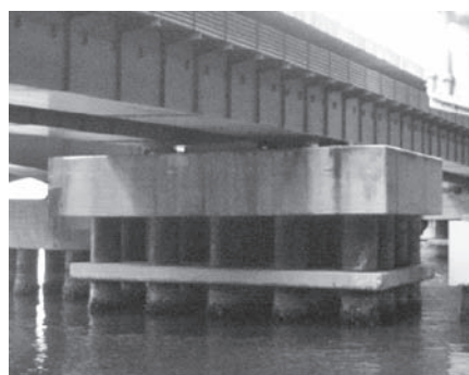
写真—5 施工前写真
