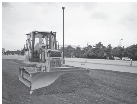
写真—4 TS式ブルドーザ路盤施工状況
