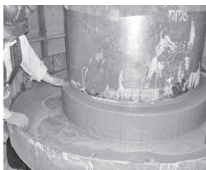
写真—4 モルタル充填
