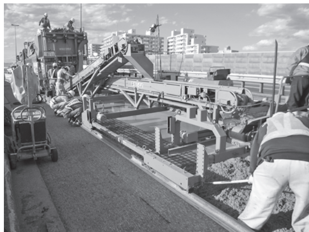
写真—4 SFRC 打設（機械施工①）
