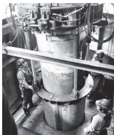
写真—2 補強鋼板圧入
