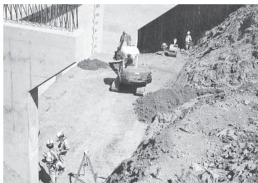
写真—1 構造物裏込め部の状況
