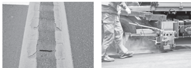
写真—5 溝が埋まった事例（左）とスプレー式の施工状況（右）
