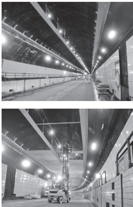
図—8 新設吊金具・天井板設置状況
