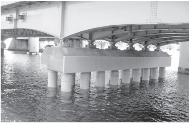
写真—7 完成状況(多柱式基礎)
