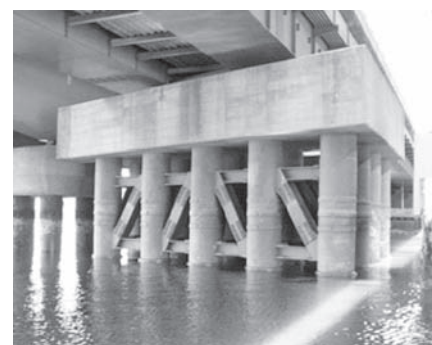
写真—6 完成写真
