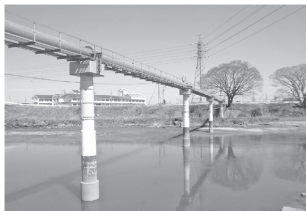
写真—11 完成状況（水管橋）
