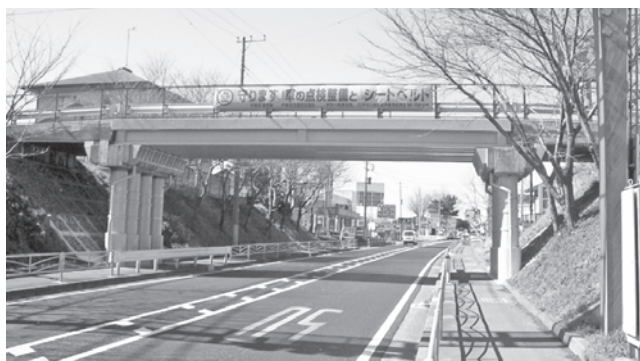
写真—9 完成状況（跨道橋）
