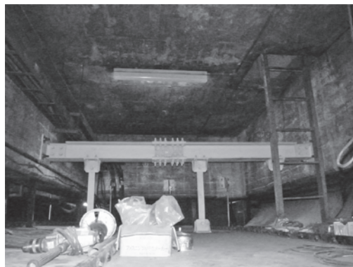
図—9 合金溶射吊部材設置状況
