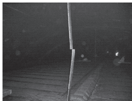
図—7 既設吊金具状況（通常部・損傷部）
