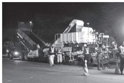
写真—7 表層施工状況
