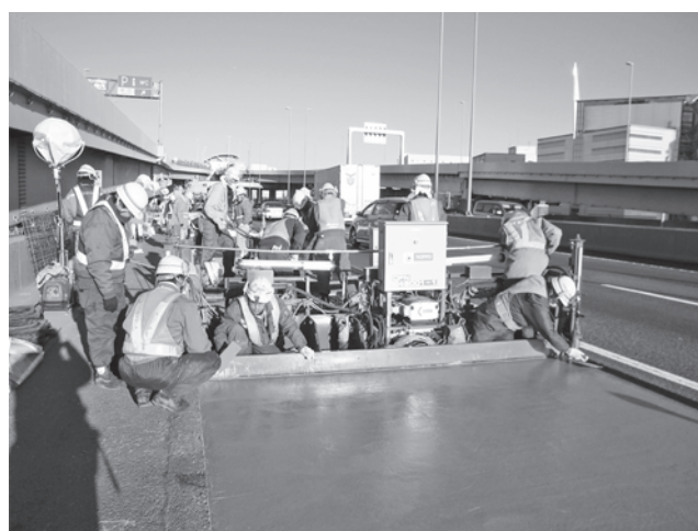
写真—5 SFRC 打設（機械施工②）
