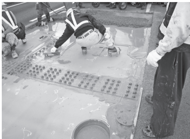
写真—3 接着剤塗布工
