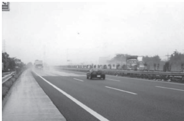
写真—1 雨天時の高機能舗装
