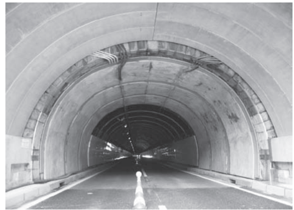
写真—4 覆工補強完成
