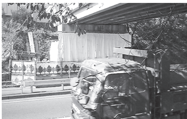
写真—10 仮設状況（跨道橋）
