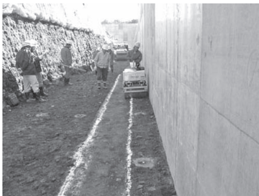
写真—2 小型施工機械による構造物裏込め
