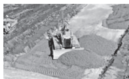
RCC敷均し状況
