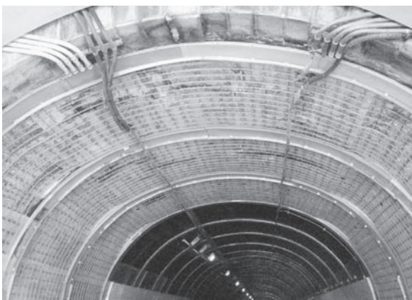
写真—2 樹脂塗装鉄筋の配置
