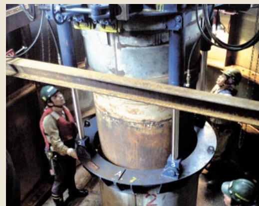
補強鋼板圧入
