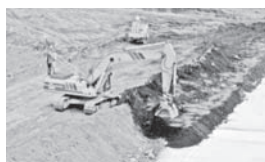
土砂型枠整形状況
