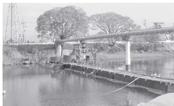
写真—12 施工状況（水管橋）
