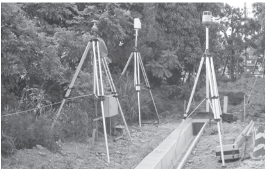
写真一 1 GNSS 式基地局設置状況
