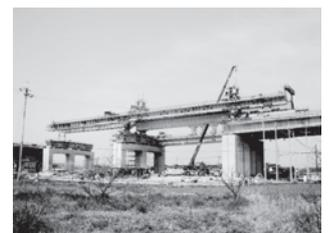
写真-2 主桁のガーダー架設
