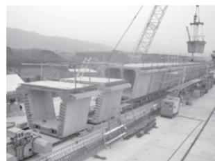
写真-1 既設主桁上での組立て
