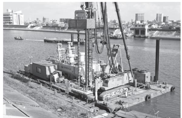
写真一 3 台船上に搭載した WHJ 施工機全景
