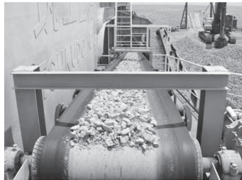
写真—6 材料運搬状況（ベルトコンベア）
