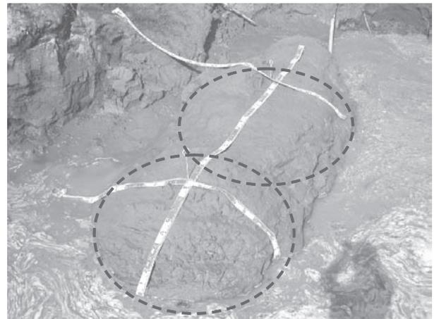
写真-2 改良体の観察状況 (試験施工 1)
