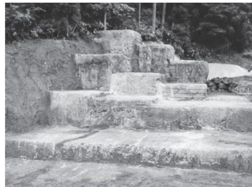
写真一 5 改良体の掘削状況 (2)
