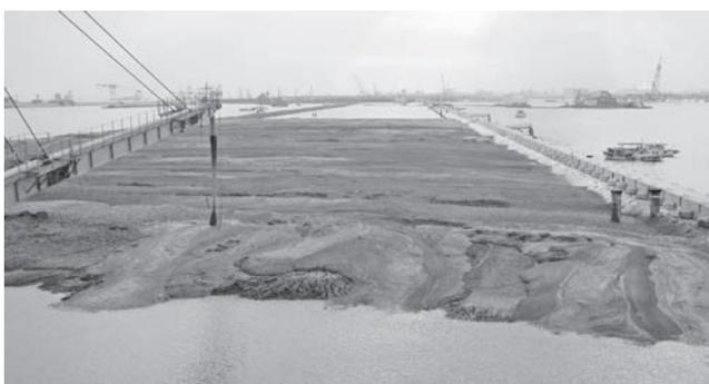
写真—5 打設後の固化処理土
