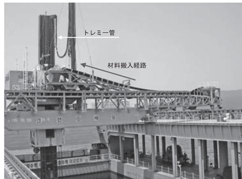
写真—7 材料運搬状況（走行台車）
