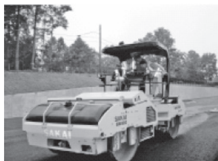
写真-4 ジョージア州試験施工状況
