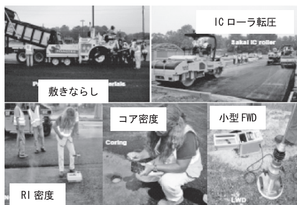
写真ー1 試験施工と管理機器による測定
