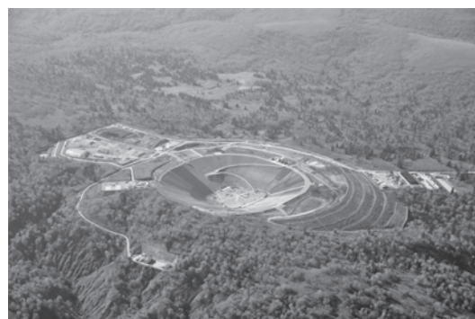
写真—1 上部調整池空撮（2009年10月16日撮影）
