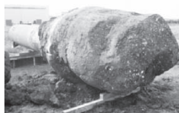
写真—2 根固め部掘り起し状況
