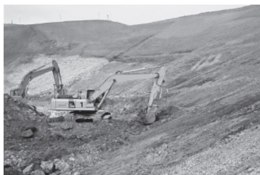
写真一 5 切取法面仕上げ状況
