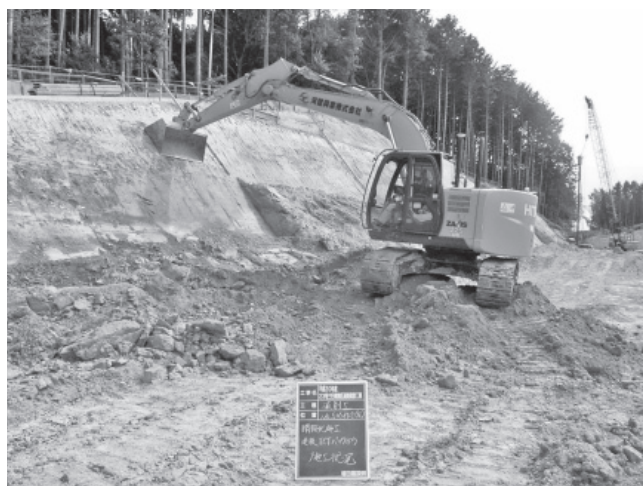
図一7 法面バケットによる法面整形
