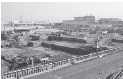
写真一 掘削状況
