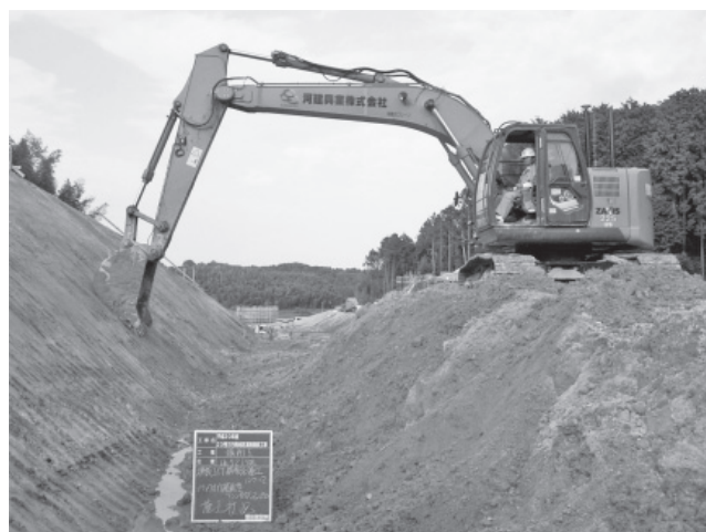
図—6 通常バケットによる法面整形
