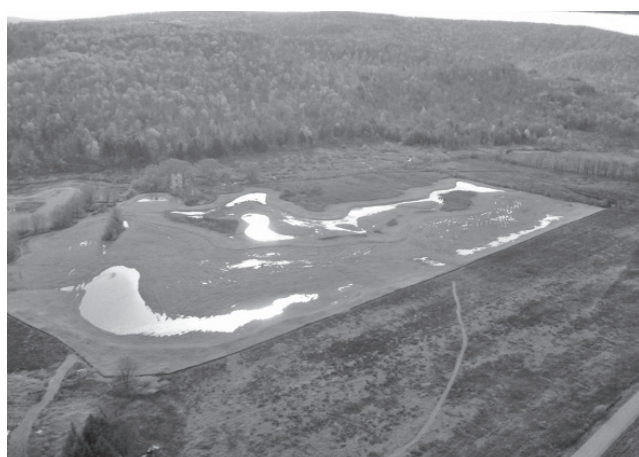
写真一 3 Hinman Wetlands 施工後全景
