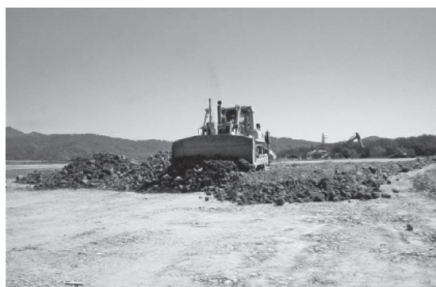
写真—4 堤体敷均し状況
