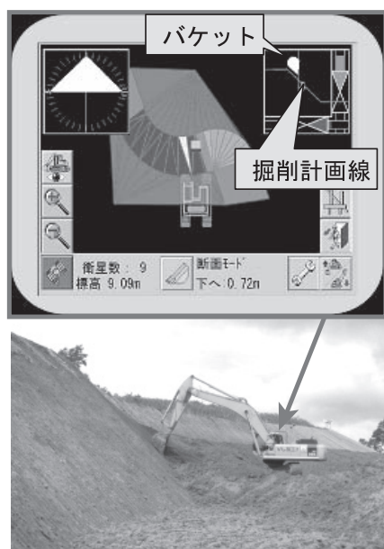
図—2 情報化施工のモニタ画面
