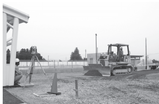
写真—1 3D-MC システムの施工事例
