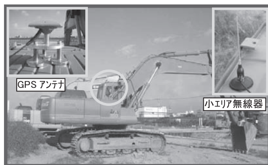
写真三 掘削機械に搭載した GPS
