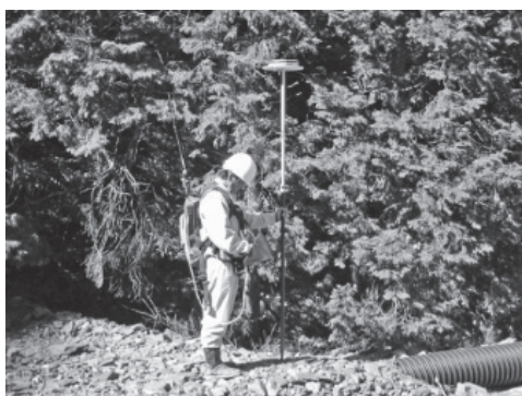
写真—2 3D-NAViによる測量状況
