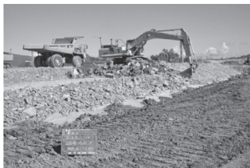
写真一 6 堤体法面整形状況
