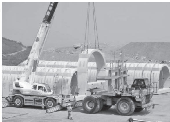
写真-3 積み込み状況（有人部）
