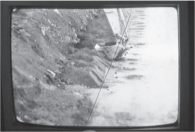
写真―11 土砂型枠施工状況
