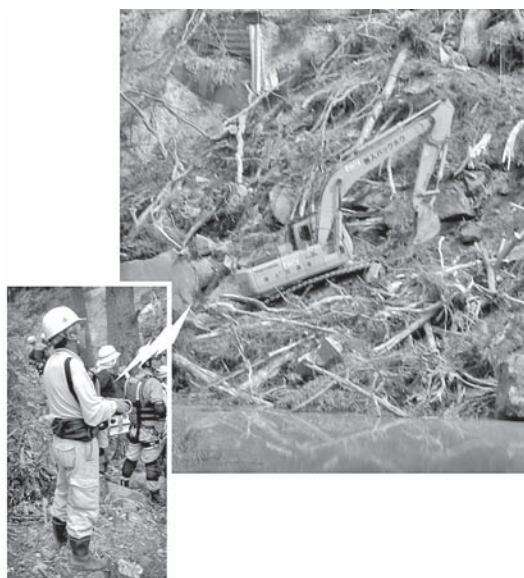
写真一 4 無人化施工機械の使用状況
