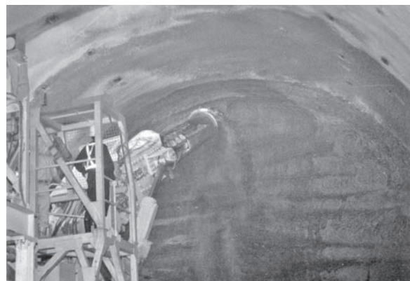
写真-1 自動化掘削切羽状況
