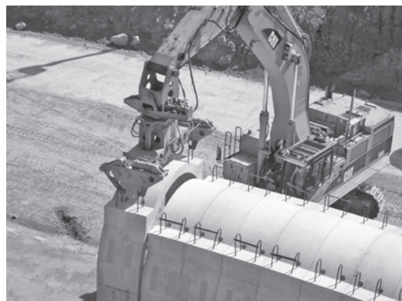
写真-5 カルバート据付状況（無人部）
