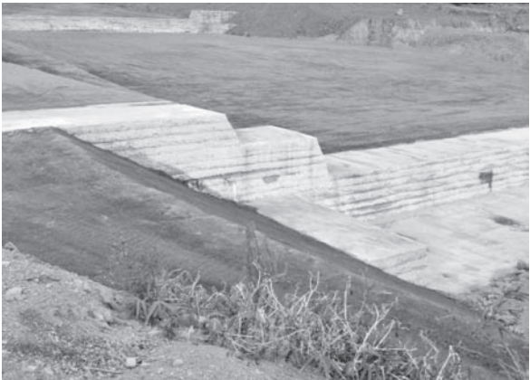
写真―9 計測ヤード状況
