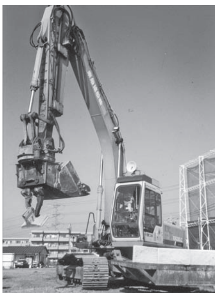
図—1 土工機械の遠隔操作システム
