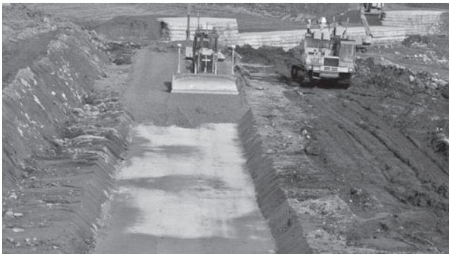
写真－4 敷均し状況
