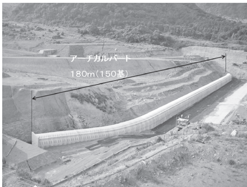
写真—7 プレキャストカルバート据付完了写真
