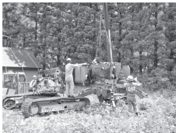
写真一 3 油圧ショベル組立の状況
