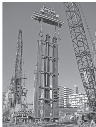
写真—4 高精度建込み治具
