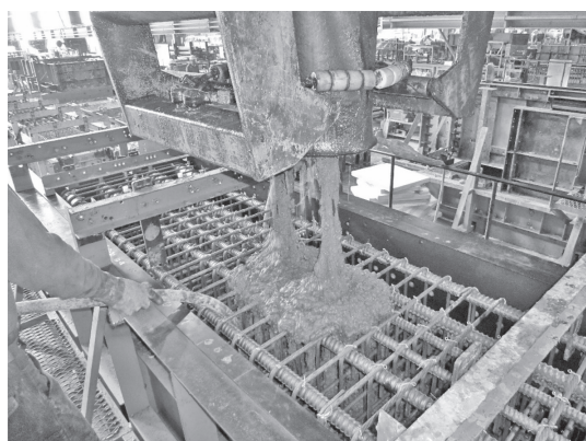
写真—4 打ち込み状況
