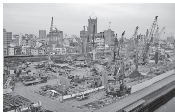
写真—6 地中連続壁杭工事状況
