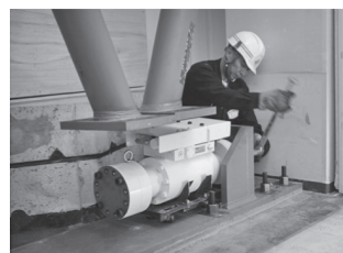
⑦制振ダンパーの設置
