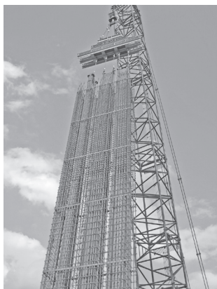
写真—3 SRC 鉄筋籠
