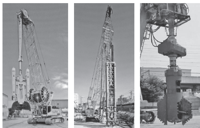
写真—2 地中連続壁杭工事専用掘削機
