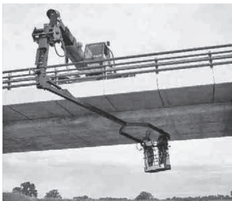
写真—3 橋梁保守作業
