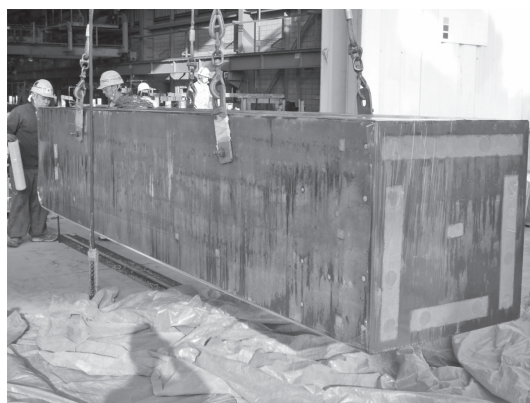
写真—6 蒸気養生槽から取り出した部材
