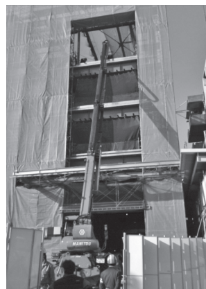
写真―7 5階までの揚重作業
