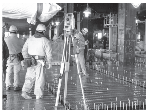
写真-3 墨出しの様子
