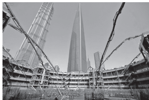
写真—14 上海中心大厦建築現場。(完成すれば128階、632mで世界第2の高さとなる。)18台の三一製コンクリートポンプが使われている。
