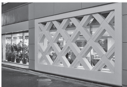
図—3 耐震補強の例
