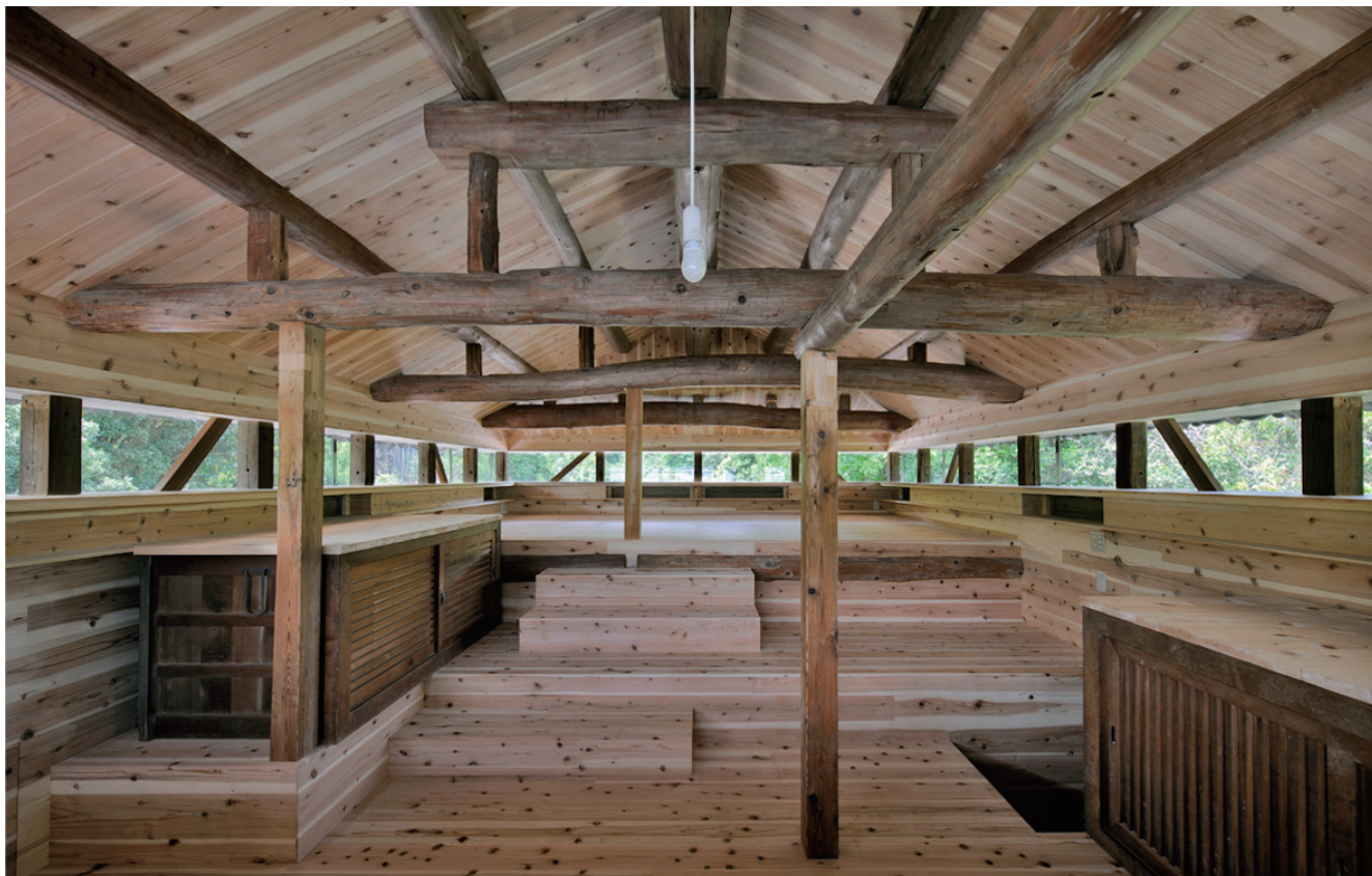
写真—7 小屋組み現しの2階寝室
