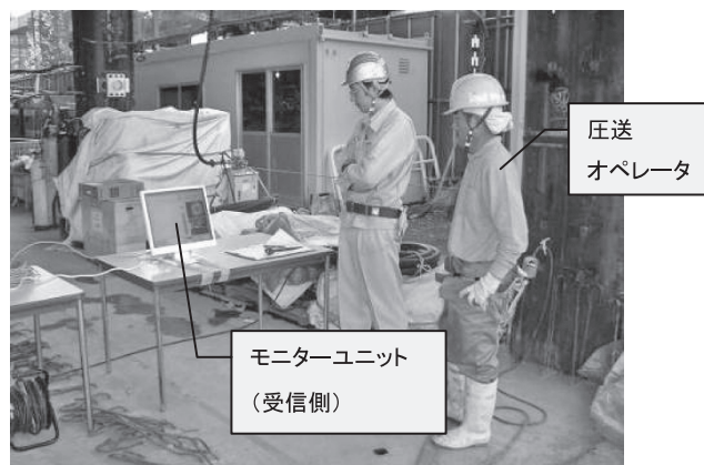
写真—4 モニターユニット設置状況
