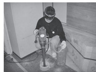
②PC 鋼棒用床孔あけ
