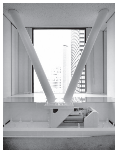
写真—4 ダンパー設置状況
