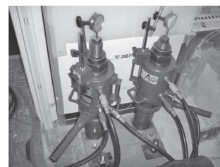
④PC 鋼棒に緊張力導入
