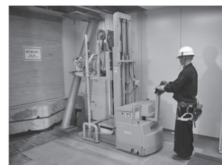
⑥ブレースの設置
