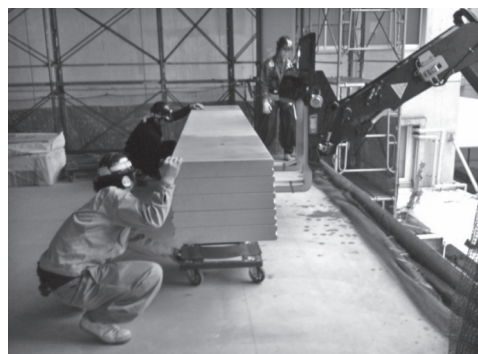
写真―8 施工階降作業
