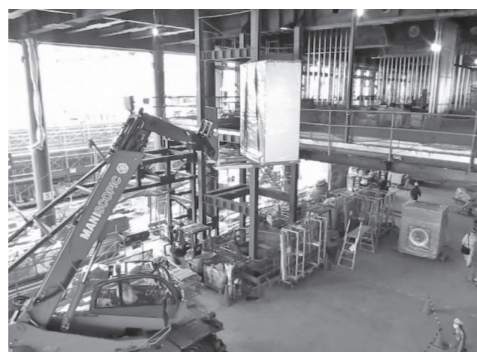
写真―9 建物内揚重作業
