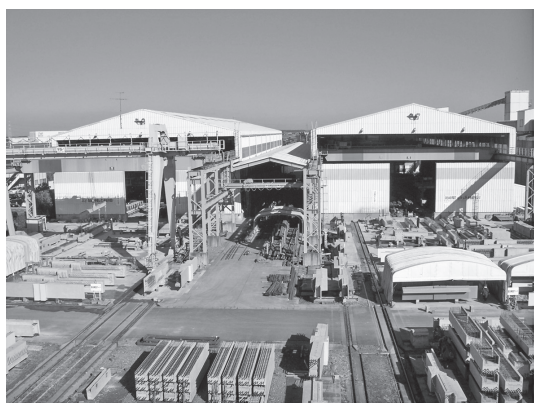
写真—2 千葉 PC 工場ストックヤード
