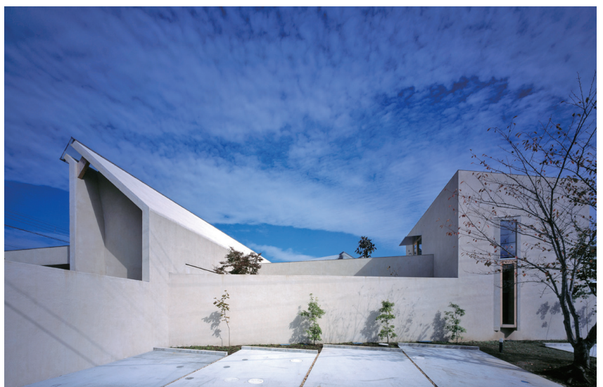
写真—4 南側から見る。
