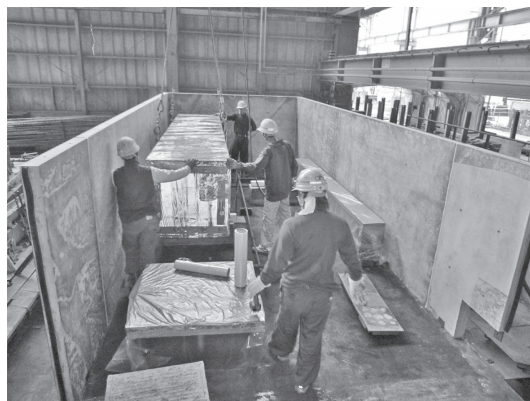
写真—5 蒸気養生槽内設置状況
