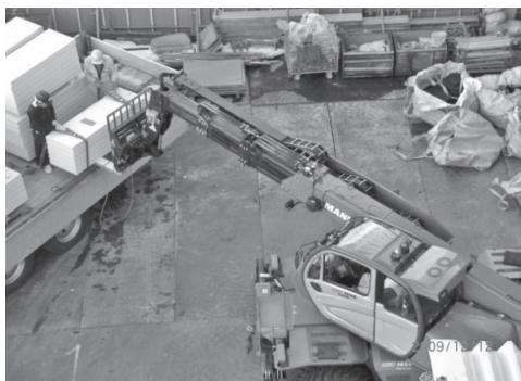
写真―6 搬入車両からの荷取作業
