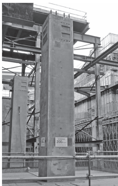
写真—8 プレキャスト柱の設置状況
