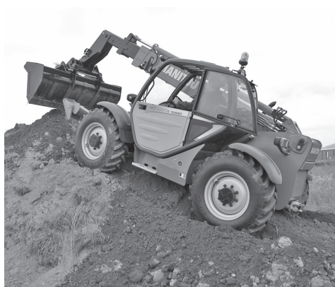
写真—2 土砂運搬および土木作業
