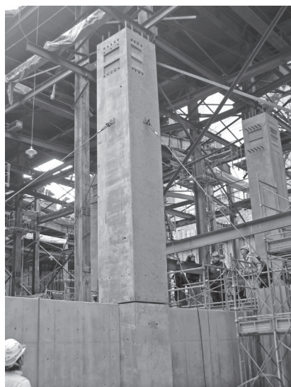
写真—7 プレキャスト柱の建て込み状況
