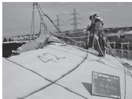
写真—10 解体の状況
