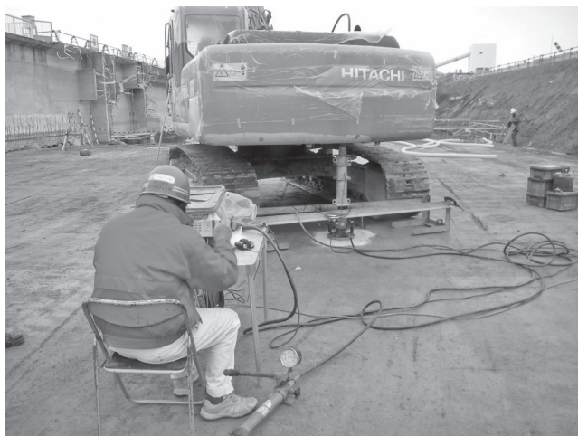
写真—9 平板載荷試験状況
