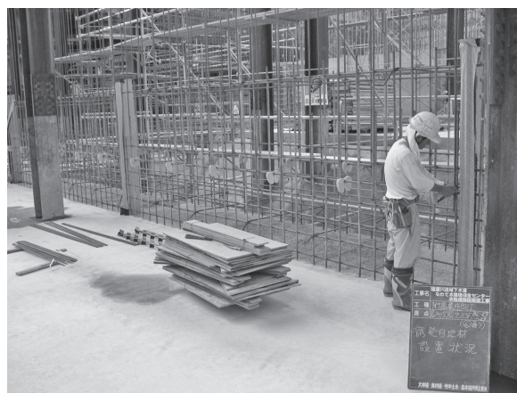
写真一六 誘発目地の設置
