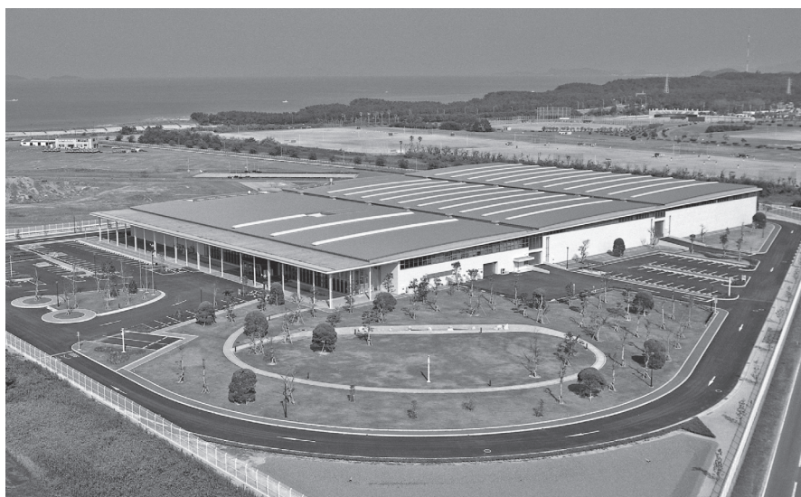
写真—1 海の中道奈多海水淡水化センター（全景）
