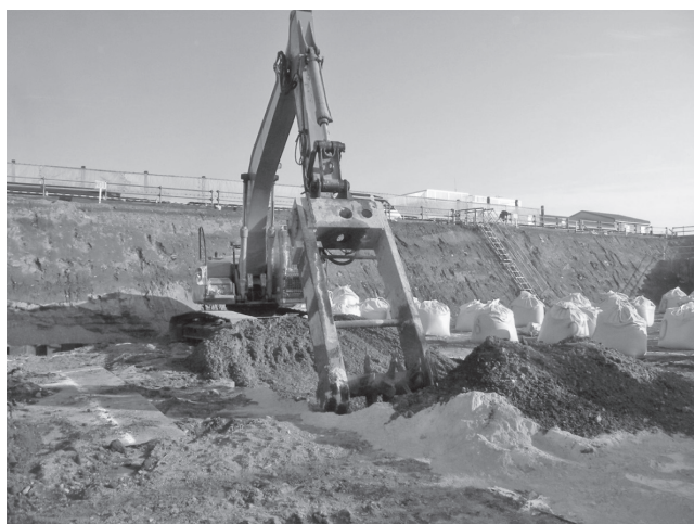
写真—7 セメント攪拌状況
