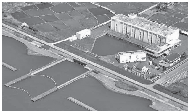
写真—1 霞ヶ浦揚水機場
