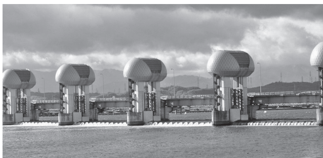
写真—1 機能性と景観との調和に配慮した例
