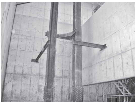
写真—7 栈橋支持杭の補強
