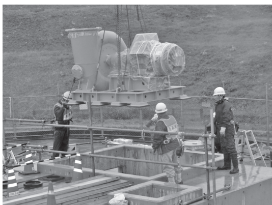
写真一九 水車・発電機搬入
