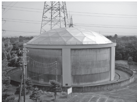
写真—13 完成写真
