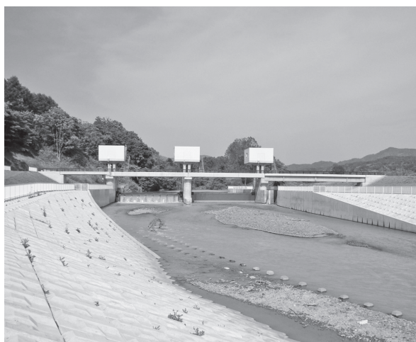
写真—5 完成後（通水中）
