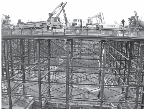
写真—3 底版コンクリート打設状況
