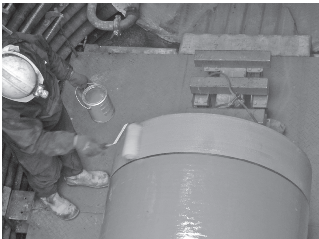
写真一七 滑剤塗布状況
