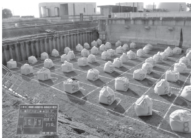
写真－5 セメント検収状況
