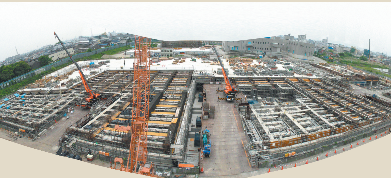
寝屋川流域下水道 なわて水みらいセンター 水処理施設築造工事
