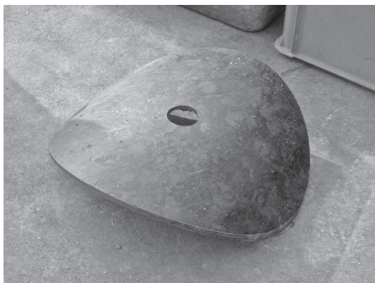
写真一八 切り取った既設管
