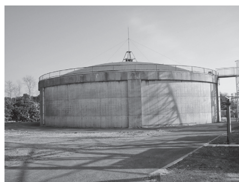
写真—2 リニューアル前の PC タンク
