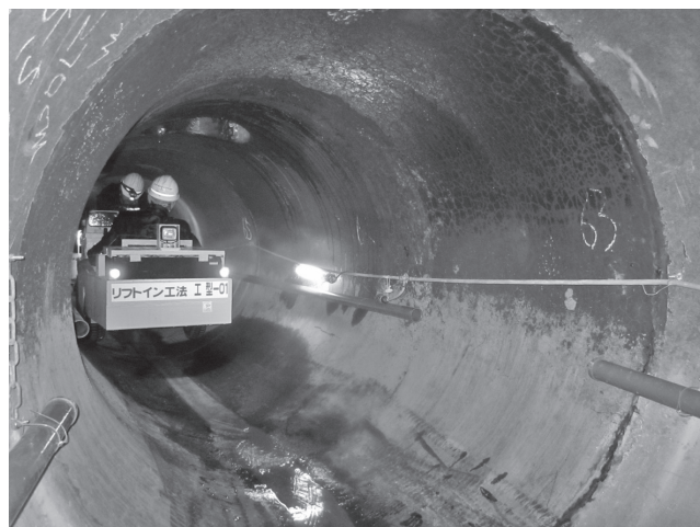
写真—6 既設管内の運搬状況
