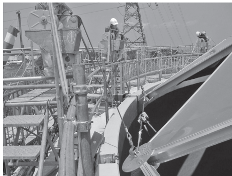
写真—12 ウィンチ上架の状況
