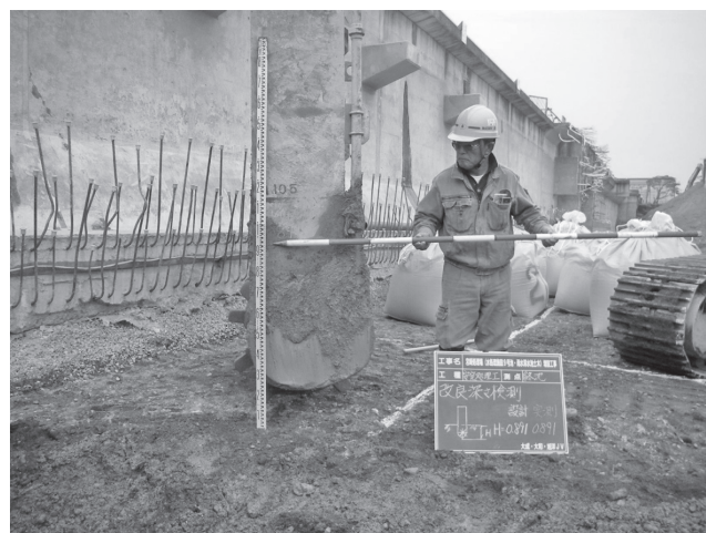
写真—8 攪拌深さの確認状況
