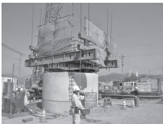
写真一1 PCウェルの施工状況写真
