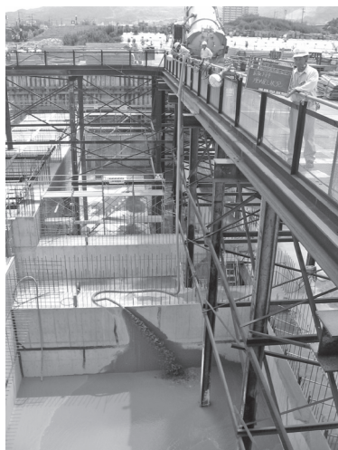
写真一五 ソイルモルタルでの埋戻
