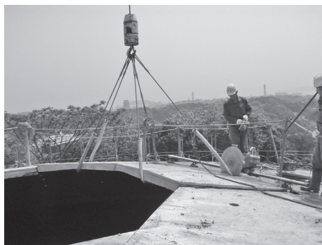
写真-3 ウォールソーによる切断の状況
