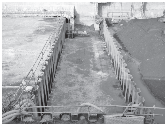
写真－4 水処理施設ピット部床付完了
