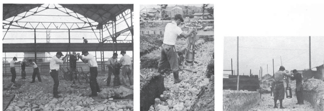
写真 1-11 (株)明和製作所 ジャンプランマ施工状況
