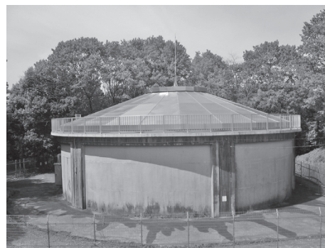
写真—17 完成写真
