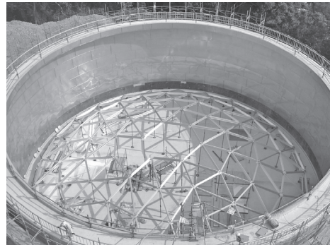
写真-5 骨組の組立て
