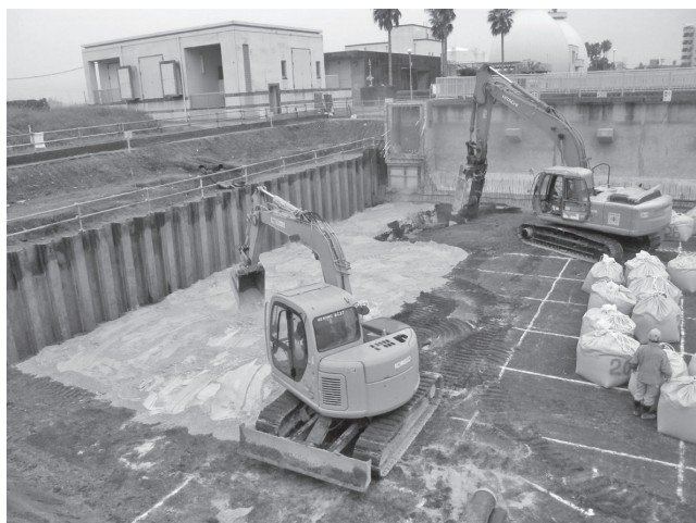
写真—6 セメント散布状況
