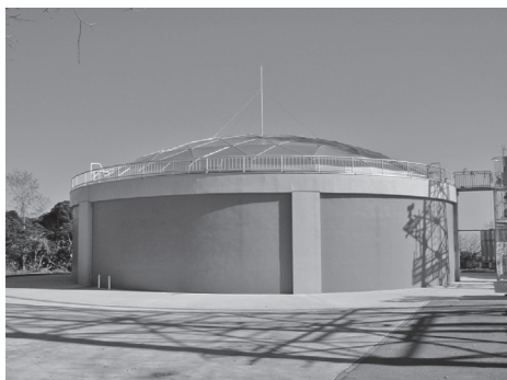
写真—8 完成写真
