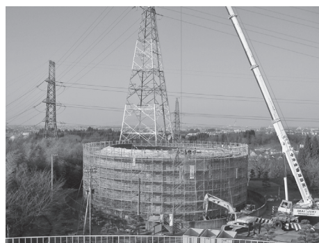
写真—11 重機の配置
