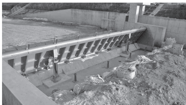
写真—2 起伏ゲートの施工例
