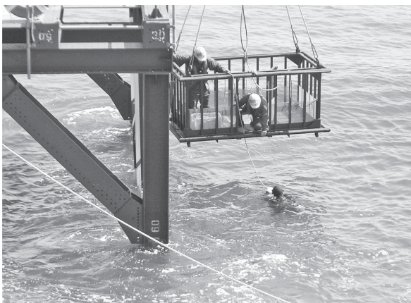
写真—2 潜水夫による調査状況
