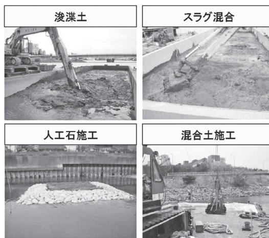
写真-1 東京都城南島での浅場造成実験工事
