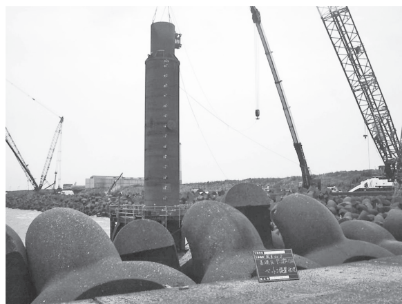
写真—5 ヤットコ設置状況
