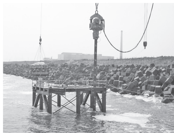
写真—1 障害物探針状況
