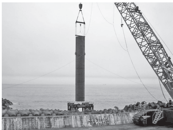
写真—4 モノパイル建て込み状況
