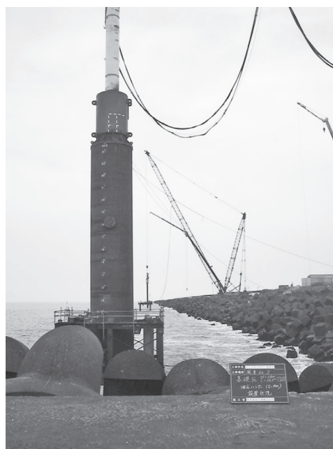
写真—6 S-500 ハンマー設置状況
