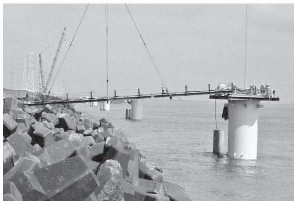
写真—8 中詰めコンクリート打設状況
