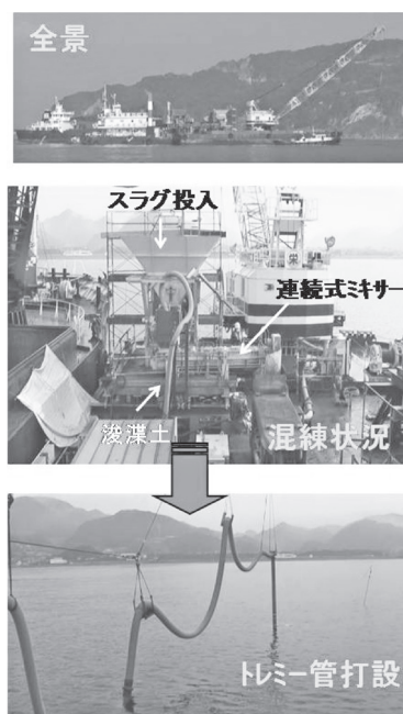
写真—2 カルシア改質土の施工状況
