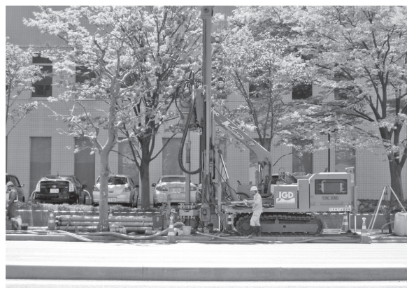
写真ー2 掘削機
