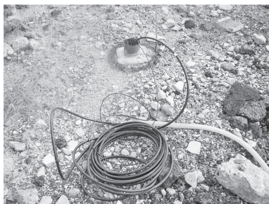
写真一 3 注入状況
