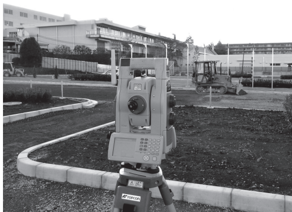
図-2 TS式3D-MC小型ブルドーザによる施工
