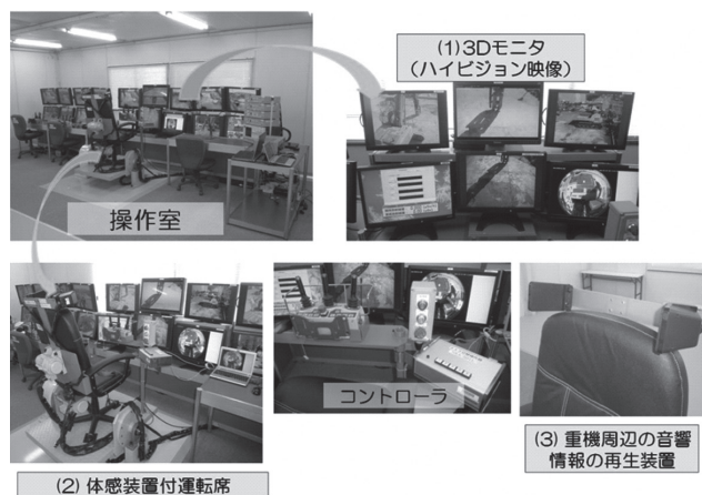
図一5 無線操作室における機器等の配置
