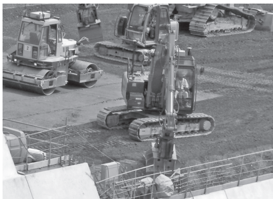
図—13 端部法面締固め実施状況
