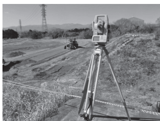
写真－4 MC による敷均し高さ管理
