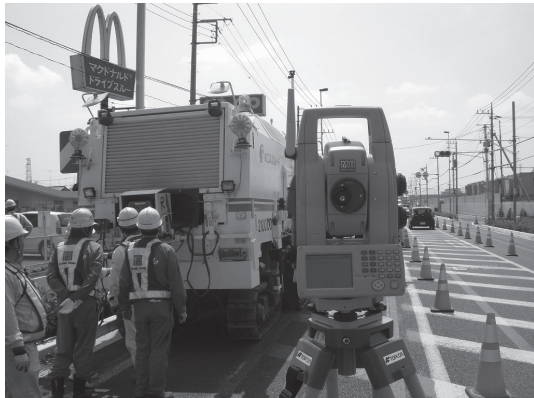
図一七 3D-MC で作業中のクローラ式切削機
