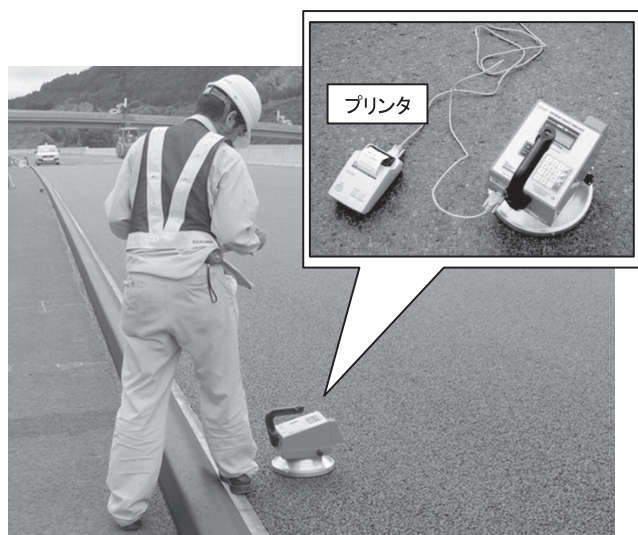
図—14 アスファルト舗装密度測定機による計測状況
