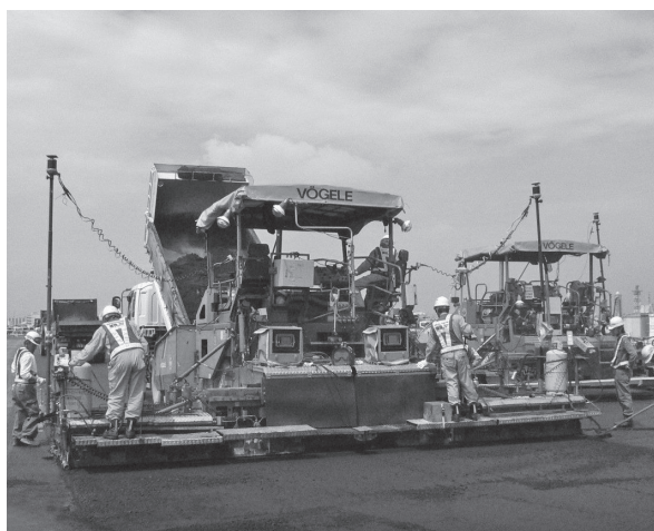
図—4 高精度 GNSS 式 3D-MC で施工中の AF
