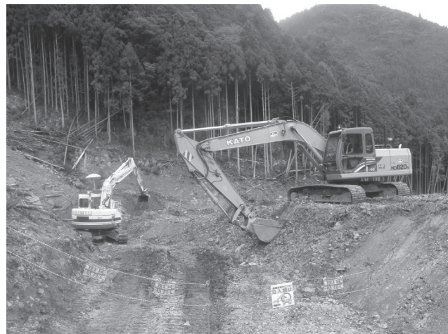
写真－3 防護土堤作成工事
