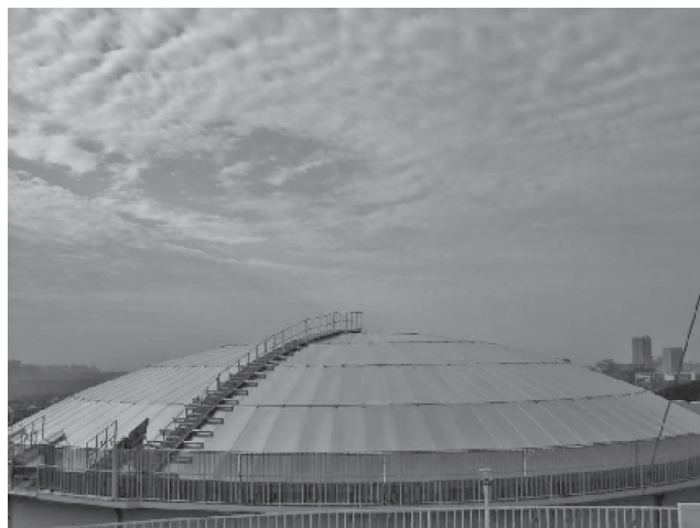
写真一 3 アルミドーム屋根外観
