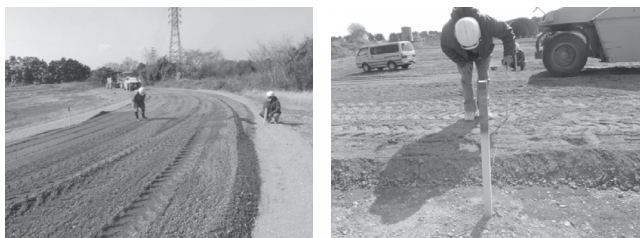
写真－3 現行の敷均し高さ管理
