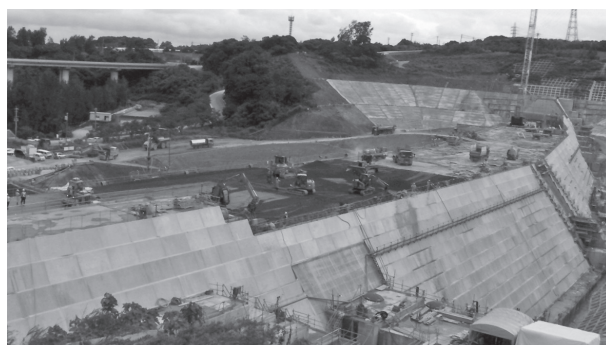
図—1 億首ダム施工状況
