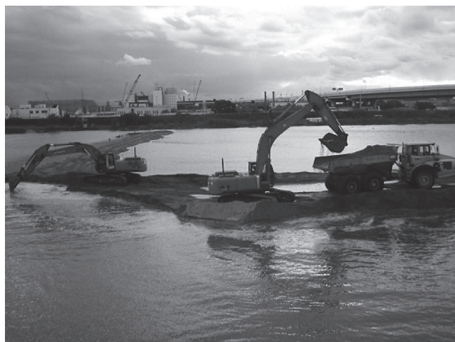
写真－2 大和川河道掘削工事
