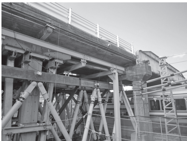
写真一五 既設橋と仮設トラス桁
