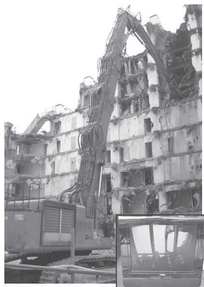
写真一 4 大型解体用機械の遠隔操作実証実験
