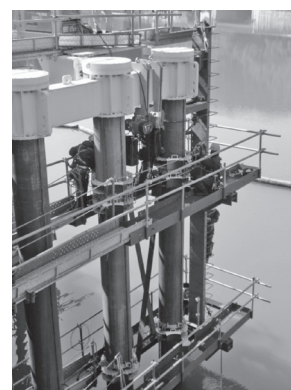
写真―1 プレース材組立て状況
