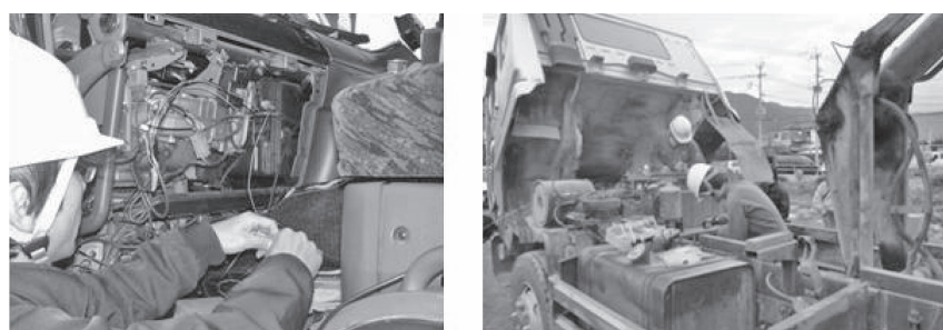
写真—2 デジタコ等配線が必要とする装置の取り付け作業の例
