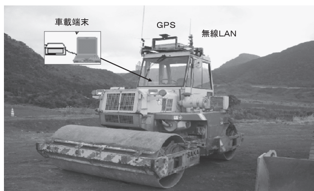
図-9 転圧ローラー
