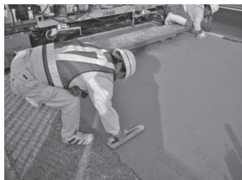
写真-3 端部仕上げ状況
