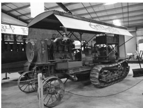
写真—2 ホルト社B型トラクタ，33kW ガソリンエンジン（1909年製）
