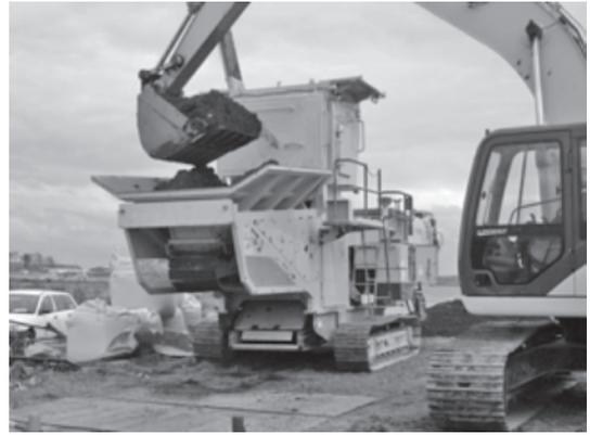
写真一九 土質改良機による固化材の混合
