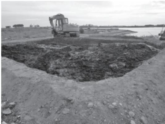
写真一七 土砂ピットへ貯えられた浚渫土
