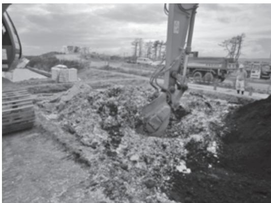
写真一八 古紙破砕物と浚渫土の混合
