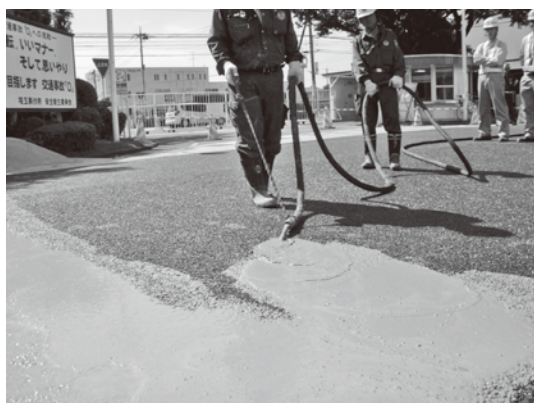
写真—6 浸透作業
