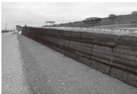
写真一六 ジオグリッドによる法面補強
