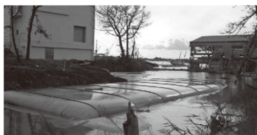
写真—13 定置型袋を用いた盛土
