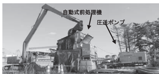
写真—10 浚渫土の前処理とポンプ圧送
