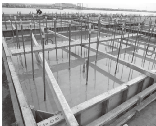
写真—3 ゲルの散布完了後の状況（CASE ①）
