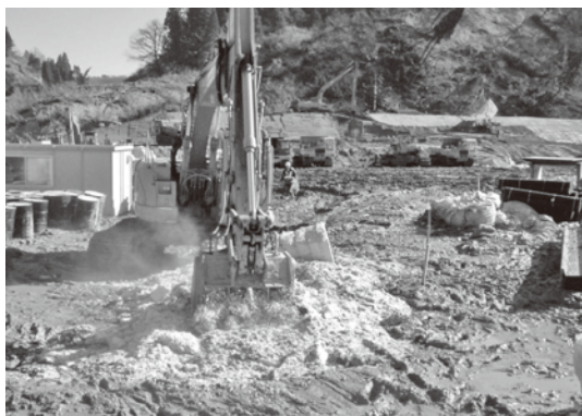
写真—7 土砂災害により発生した大量の軟弱土に古紙破砕物を混合している様子。処理土は強度発現が早いので、迅速な復旧工事に大きく寄与した。
