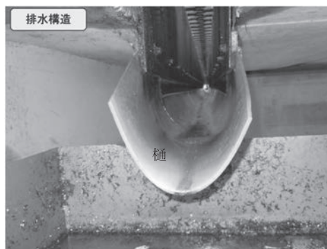
写真―4 フィンガージョイント排水構造
