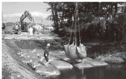
写真—12 可搬型袋の運搬と設置
