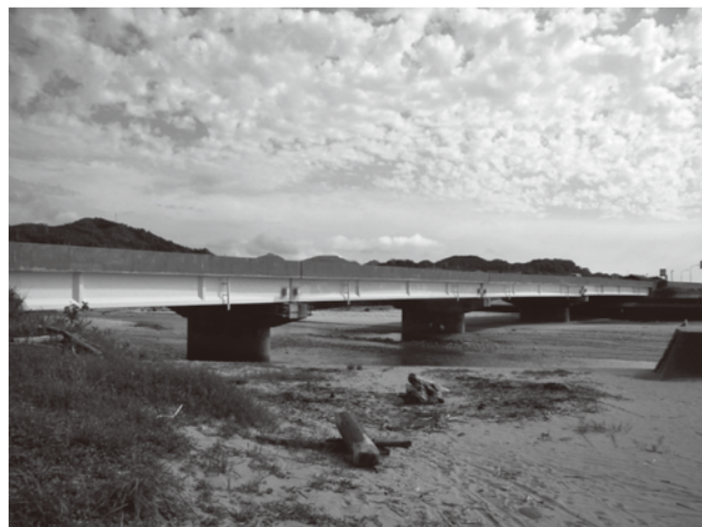
写真—2 新設時から塗装した府屋大橋 新潟県国道 7 号 1982 年から 30 年間を経過して現在も観察中
