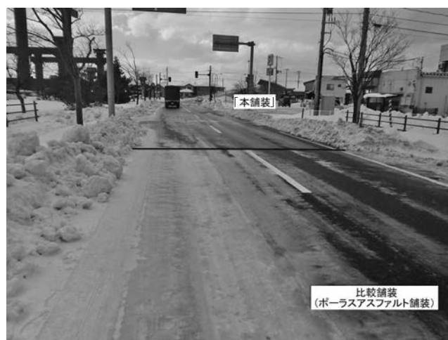
写真—7 冬期路面調査結果②（除雪後）
