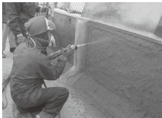
写真—6 ECC吹付け状況
