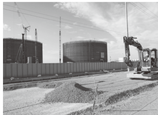
写真—3 八戸港改修道路工事（工期：2012/3～9）
