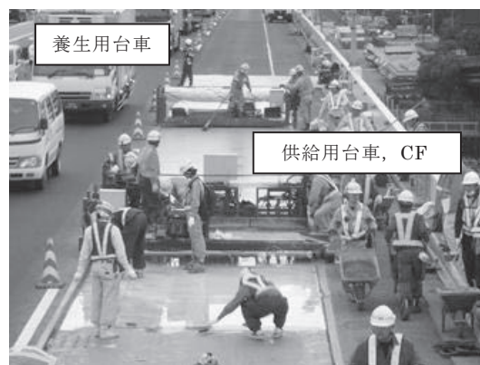
写真—8 HFRC 打設状況
