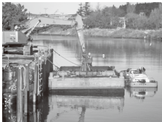
写真—8 浚渫土の陸揚げ
