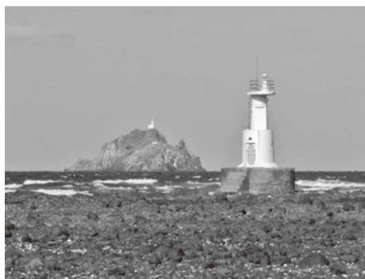
写真—1 海水と未洗浄の海砂を使用した肥前長崎鼻灯台（手前の灯台、海上保安庁佐世保海上保安部ホームページより転載、 http://www.kaiho.mlit.go.jp/07kanku/sasebo/ ）
