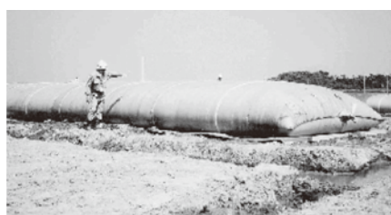
写真—3 袋詰脱水処理工法
