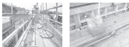
図－14 コンクリートの施工と初期排水状況
