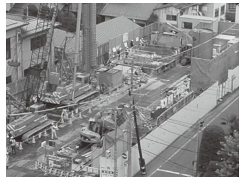
写真—6 仙台東部共同溝工事現場の全景（本現場は、写真—3の施工現場と異なり、市街地中心部近くに位置し、限られた作業面積しか取れないため、重機が効率良く整然と配置されている。右上奥が「本工法」の実施場所。混合・攪拌およびダンプへの積み込みを1台のバックホウで行うため、ミキシングバケットが装着されている）
