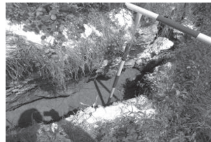
写真—4 現地発生土による築堤箇所は多くのせん断破壊が生じた
