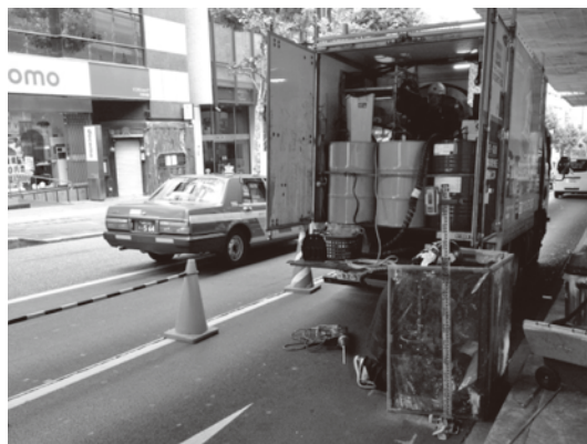
写真—9 作業帯内での注入状況
