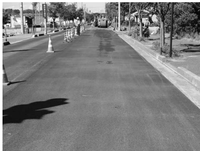
写真—3 舗設完了
