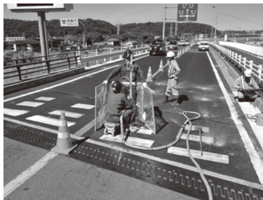
写真—8 踏掛版下への注入状況
