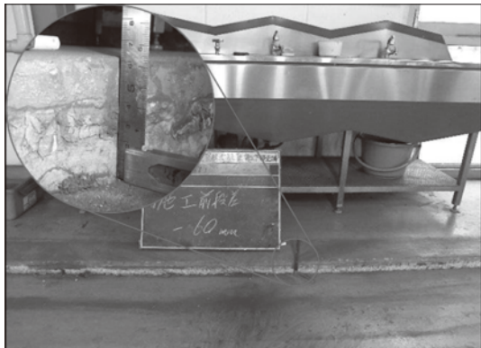
写真—6 施工前 段差 60 mm
