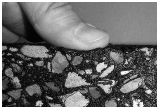
写真—1 「本舗装」の構造
