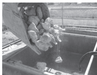
がら投入状況
