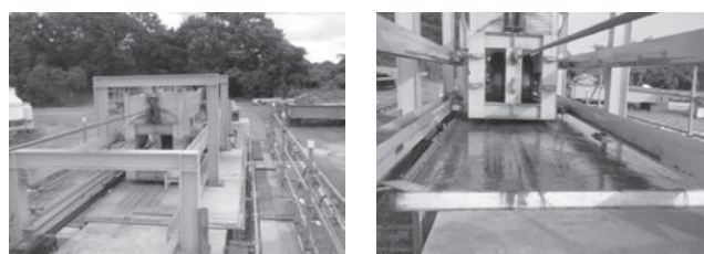
写真—6 輪荷重疲労試験状況
