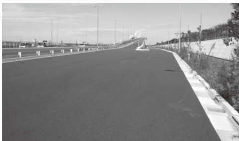
写真一七 完成時の状況 (H23.8.30 撮影)
