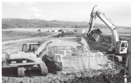
写真—3 浜尾遊水地における施工の様子（写真右のバックホウで高含水比の原泥を掘削しピットに入れ、左のバックホウのアタッチメントを攪拌用のミキサーに変え、古紙と原泥を混合・攪拌する）
