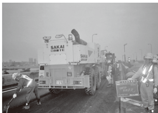
写真—1 路面切削機
