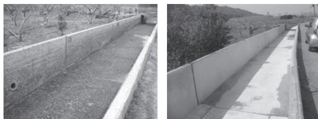
写真—7 施工前および施工後の状況
