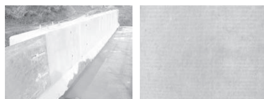
図－15 脱型後のコンクリートの仕上がり状況
