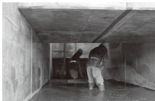
写真一九 気泡混合土の打設状況
