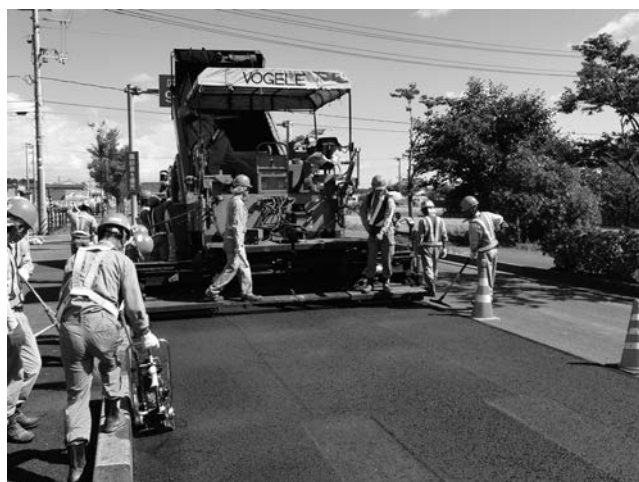
写真—2 施工状況
