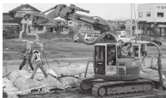
写真—11 圧送されたヘドロの充填
