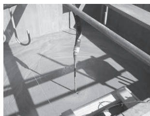
モルタル注入状況
