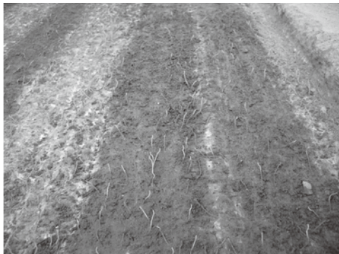
写真—4 露出したSF
