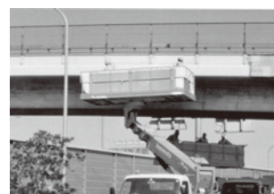
写真—13 施工状況
