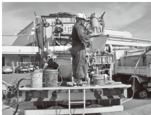
写真—5 連続鍊りローリー車によるセメントミルクの製造
