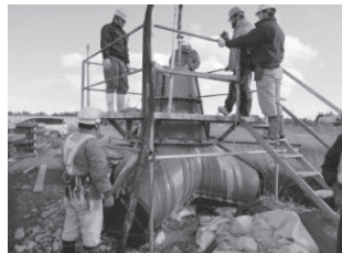
モルタル注入状況
