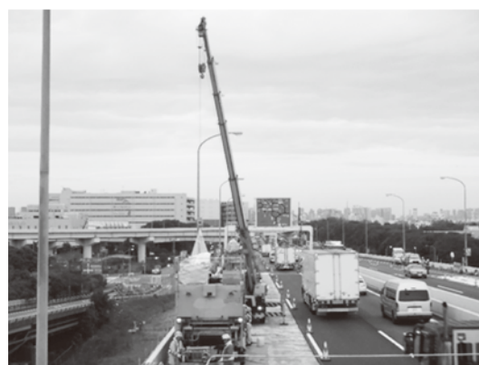
写真—7 移動式バッチャミキサ車への材料追加搬入
