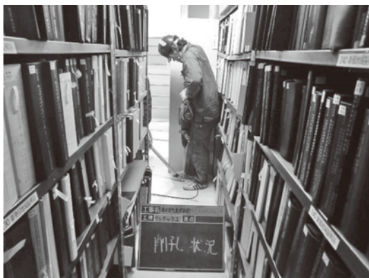
写真—2 狭小部での削孔・集塵状況
