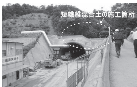
写真—16 トンネル坑口地盤の靱性強化
