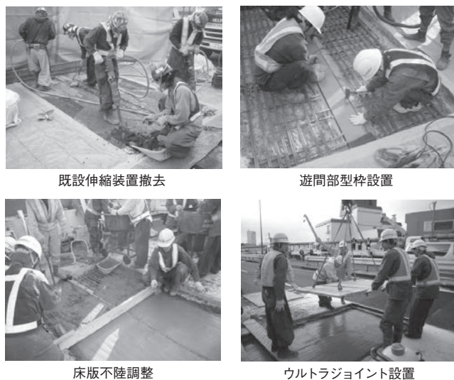
写真—3 各工程の作業状況
