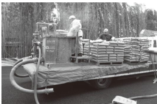
写真—4 従来の浸透用セメントミルクの製造
