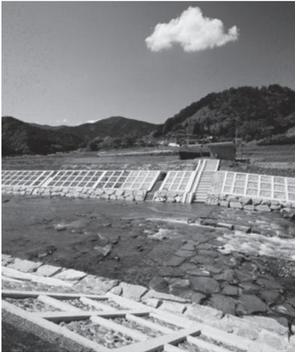
写真—3 多自然型河川表流水取水工法
