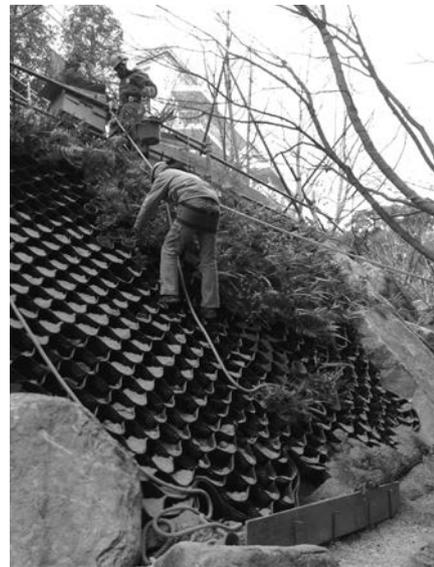
写真—4 法枠緑化施工中
