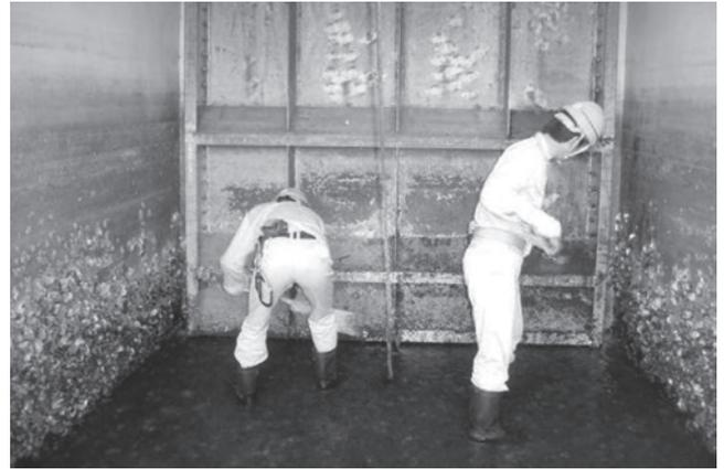
写真—2 付着した貝類の除去作業状況
