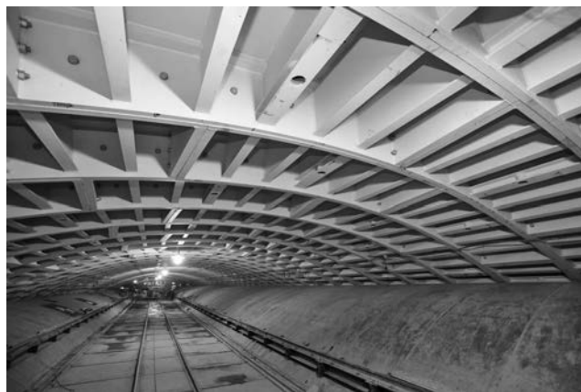
写真—5 アーチセグメント設置完了
