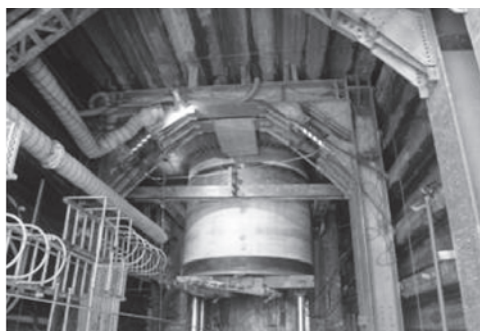
写真一15 発進立坑内状況（下段管施工時）
