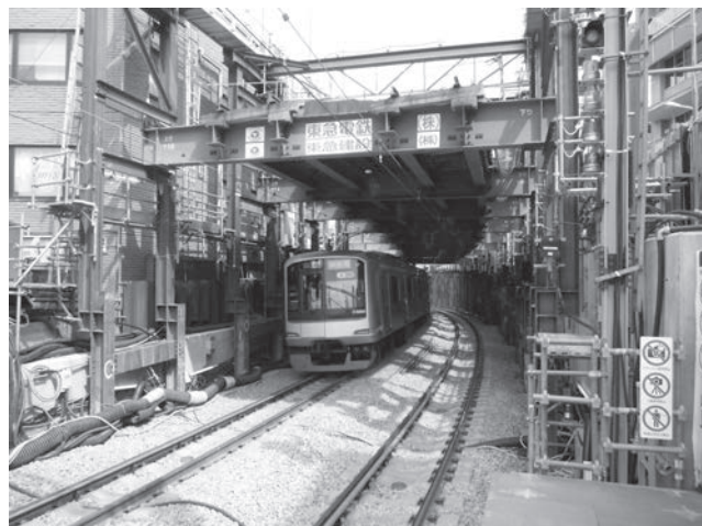
写真—3 地下化切替後
