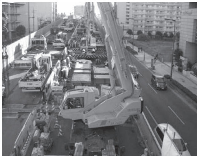
写真一 9 クレーン配置状況
