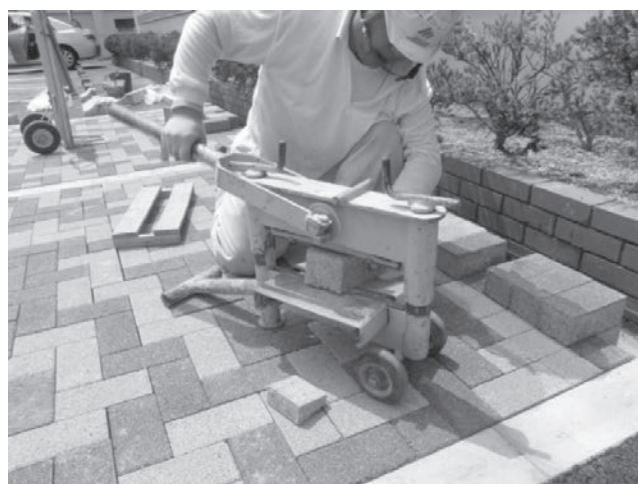
写真—4 C-WRILB をカッターで切断
