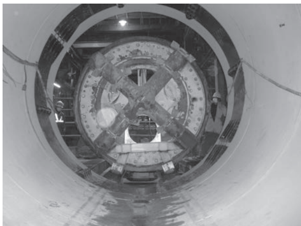
写真—7 内殻引戻し完了
