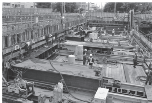
写真—1 施工状況（発進立坑）
