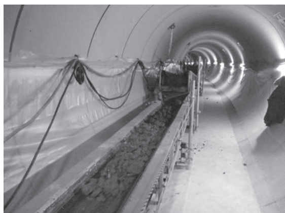
写真—9 掘削土砂搬送
