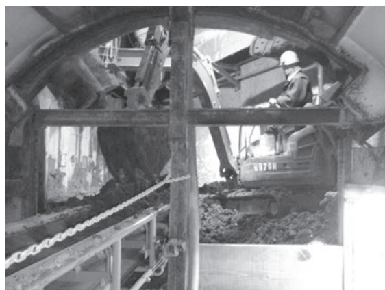
写真—8 到達立坑路下掘削
