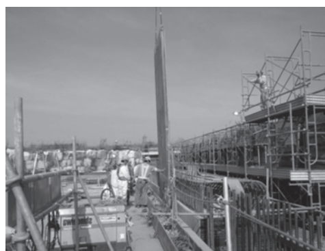
写真—4 鋼製パネル型枠の撤去状況
