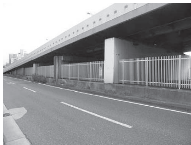
写真—4 対象橋梁外観（法円坂区間）
