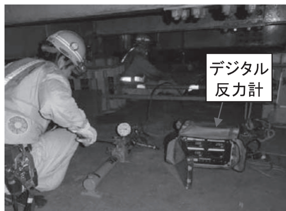
写真—5 ジャッキアップ状況
