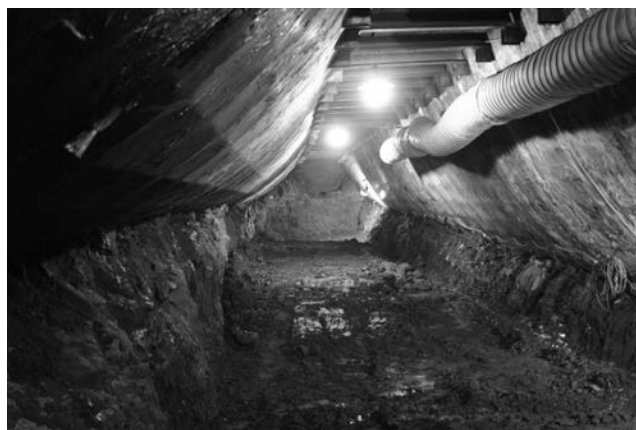
写真—3 下半部掘削状況
