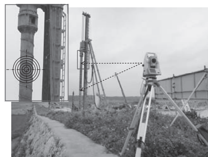
写真—1 計測状況（先行削孔用のケーシング対象）
