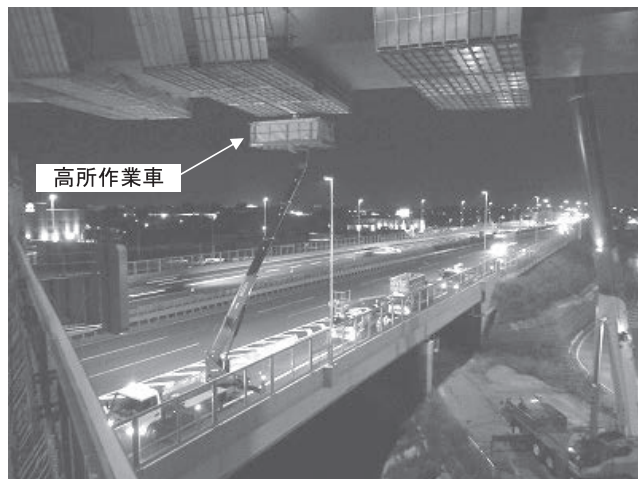
写真—6 高所作業車による防護
