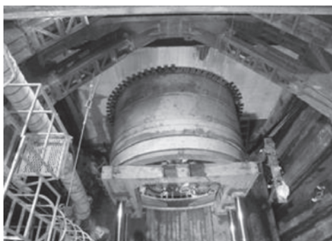
写真一13 初期掘進状況（上段管施工時）
