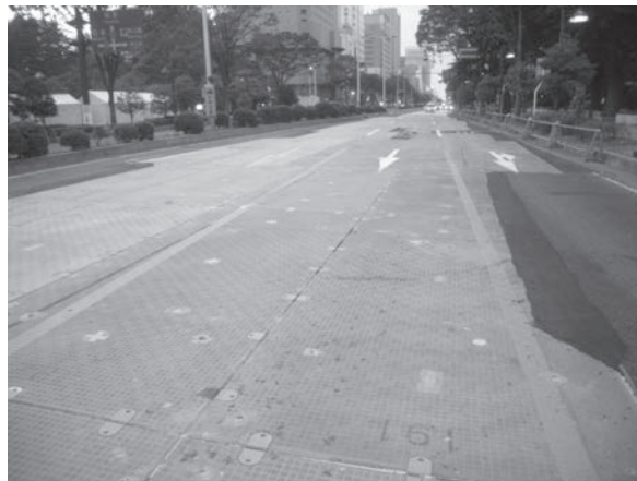
写真一七 「本舗装版」設置後 仮開放状況
