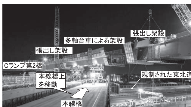
写真-1 多軸台車による一括架設
