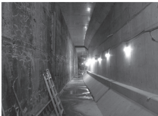
写真—6 (軌道階部 撤去前)
