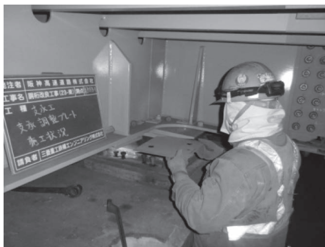
写真一 11 調整プレート挿入状況
