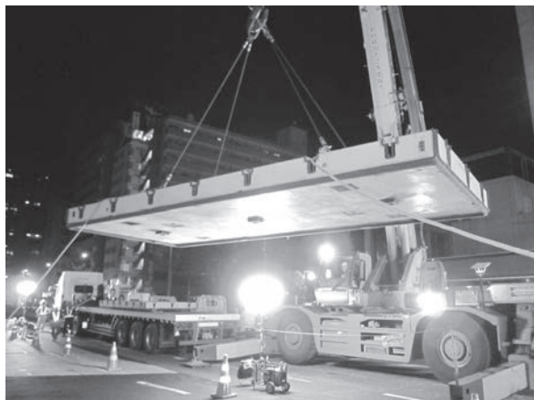
写真一六 「本舗装版」設置状況
