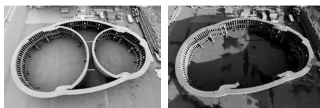
写真—1 アーチセグメント仮組み
