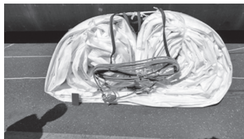
写真—1 防水シート搬入時の形状
