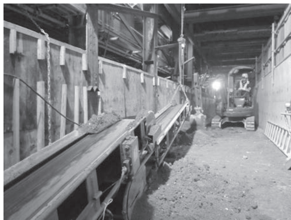
写真—10 路下ヤード埋戻し状況
