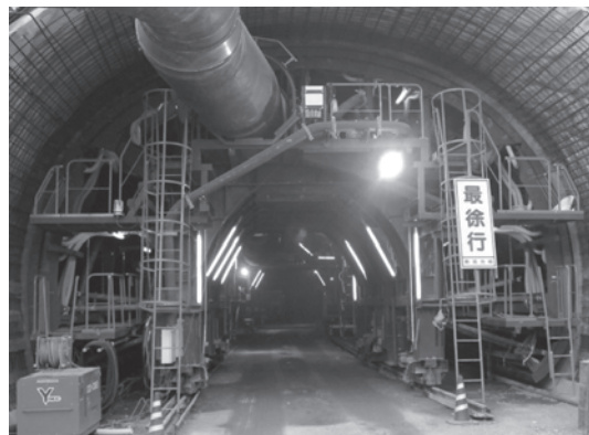
写真—1 セントル全景
