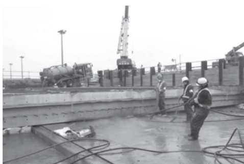
写真—5 砂型枠の撤去状況
