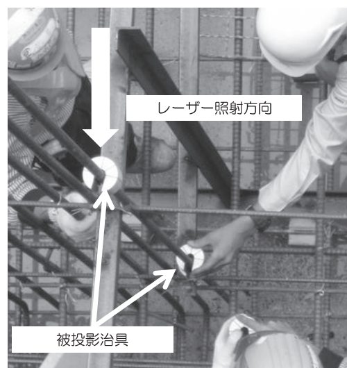
図—2 レーザー照射状況
