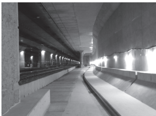
写真—7 (軌道階部 撤去完了後)
