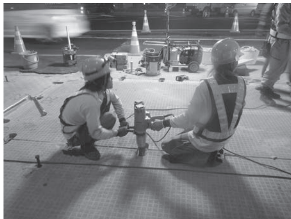
写真一九 コッター式継手締付け状況
