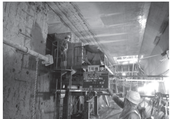
写真一2 コンクリートブロック引き出し状況
