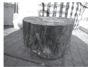
木製電柱下部
