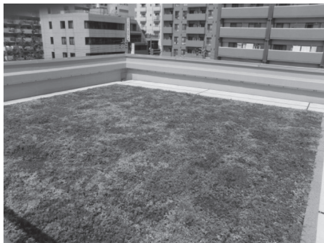
写真一3 セラミック基盤上の屋上緑化
