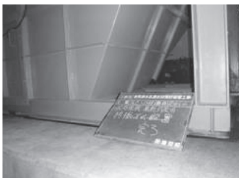
写真—9 防振ゴムシート設置状況
