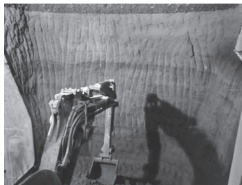
写真—1 下床桁切羽状況
