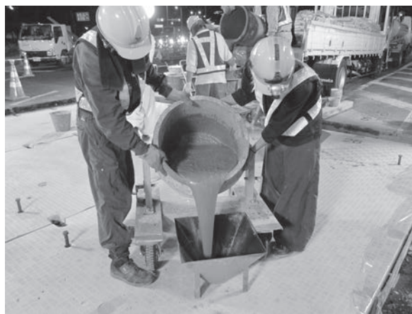
写真一八 裏込めグラウト注入状況
