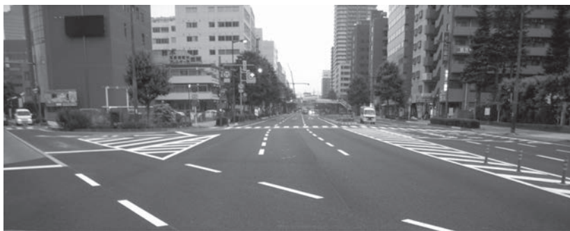
写真—10 「本舗装版」による道路補修完了
