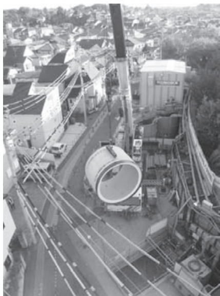
写真—1 発進基地全景
