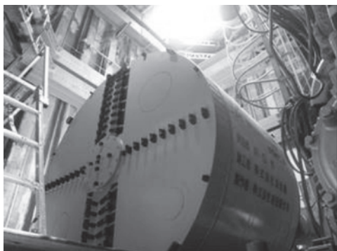
写真一12 掘進機設置状況（下段管施工時）
