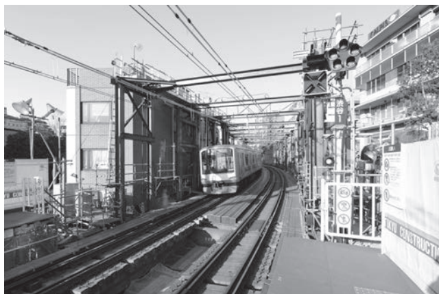
写真—1 地下化切替前
