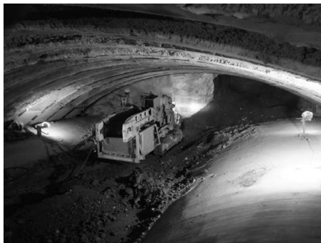
写真—2 上半部掘削状況
