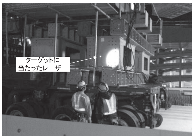
写真—4 レーザーによる確認
