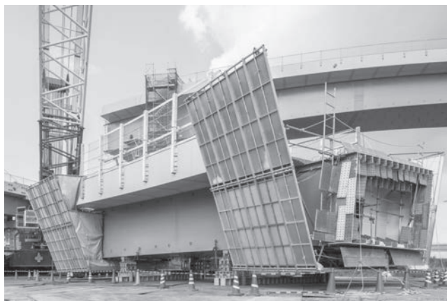
写真—5 先行設置された足場
