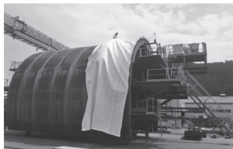
写真—4 バルーンによる押し上げ時の状況
