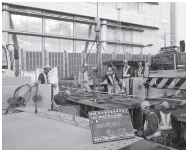
写真一 10 撤去状況
