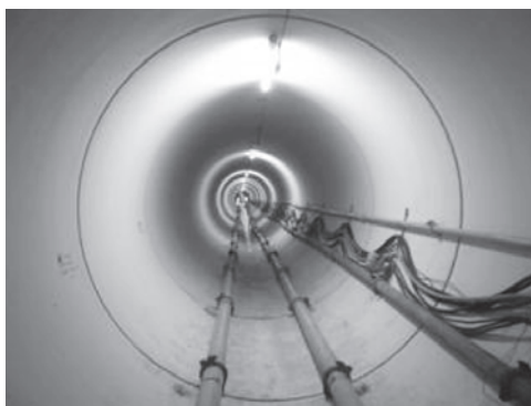
写真一14 推進管内状況
