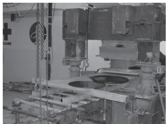
写真一四 免震装置・フラットジャッキのセット
