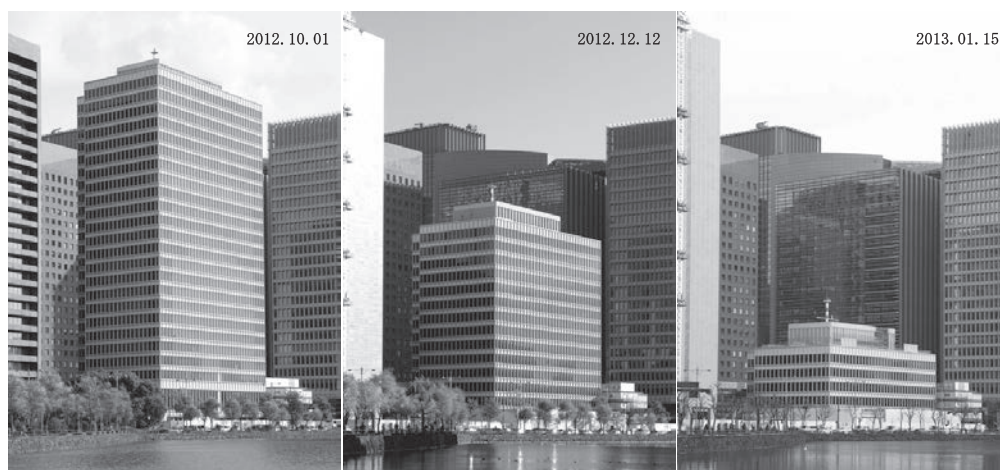
写真—1 本工法による解体工事中の外観
