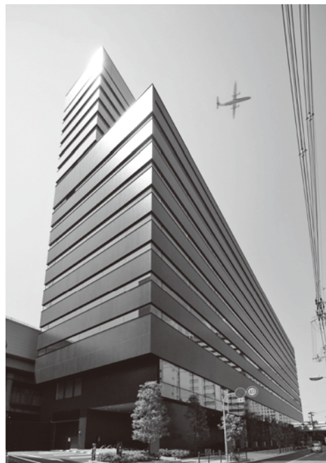
写真—1 建物外観
