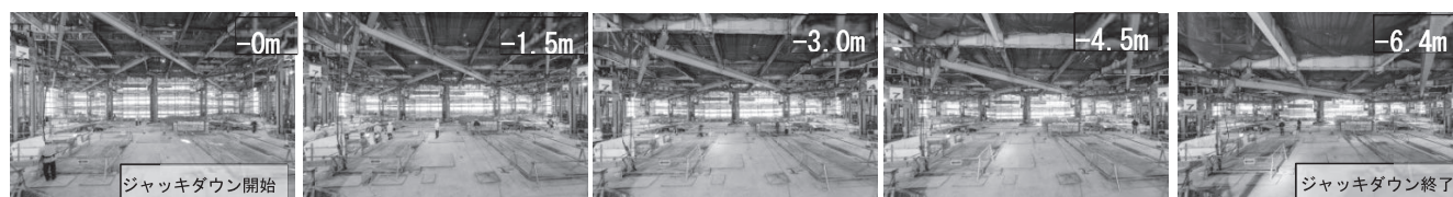
写真-8 ジャッキダウン実施状況（内観）
