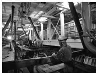
写真一 5 インバート施工
