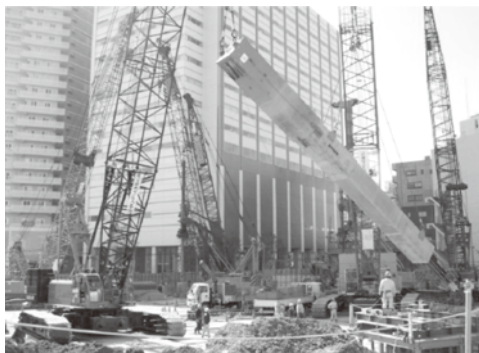
写真—2 HSPC 構真柱の建て起し状況
