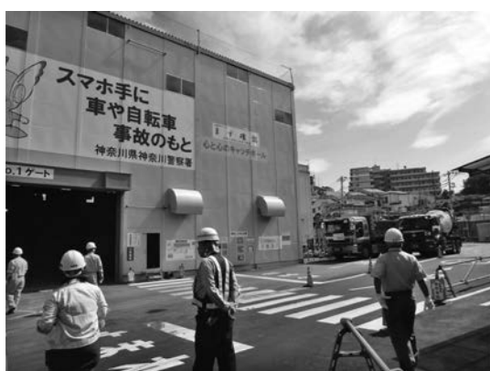
写真一 2 工事現場と周囲の住宅
