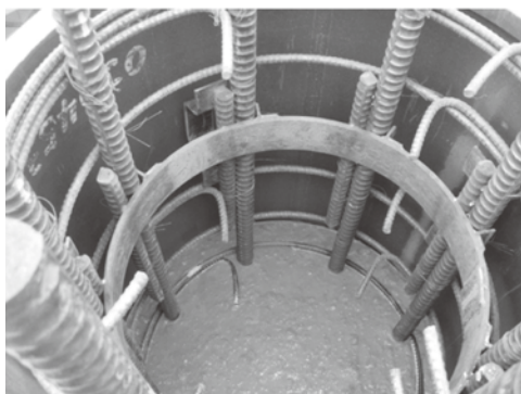
写真一7 コンクリート充填状況 (8階床より)
