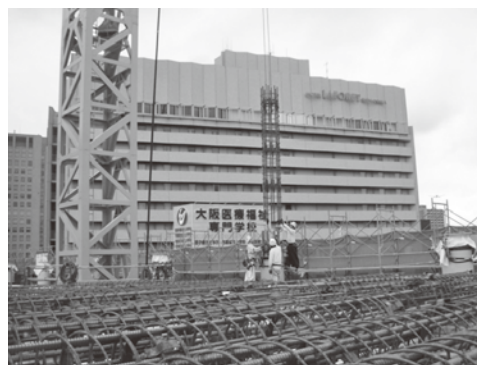
写真—3 内蔵鉄筋柱設置状況 (8F より) (STEP2)
