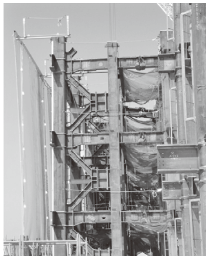
写真一9 先行ネット設置状況
