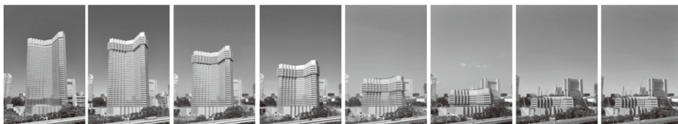
写真-9 ジャッキダウン実施状況（外観）
