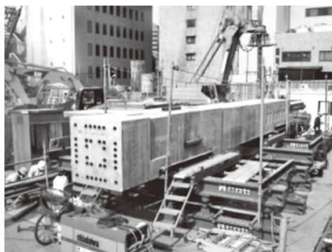
写真—1 HSPC 構真柱の地組み写真
