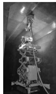
写真―1 施工状況
