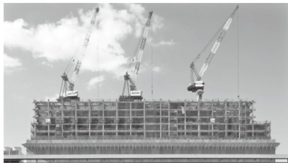
写真一8 鉄骨建方状況 (南面)
