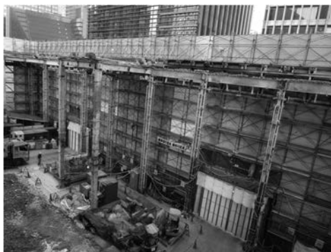
写真-3 仮囲い設置状況
