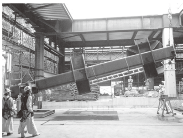
写真—11 仮設開口での柱建方状況
