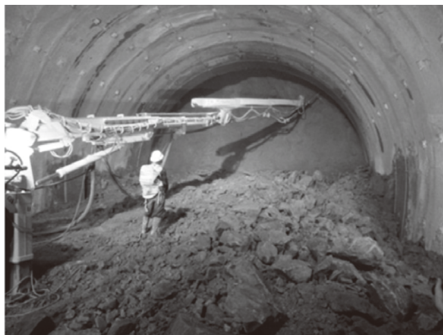
写真—1 堆積ズリ後方からの吹付け作業状況
