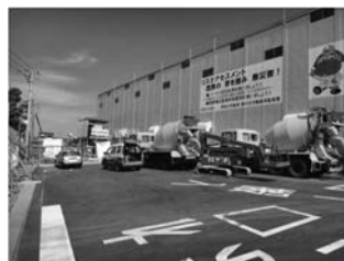
写真一 3 防音ハウス
