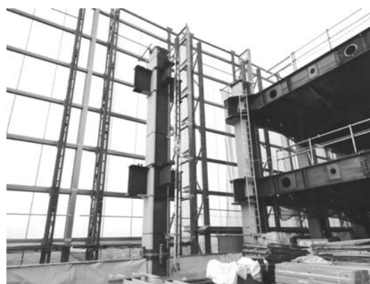
写真—4 スライドカバー（鉄骨建方中）
