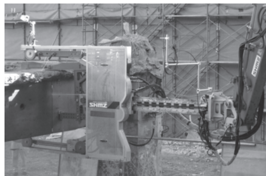
写真—5 本切断装置
