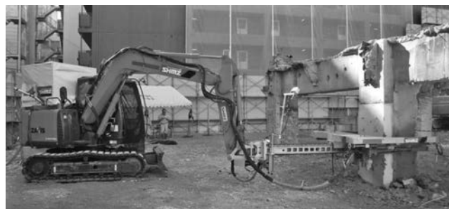
写真一六 柱切断状況
