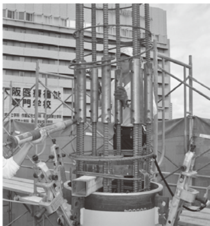
写真一4 内蔵鉄筋接合状況 (STEP2)
