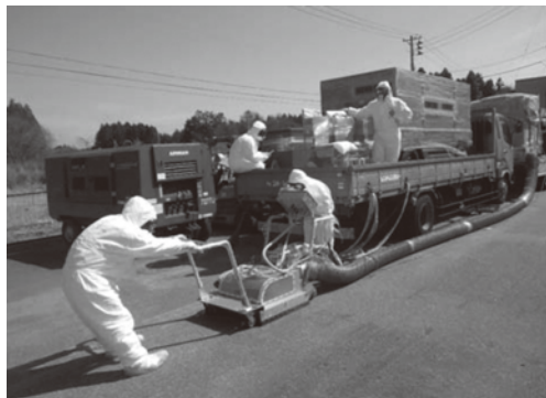
図一 6 実証試験状況
