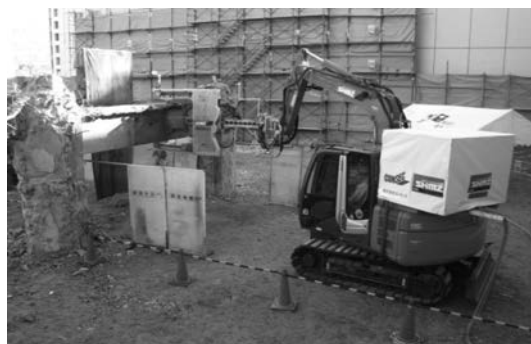
写真一七 大梁切断状況
