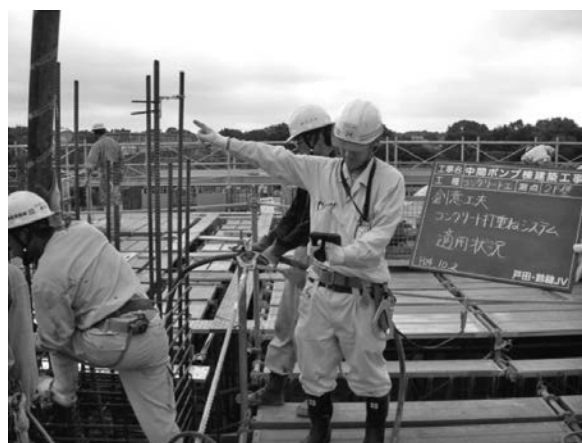
写真－2 現場適用状況
