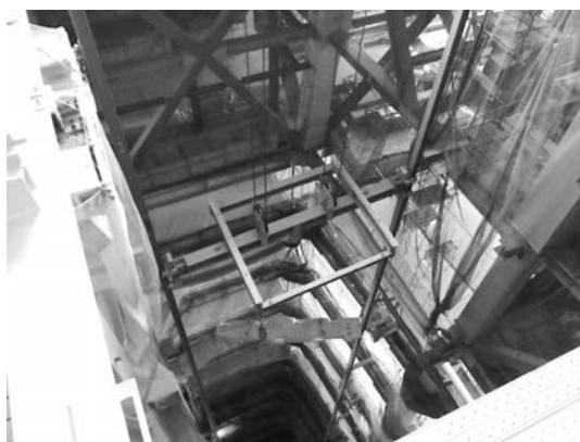
写真—2 25t吊テルハ（揚重時）
