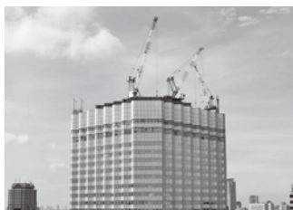
写真一 4 仮設クレーン
