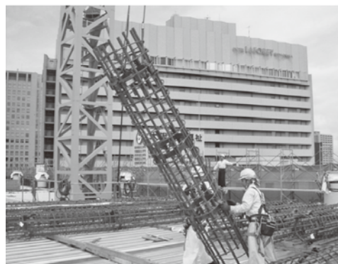
写真—2 内蔵鉄筋吊込状況 (8F より) (STEP1)
