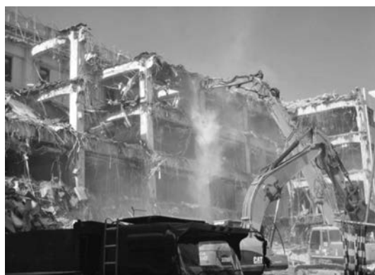
写真1 従来の破断・粉碎解体工法
