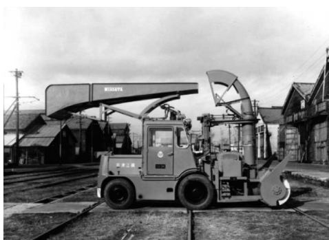
写真 2-24 (株)新潟鐵工所 (注3) スノーローダ NMR-1 昭和 38 年
