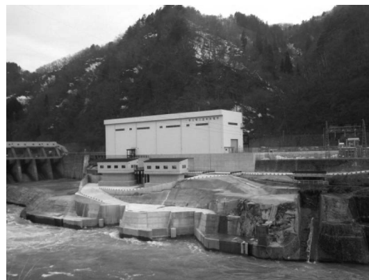
写真—9 豊実発電所竣工状況
