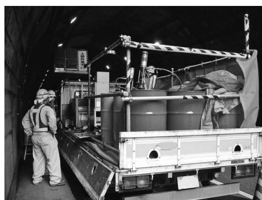
写真—4 注入設備積載状況
