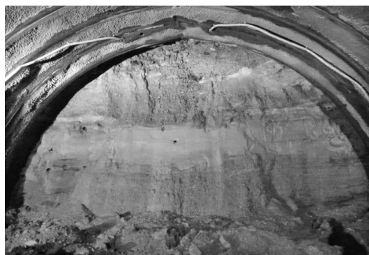
写真一2 適用したトンネルの切羽 (未固結堆積岩)
