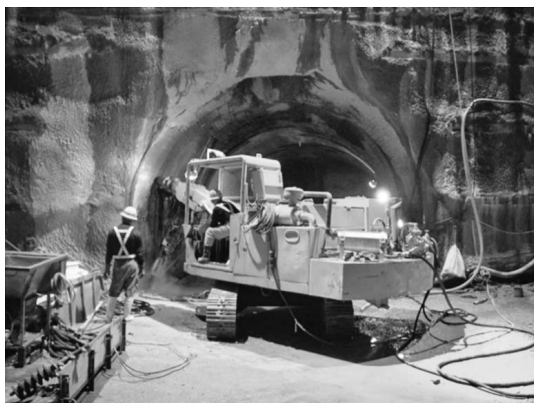
写真一4 縫地ボルト施工状況
