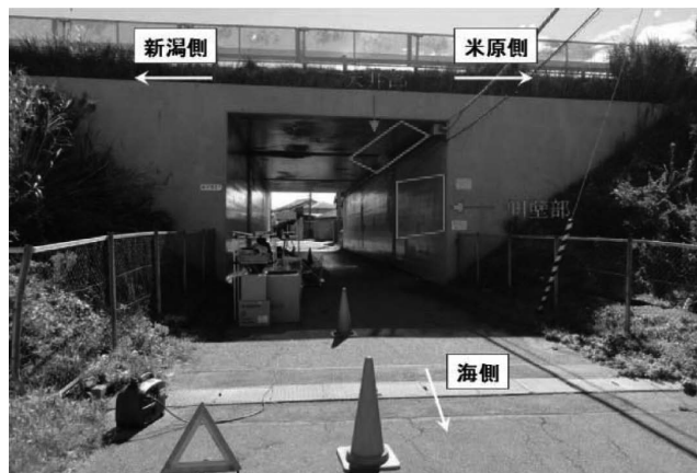
写真一2 音響探査を実施したボックスカルバート
