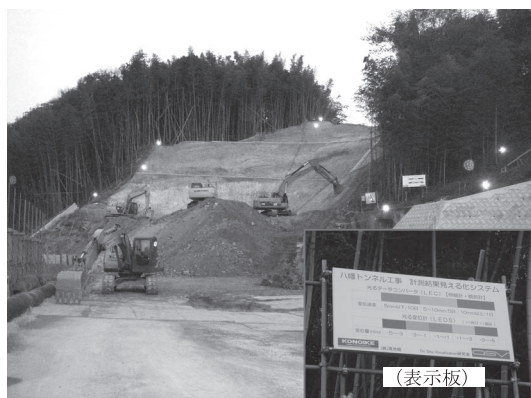
写真—2 計測器設置状況
