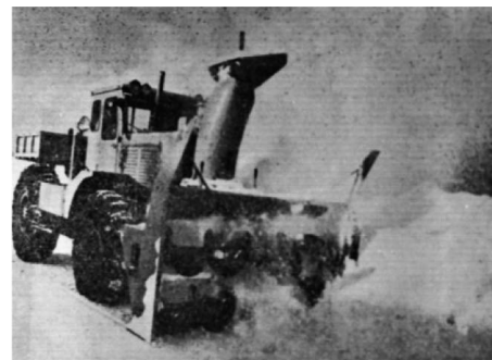
写真 2-13 WTR 型ロータリ除雪車
