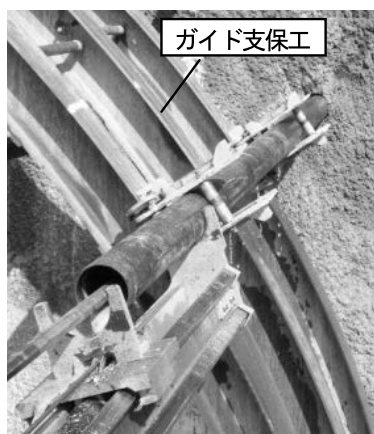
写真三 特殊鋼管受け治具使用状況
