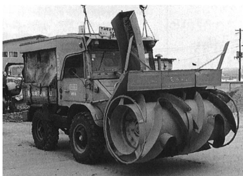
写真 2-15 シュミットカッタ型ワンステージ 走行動力 32PS、作業動力 110PS シュミット社 昭和 37 年 2)
