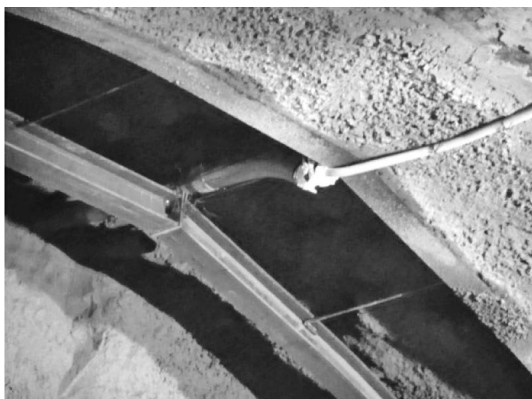
写真—3 設置状況
