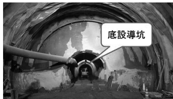
写真—4 底設導坑の施工状況
