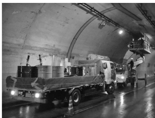
写真—1 道路トンネル施工状況
