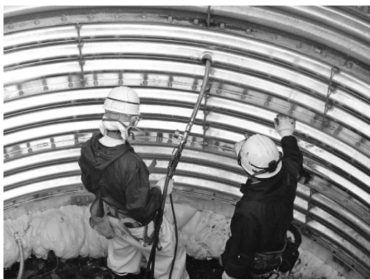
写真—6 深礎杭での施工状況
