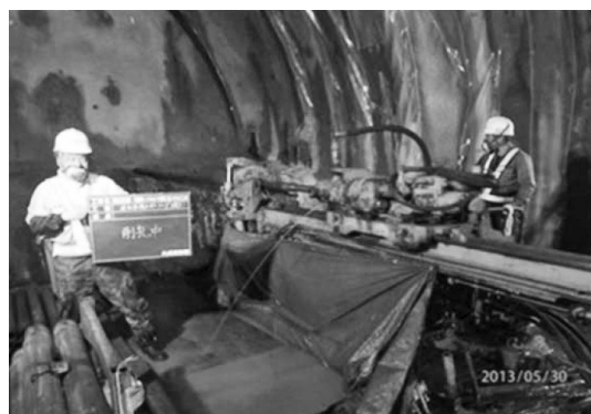
写真－3 水抜きボーリング施工状況
