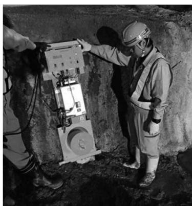
写真－2 測定機器の設置状況
