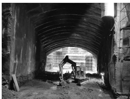
写真一7 発電所側掘削完了
