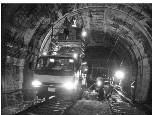
写真—2 鉄道トンネル施工状況
