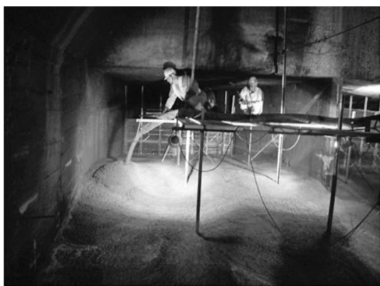
写真一5 既設放水路充填状況
