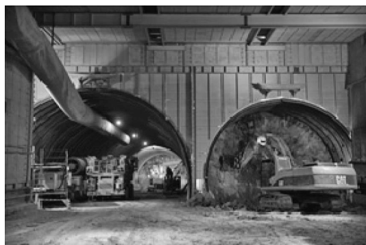
写真－1 トンネル施工状況
