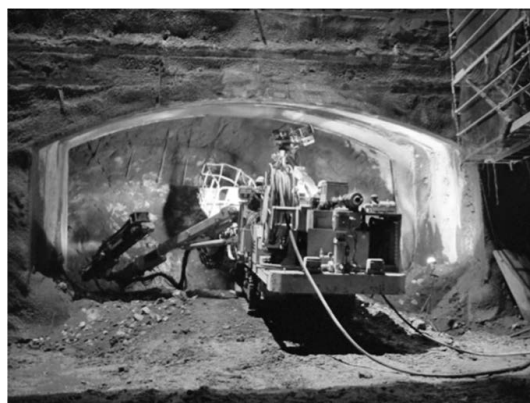
写真一6 放水口側削孔状況
