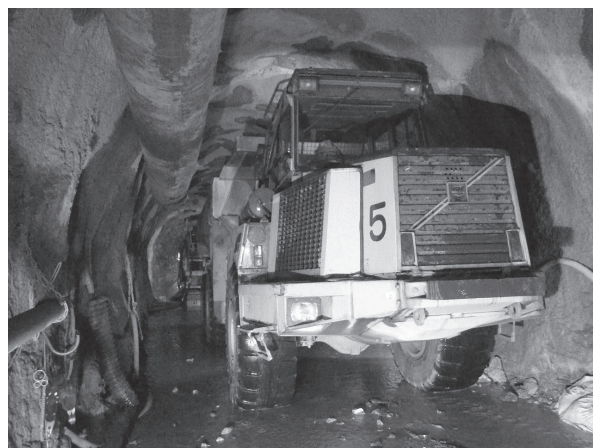
写真—3 25 t ダンプによるブリ出し状況
