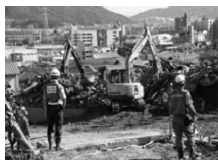
地元建設業と連携した土砂撤去
