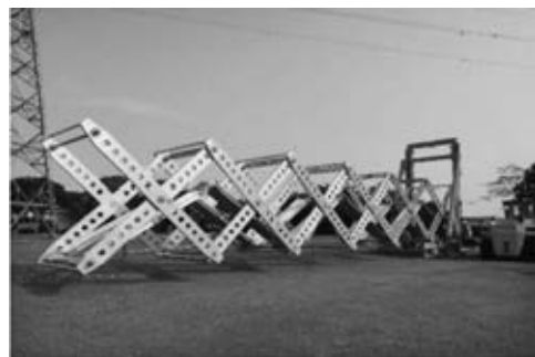
写真—3 緊急仮設橋の開発
