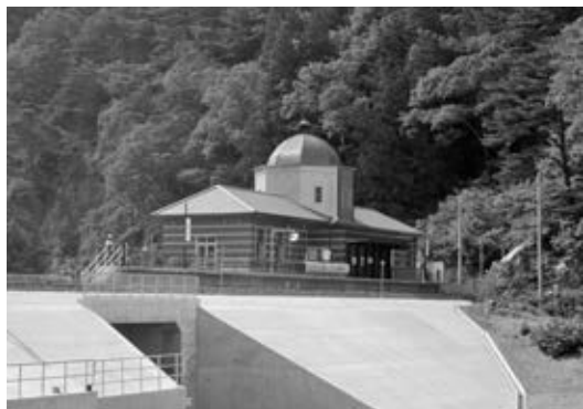
写真—7 津波の影響の受けにくい位置に移動した新島越駅
