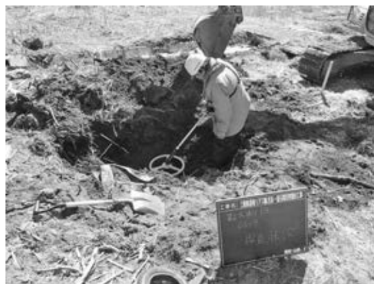
写真-4 陸上部の不発弾調査状況
