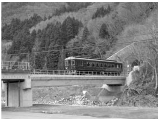
写真-2 荒川橋りょうの復旧状況
