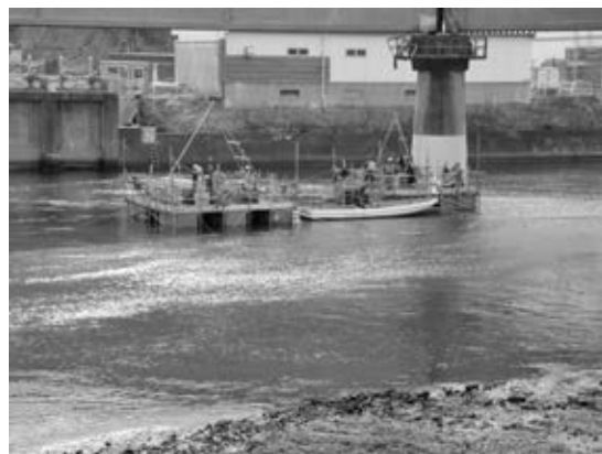
写真-5 河川部の不発弾調査状況
