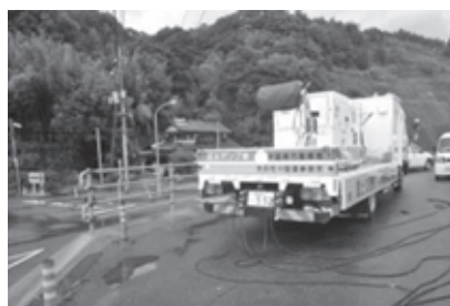
緊急排水のため排水ポンプ車出動
