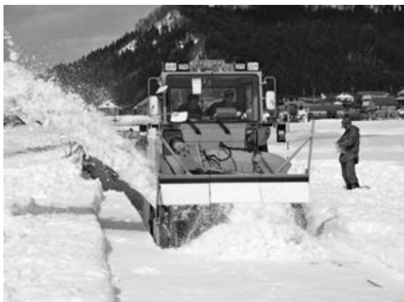
写真一 7 ロータリ除雪車試験状況
