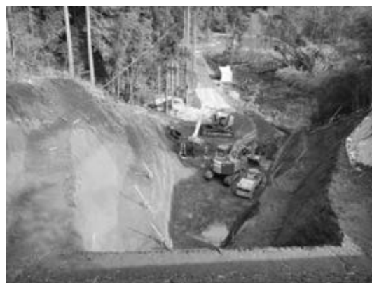
写真－4 最下層部の施工状況
