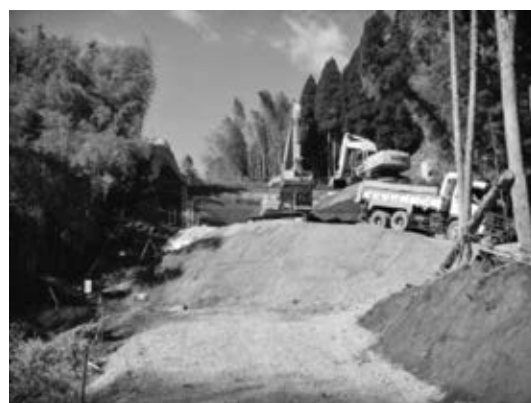
写真－5 盛土下層部の施工状況
