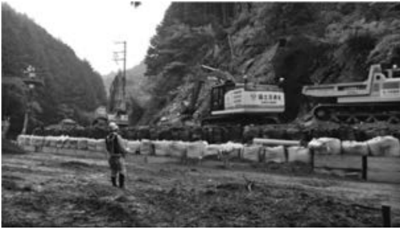
写真—3 近畿地方整備局貸与機械による土砂災害復旧状況
