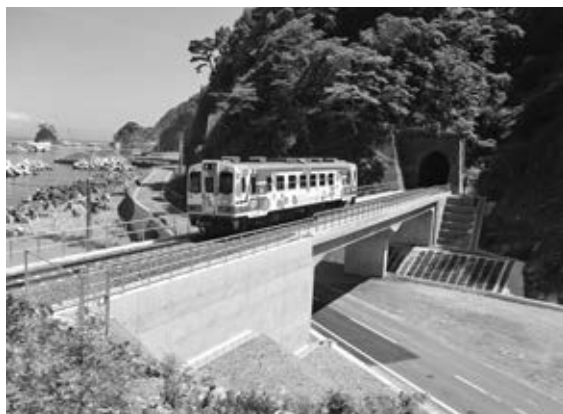
写真—8 コイコロベ沢橋りょうの復旧状況
