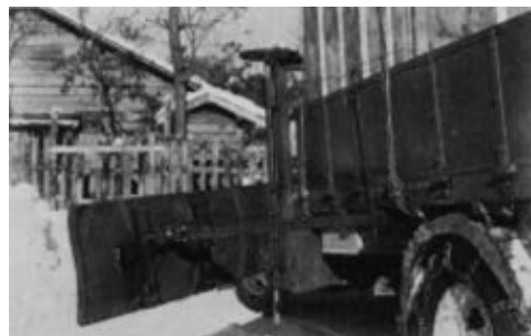
写真 3-2 トラック用補助翼（サイドウイング） 北海道庁 昭和19年 1)
