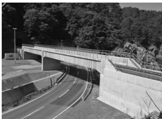
写真—9 ハイペ沢橋りょうの復旧状況
