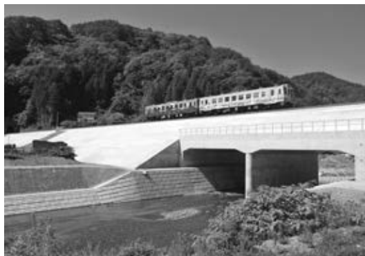
写真—6 島越付近の復旧状況
