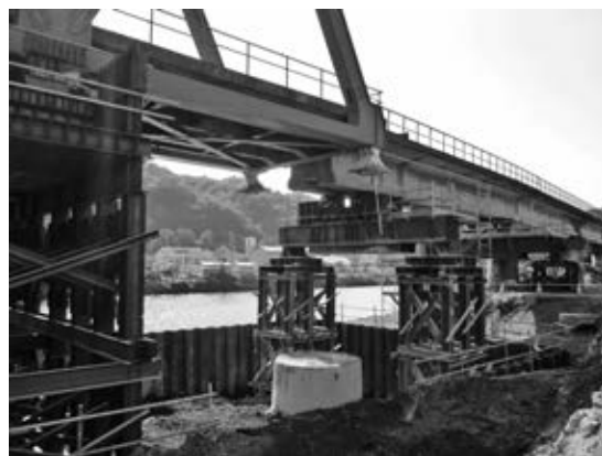
写真-3 中番庫高架橋P1橋脚躯体の復旧状況
