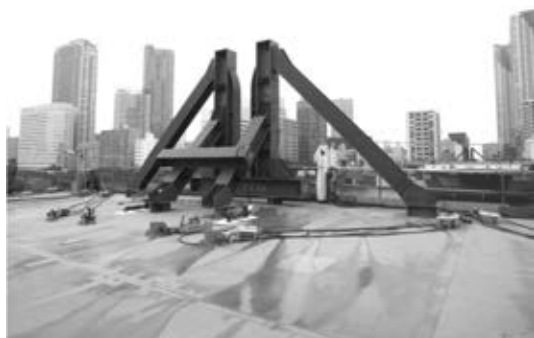
写真—9 側径間に設置したガイド装置（ノーズ受け台）
