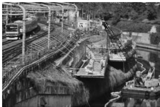
写真—3 張出式固定足場の設置例
