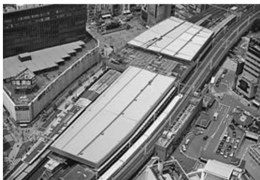
写真—1 大屋根（外観）
