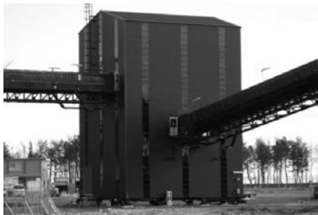
写真—4 乗継建屋全景
