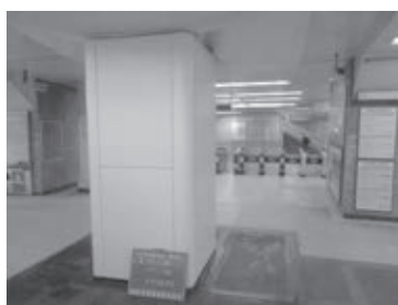
【養生パネル設置】
