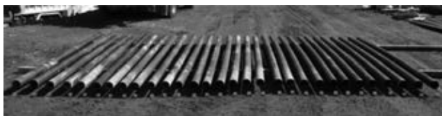
写真—2 使用後の端末管（約4 回転用後）
