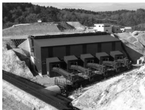
写真—1 破砕設備全景
