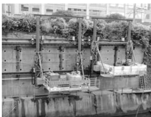
写真一八 稼働を開始した移動式足場
