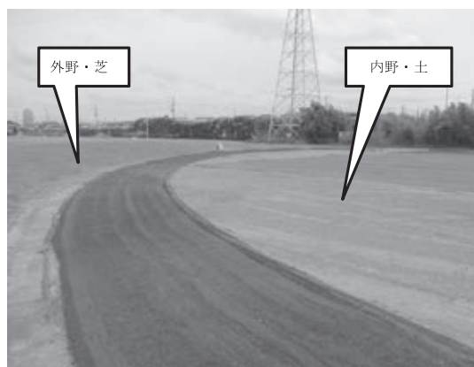
写真—10 曲線部での施工
