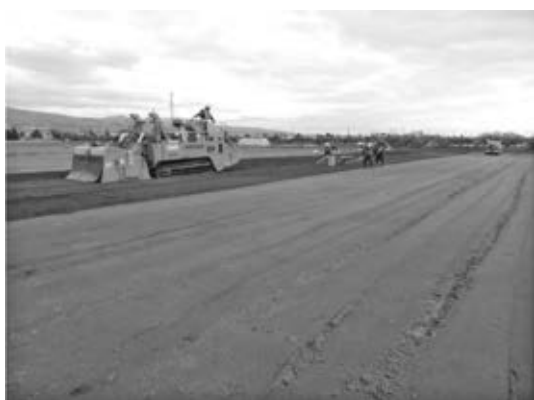
写真—14 本開発機施工・仮転圧状況
