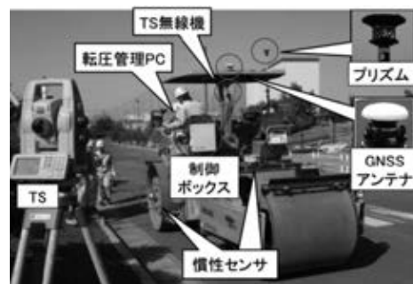
写真-1 機器の取り付け状況
