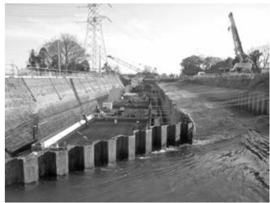
写真一三 左岸構築状況
