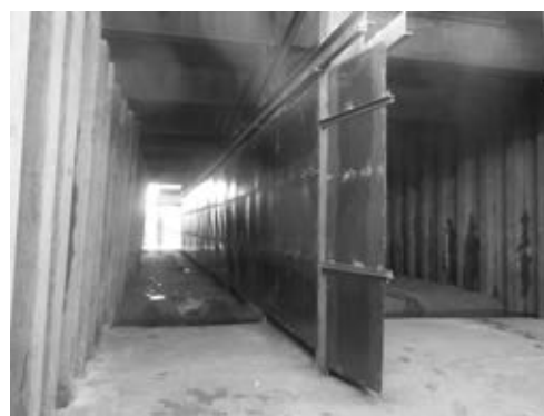
写真—7 杭間整流板設置
