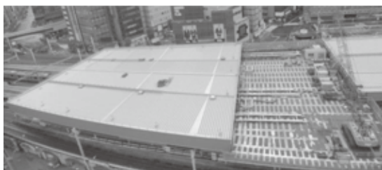
東京方スライド6回目完了
