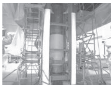
【リフトアップ作業】
