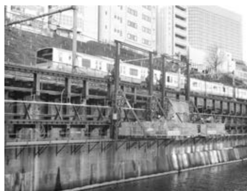
写真一九 90°で設置した箇所の状況
