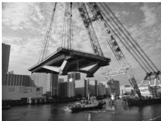
写真一 4 勝どき側側径間大ブロック架設状況
