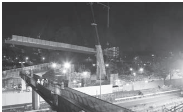
写真—2 鋼桁一括架設状況
