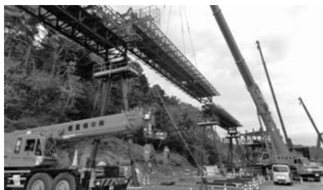
写真一9 ベルトコンベヤ設置状況
