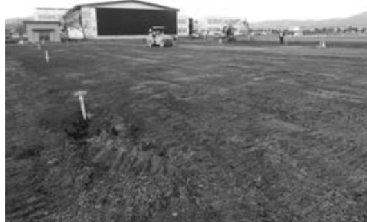
写真—12 中学校グラウンド改良前の整地状況
