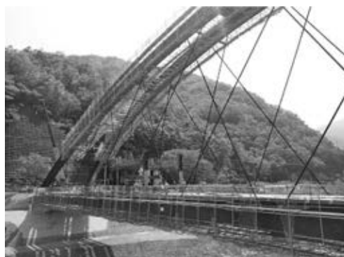
床版架設状況
