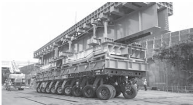
写真—4 撤去桁模倣試験
