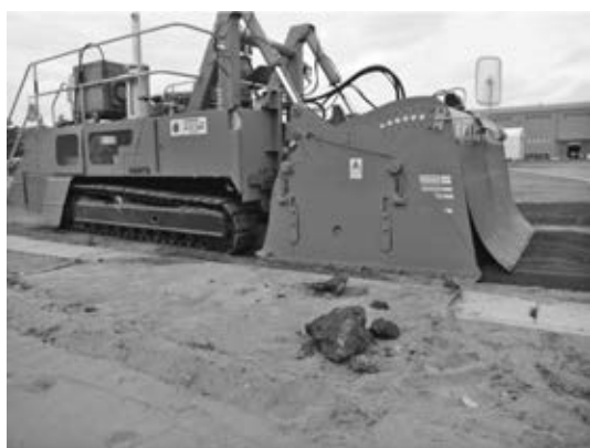
写真—9 土中から排出された転石
