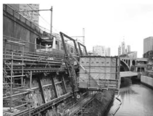
写真一〇 70°で設置した箇所の状況
