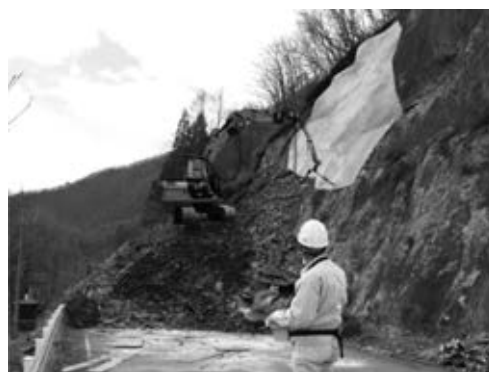
図—2 遠隔操作施工イメージ
