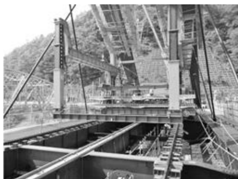
PC 床版架設機
