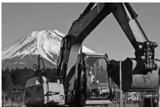
写真—1 機械施工実習
