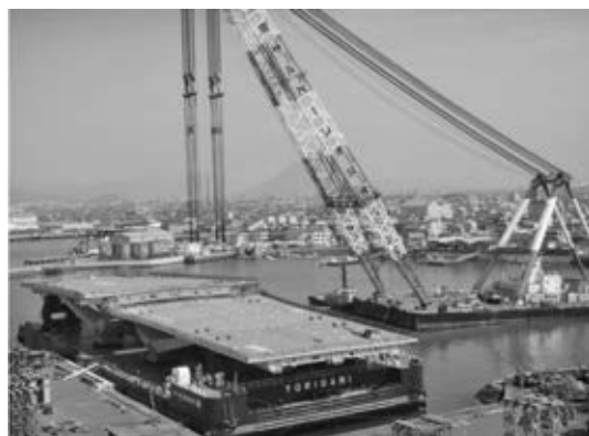
写真一 側径間大ブロックの台船搭載
