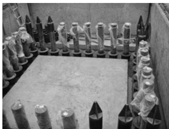
写真一 5 鉛筆状アンカーボルトガイド治具
