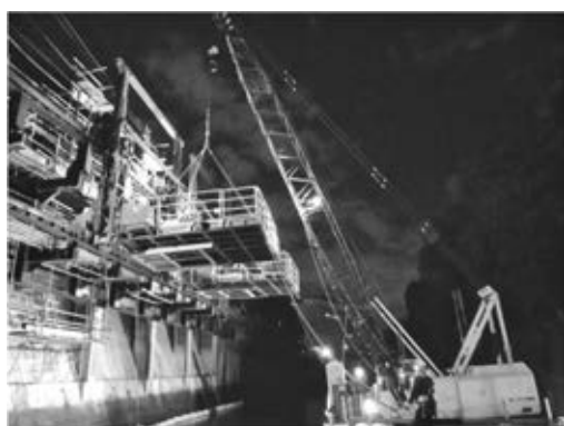
写真一七 作業床設置状況（河川より）
