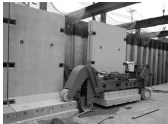
写真一四 プレキャスト擁壁据付状況
