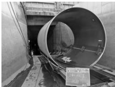
写真—9 鋼管挿入状況
