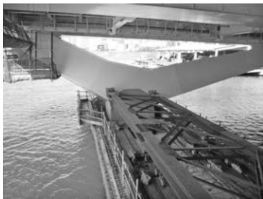
写真—1 架設完了後の連結材
