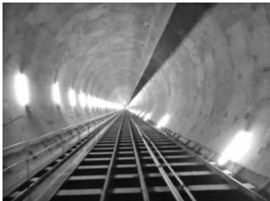
写真—11 坑内仕上り状況
