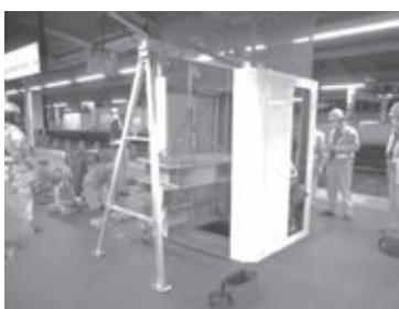
【ダイヤフラム取付（ホーム階）】
