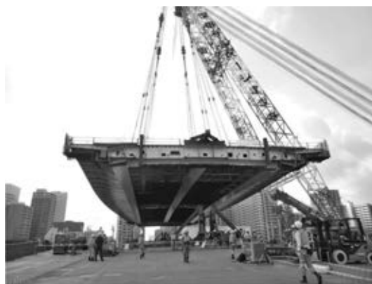
写真—10 中央径間閉合状況
