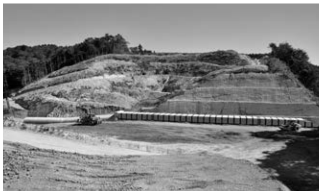
写真一6 JR 交差部ボックスカルバート
