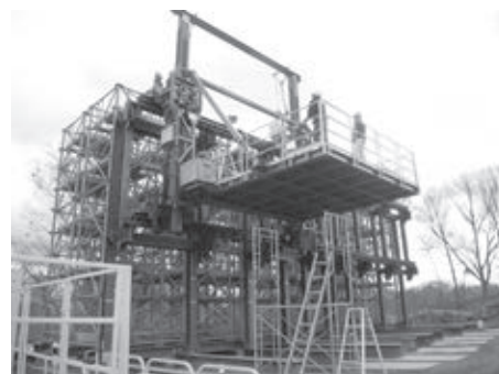
a) 移動足場上昇時の状況
