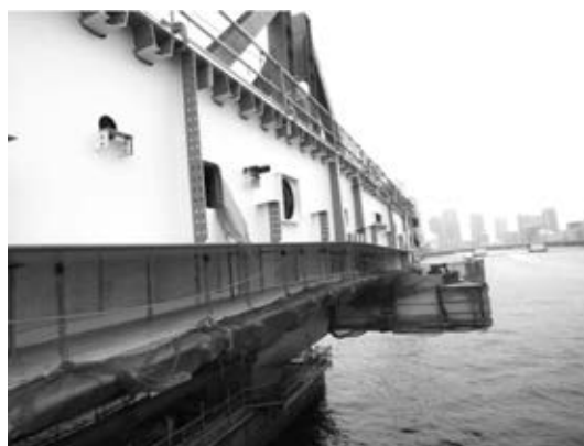
写真一8 側径間側に設置した仮受け台
