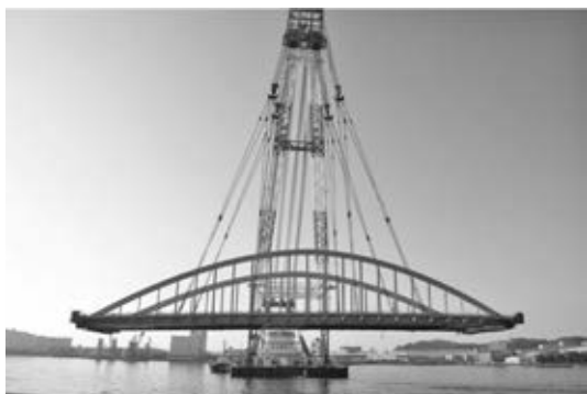
写真一6 中央径間大ブロックの吊り上げ状況
