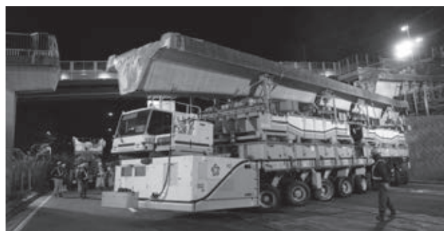
写真—6 桁搬出状況
