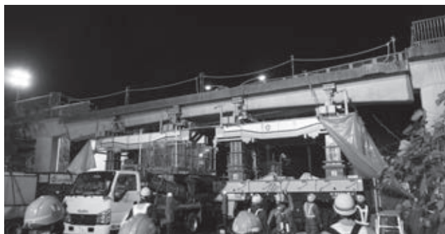
写真—5 ジャッキダウン状況
