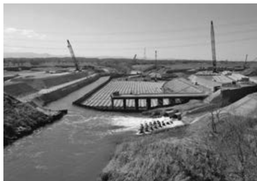
写真—10 護床ブロック施工状況
