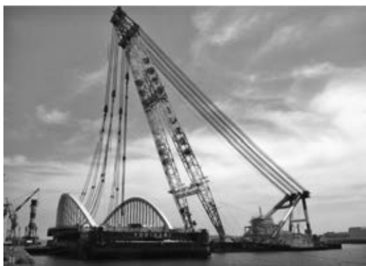
写真一7 中央径間の台船搭載状況
