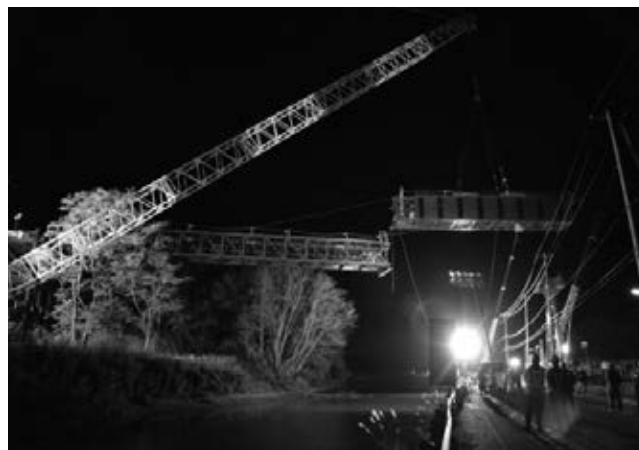
写真一8 750t クレーンによる架設状況
