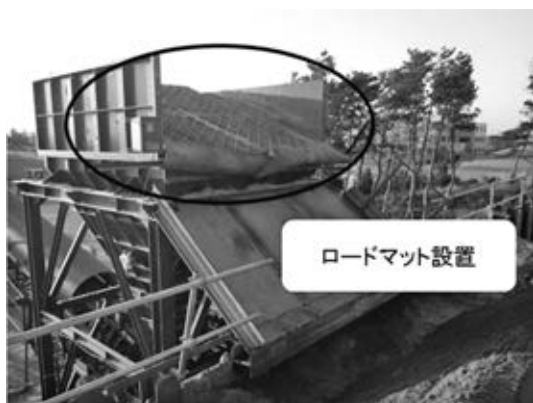
図—10 CSG 材2投入ホッパロードマット設置状況
