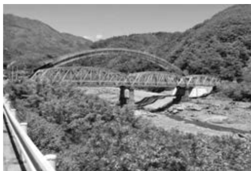
現早川橋（手前）と架設中の新早川橋
