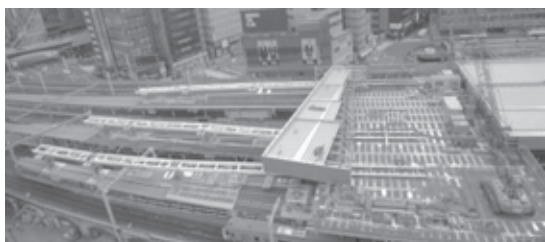
東京方スライド1回目完了
