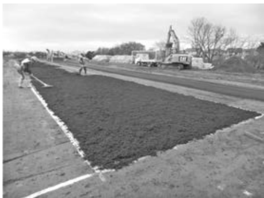
写真—13 改良材敷均し状況
