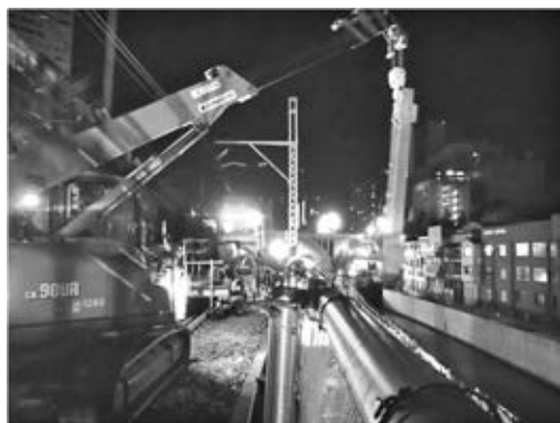
写真一六 縦梁設置状況（線路内より）
