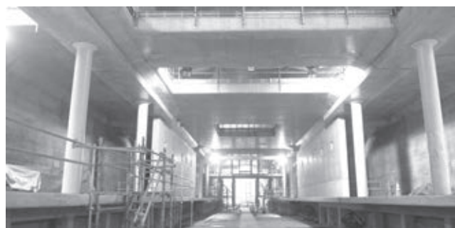
写真—7 本体駅舎躯体（軌道・ホーム階）
