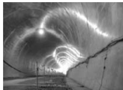
覆工コンクリート仕上がり状況
