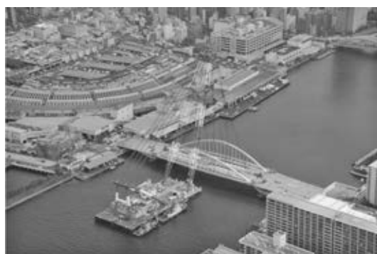
写真—11 中央径間一括架設状況
