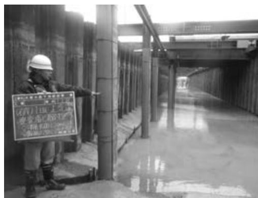
写真—6 塩ビ管挟み込み
