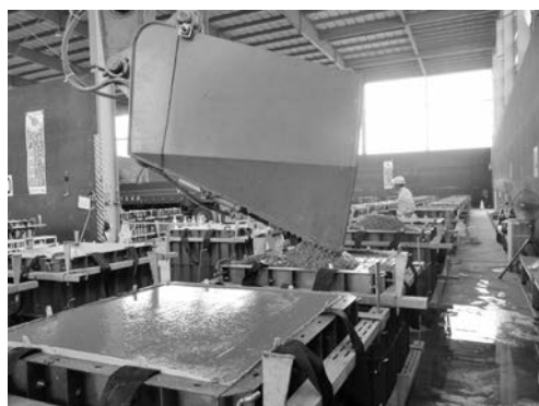
写真—6 全天候型の打設・養生ヤード
