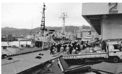
写真—2 地震直後の神戸港における緊急物資の荷揚げ
