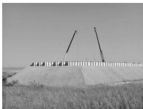
写真—8 本ブロックの活用事例
