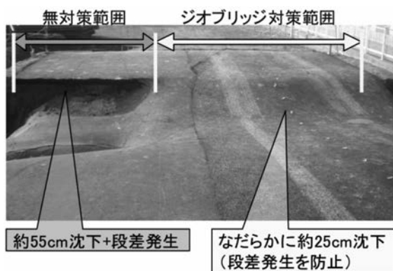
写真—3 H鋼引抜後の路面状況
