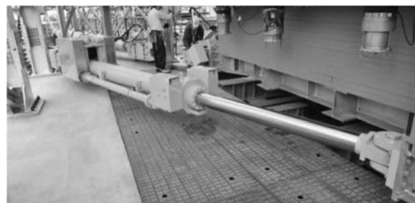
図-6 オイルダンパーの外観写真
