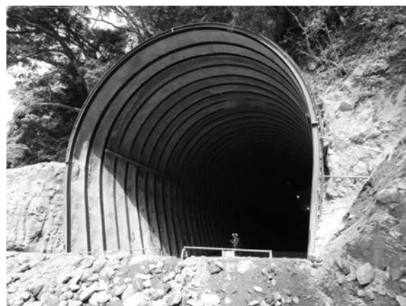
写真—3 工事状況（転流工吐き口）
