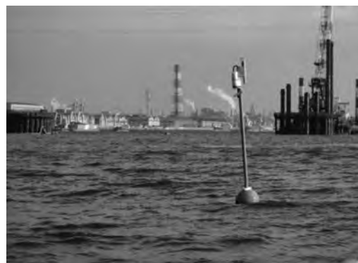
写真—4 通信制御装置の設置状況
