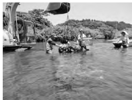
写真—3 重機による設置
