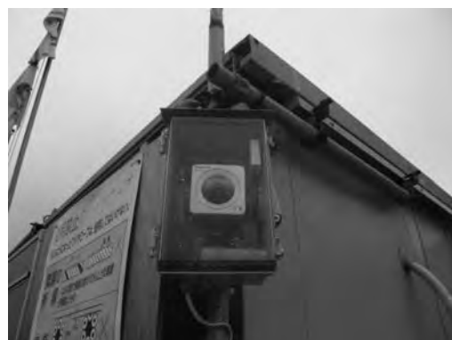
写真—5 工事以外の船舶を監視するカメラ
