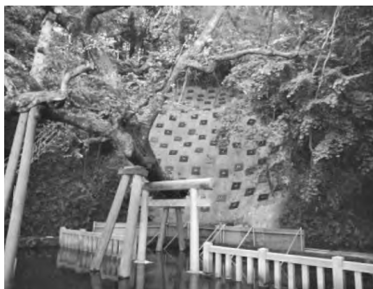
写真—9 鉄筋挿入工による安定化
