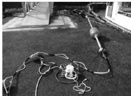
写真—3 本監視システムの全景
