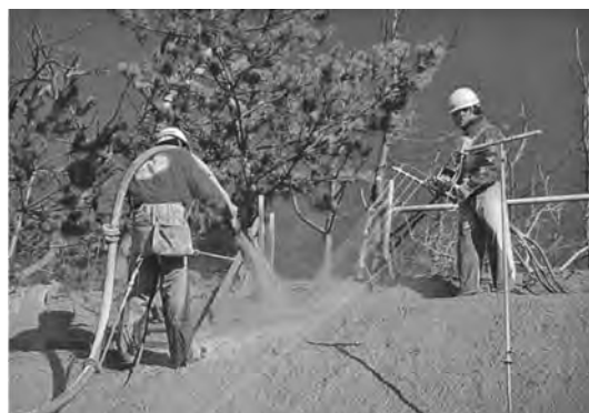
写真—1 連続繊維補強土工の施工状況
