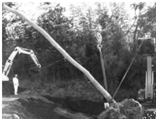
写真-2 景観木の移植工事
