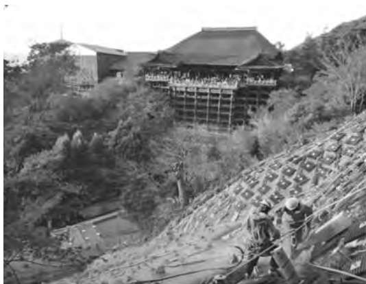
写真—4 「音和の瀧」近接斜面での連続繊維補強土工施工状況 (平成 26 年)
