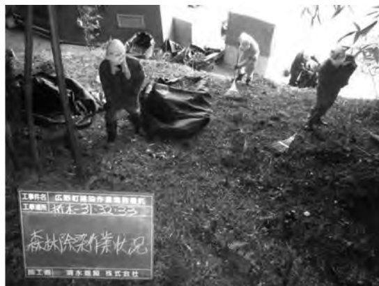
写真—2 落葉等の除去作業
