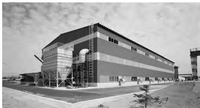
写真—2 建屋および付帯設備
