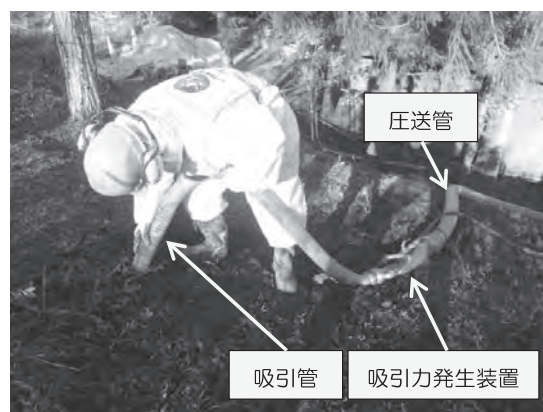
写真—10 アツメールによるほぐした腐葉土の吸引回収作業
