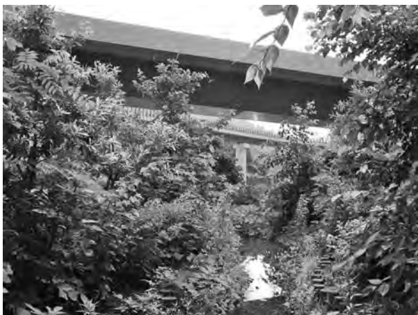
写真—4 水辺のビオトープ整備
