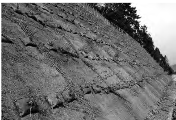
写真—9 切土のり面への植栽状況
