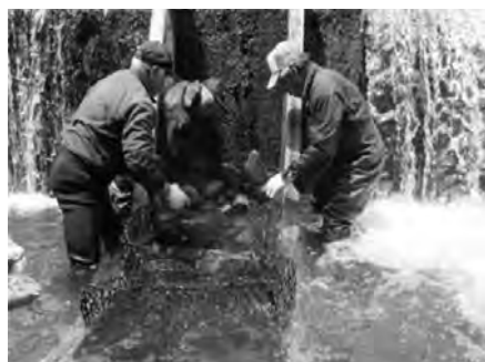
写真—18 蛇カゴ石詰
