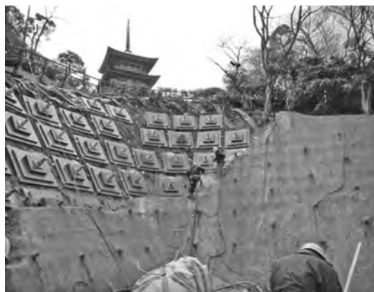
写真—6 グラウンドアンカー工による斜面安定対策と連続繊維補強土工の施工 (平成 26 年)
