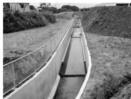
写真—9 三面張り水路 (2014年5月)
