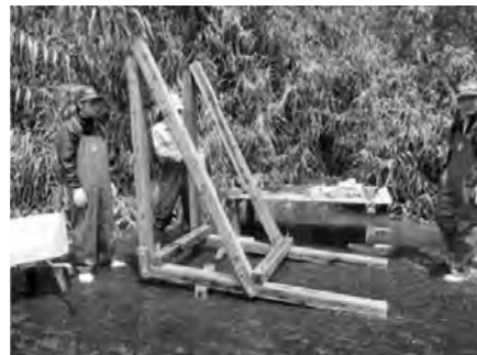
写真—17 木枠組立
