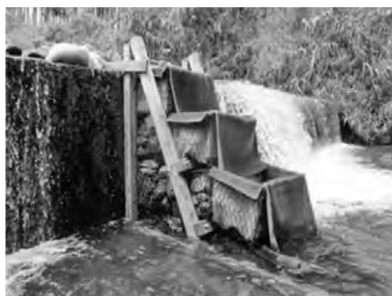
写真—19 組立完了
