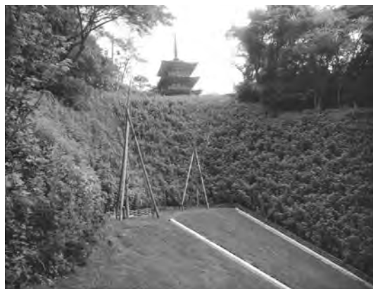
写真—7 植生工実施後の状況
