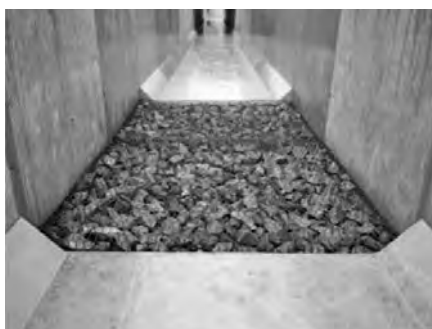
写真—8 生物生息場形成用蛇カゴ設置完了
