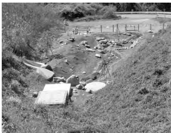
写真—4 ホタルビオトープ施工直後
