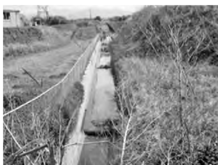
写真—10 三面張り水路 (2015年3月)
