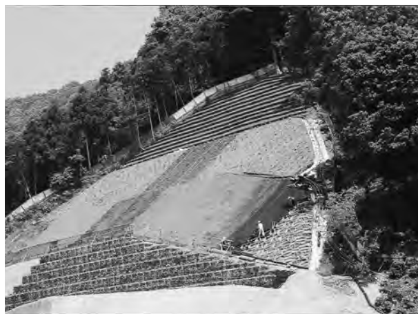
写真—6 植栽直後の切土のり面
