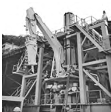
図—14 ブレイカー取付状況
