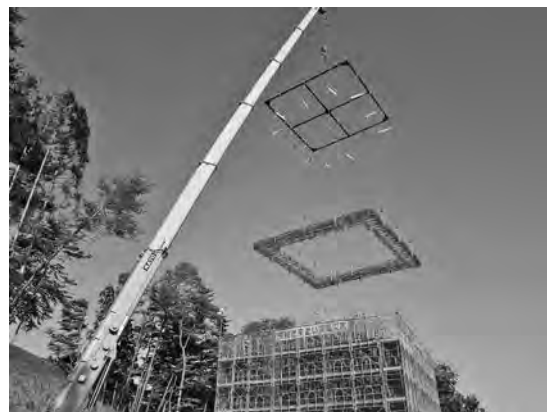
写真-4 本ユニット化工法
