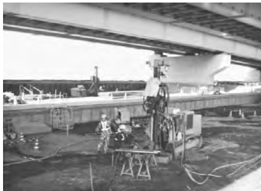
(b) 空頭制限下における施工
