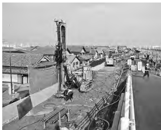
写真—2 本工法の施工状況
