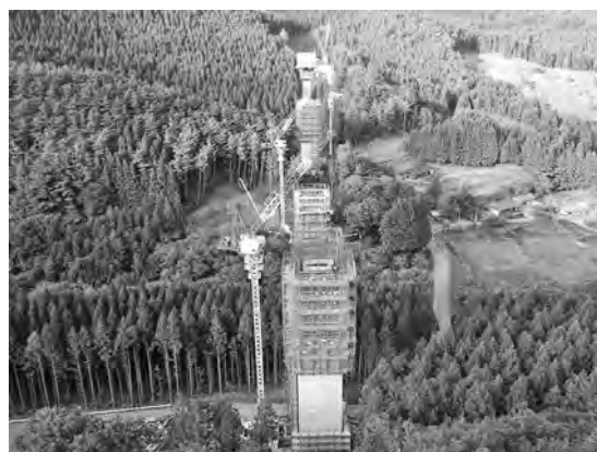
写真-3 本足場システム
