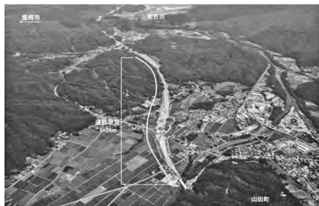
写真—1 現場全景写真
