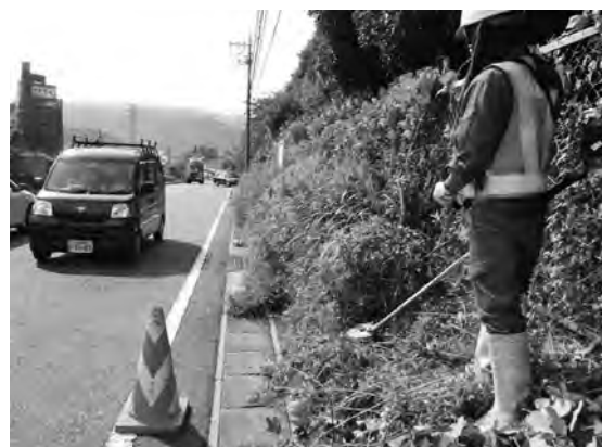
写真三 国道除草
