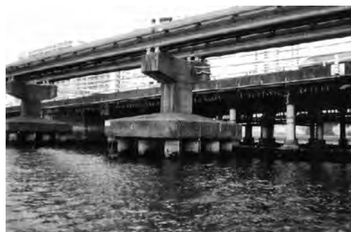
写真—1 運河内橋脚基礎（東京モノレール）
