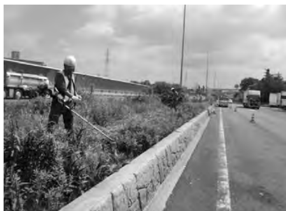
写真一 高速道路での除草
