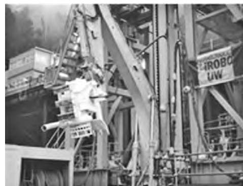
図—16 サンドポンプ取付状況
