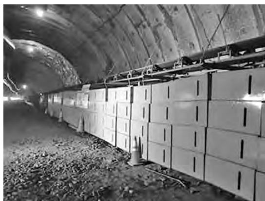
写真二 2 本吸音システム設置状況
