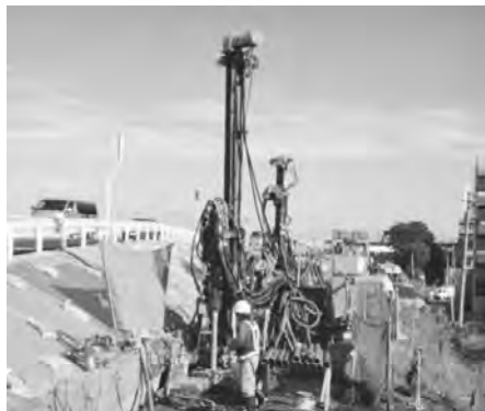
(a) 狭隘地における施工
