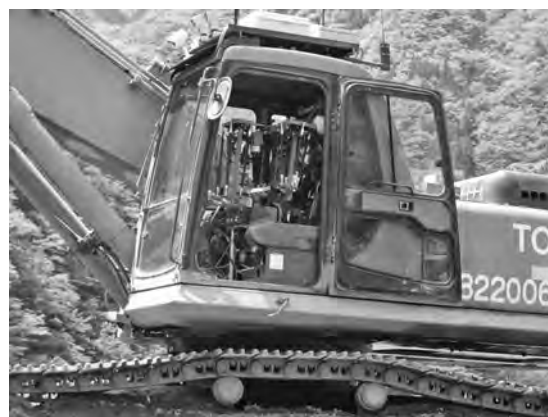
写真—1 本システム
