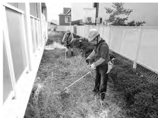
写真二 建物周辺の除草
