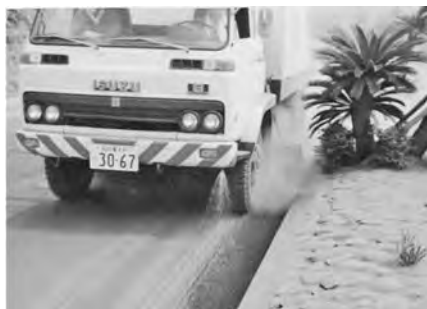
写真－1 散水テストの様子
