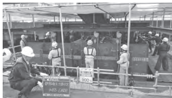
写真—2 鋼殻沈設状況
