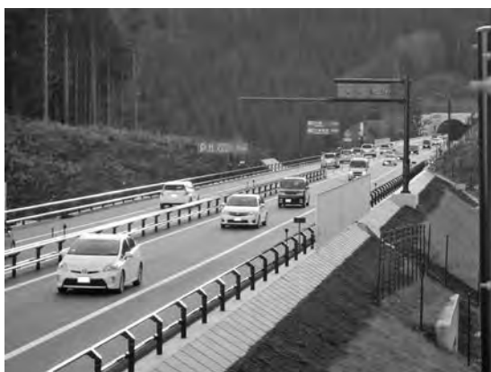
写真—8 吉浜道路の供用状況
