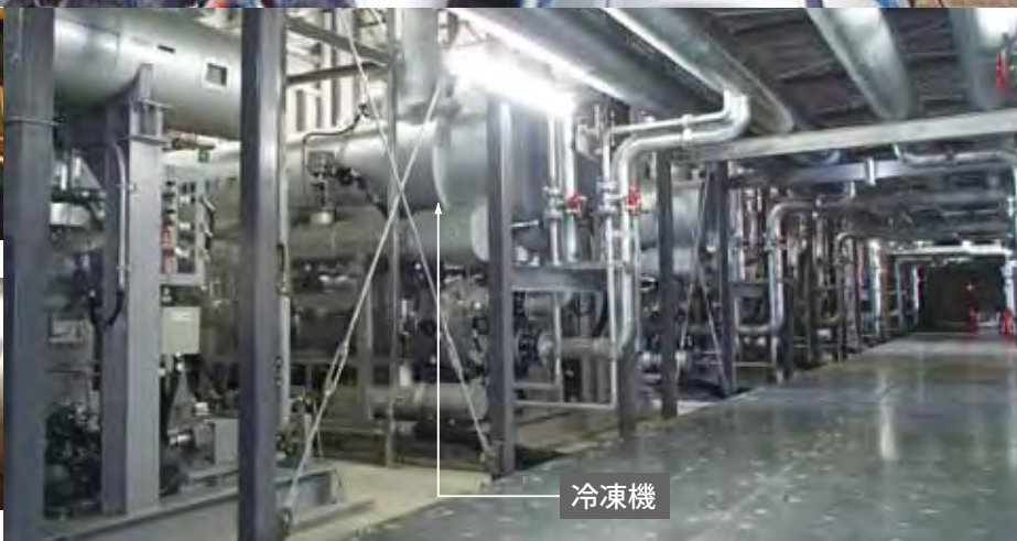
凍土方式による陸側遮水壁の造成
