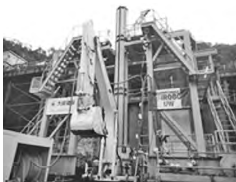
図—15 バケット取付状況
