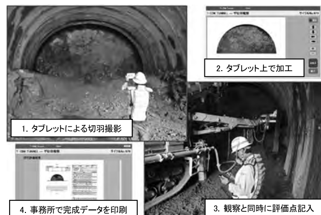
図－2 タブレット PC を用いた切羽観察
