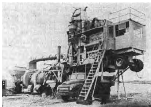
写真3-15 パーカー（英）社スタミックス37型 アスファルトプラント 能力：55～75 t/h、ミキサ容量：1 t、ダストコレクタ：横型2連式 計量機操作：空気式
