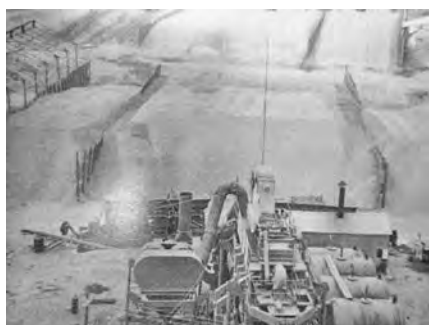
写真 3-26 フレデリックパーカー社（英）製 スターミックス 39 自動運転 60 t/h 『日本道路株 五十年史』
