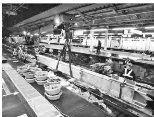
写真—13 新宿工事桁（主桁のみ）
