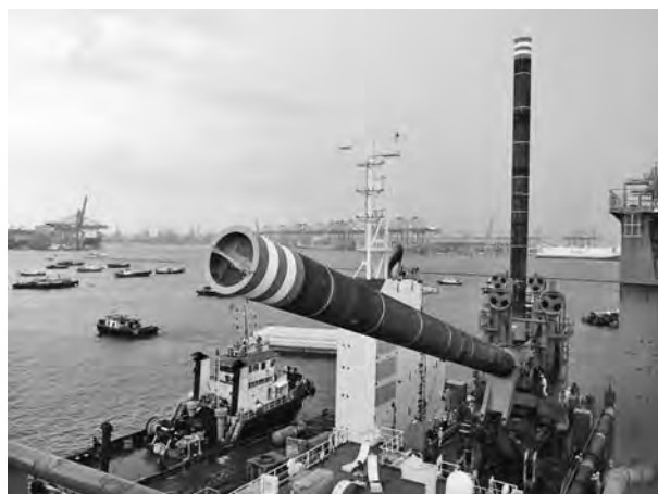
写真—5 スパッド起伏状況
