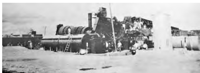
写真 3-32 バーバーグリーン社 847 型 コンテナスプラント (60 ~ 100 t/h) 名神高速道路 高槻～東伏見間舗装工事で使用 『日本舗道五十年史』
