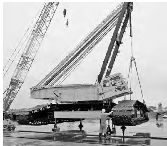
写真二 クイックドロによる組立
