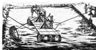
図—2 1578年の浚渫バケット
