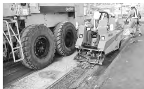
写真—1 新工法の施工現場①
