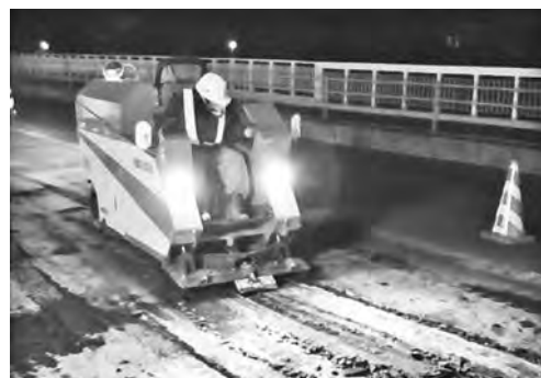
写真—3 新工法の夜間施工
