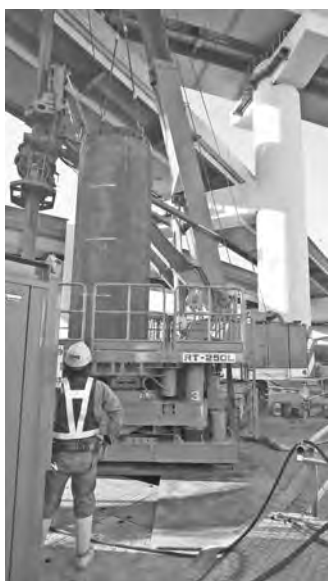
写真－3 都市高速道路直下の上空制限がある狭隘現場
