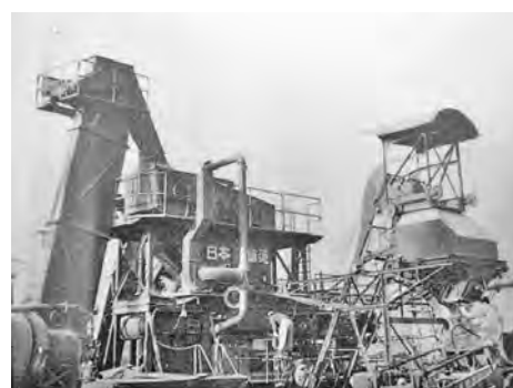
写真 3-28 ウイバウ社（西独）製 50 t/h WhUAPST-40 型 グースアスファルト舗装『日本舗道五十年史』
