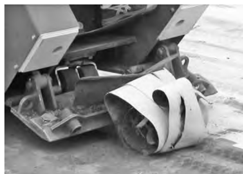
写真—2 新工法の施工現場② (剥離作業中)
