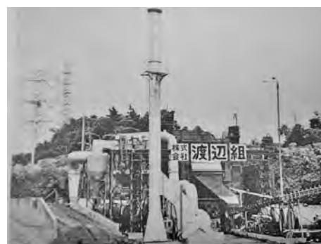
写真 3-30 浦賀重工業製 1 t/B 町田中央瀝青混合所 『株波辺組 五十年の歩み』
