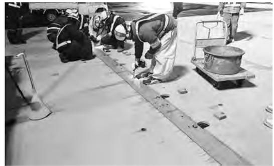
写真-16 段差解消摺付鉄板設置状況
