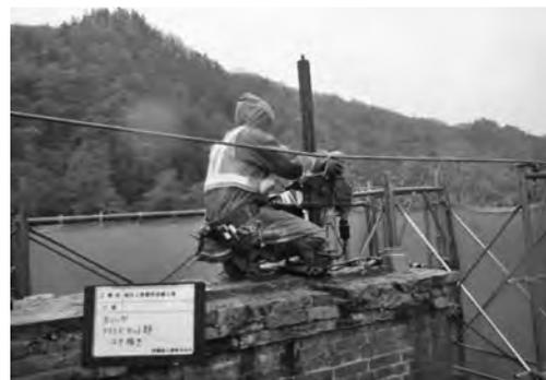
写真—2 アラミドロッド施工状況
