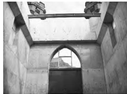
写真-3 レンガ建屋の内部 (補強後)
