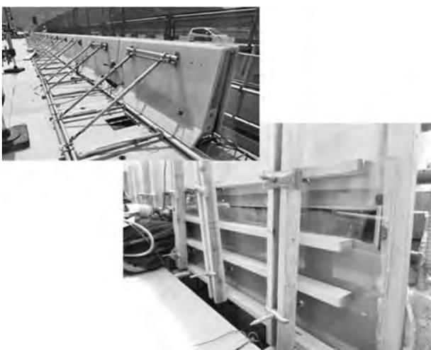
写真—7 PCa壁高欄施工状況
