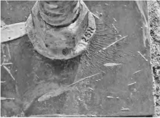
写真一五 変状状況 (プレートの歪み)
