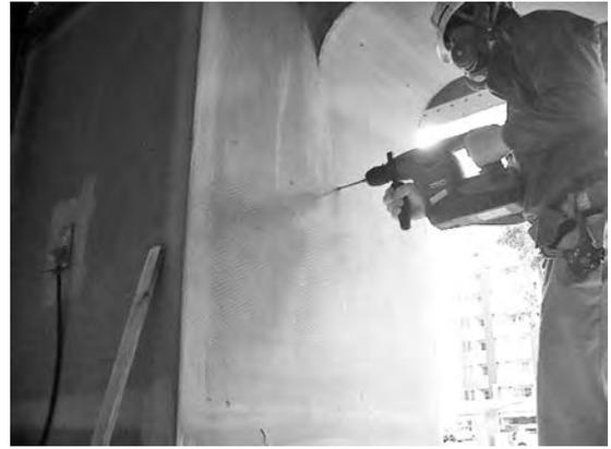
写真一七 アンカーピン用の穴の穿孔
