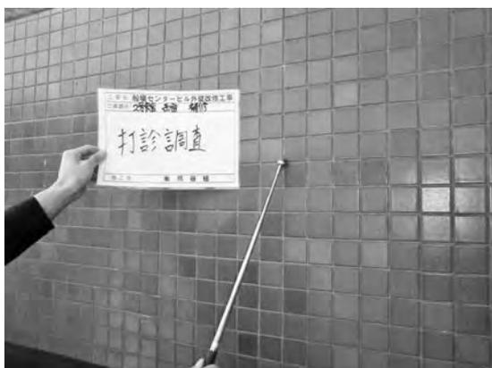
写真-3 タイル打診検査
