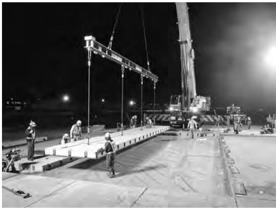
写真-14 高強度 PRC 版設置状況
