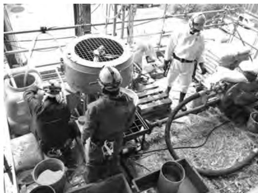
写真一6 吹付けシステムの設置状況
