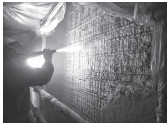
写真—8 吹付けの状況 (壁面)
