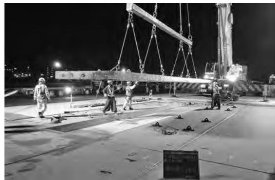
写真-13 既設 PPC 版撤去状況
