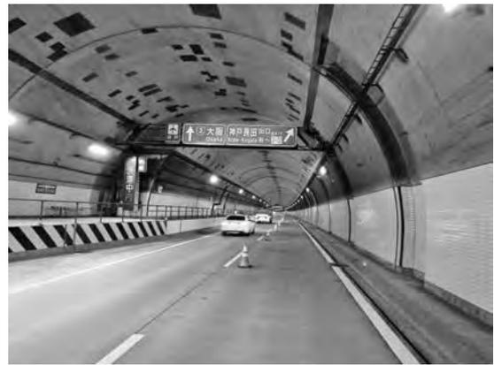
写真一8 天井板撤去完了
