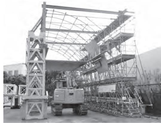
写真-3 天井板撤去実証実験設備
