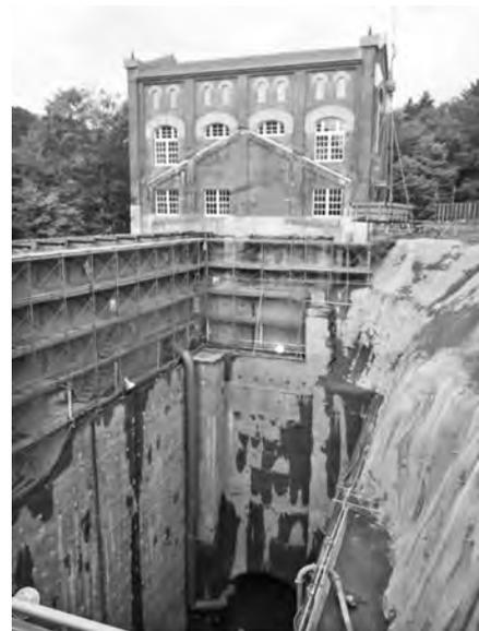
写真一4 立坑掘削状況
