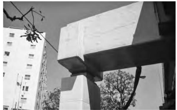
写真-3 支承取替後（剥落防止対策工前）
