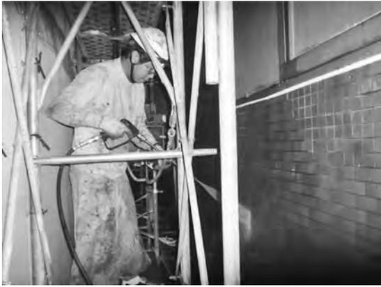
写真一五 外壁高圧洗浄
