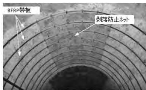
BFRP帯板接着による内面補強
