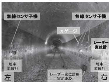
図-7 トンネルの監視システムの設置例<sup>9)</sup>
