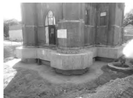
写真-6 基礎コンクリート築造 (2次施工部)
