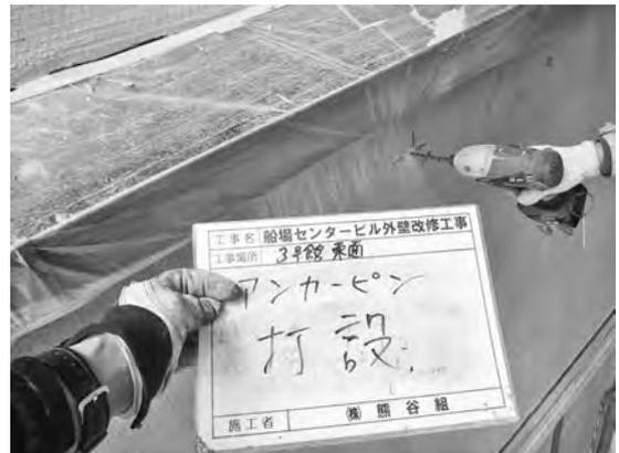
写真一八 アンカーピン打設
