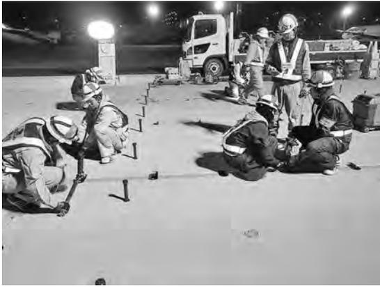
写真—18 コッター式継手本締付け状況
