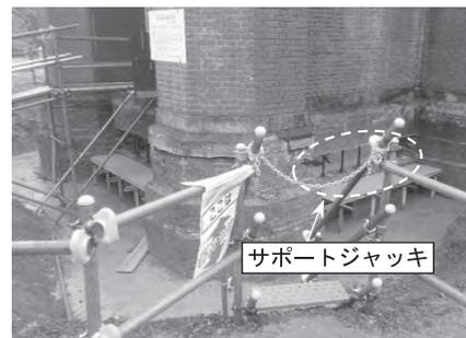
写真-4 レンガ壁撤去 (1次施工部)
