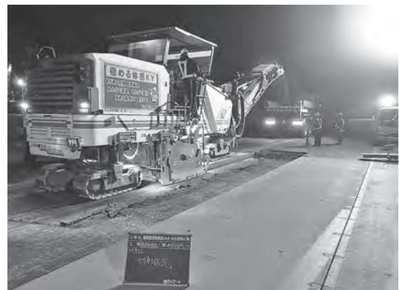
写真-11 路面切削状況
