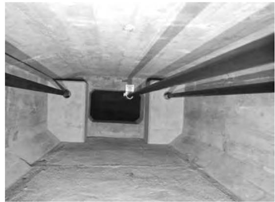
写真-4 桁内外ケーブル配置
