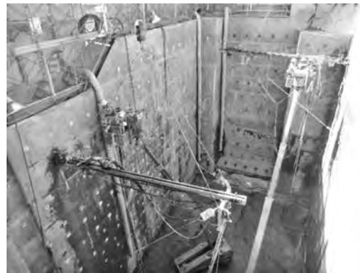
写真一七 増しロックボルト施工状況 (立坑)
