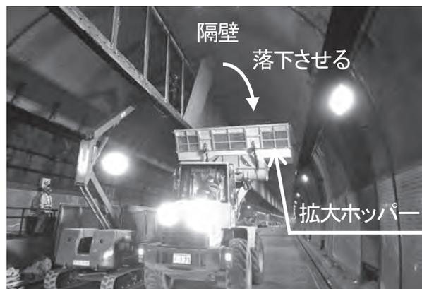
写真—6 隔壁撤去状況
