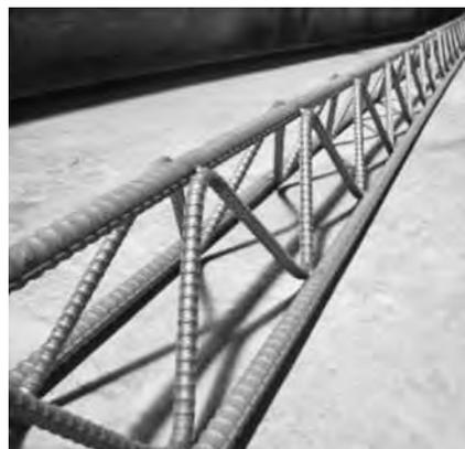
写真—2 ラチストラス鉄筋
