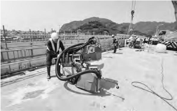
写真—4 乾式カッター切断状況
