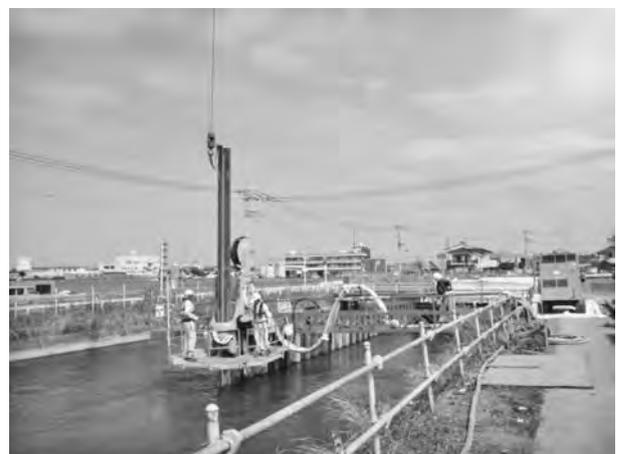
写真一2 半川締切鋼矢板圧入状況
