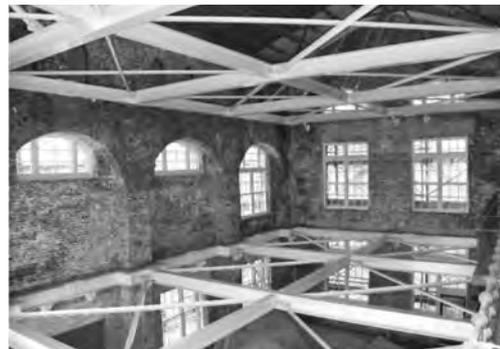
写真—1 耐震補強完了全景（内側）
