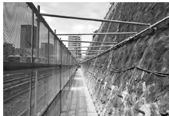
写真—2 線路防護網現況写真
