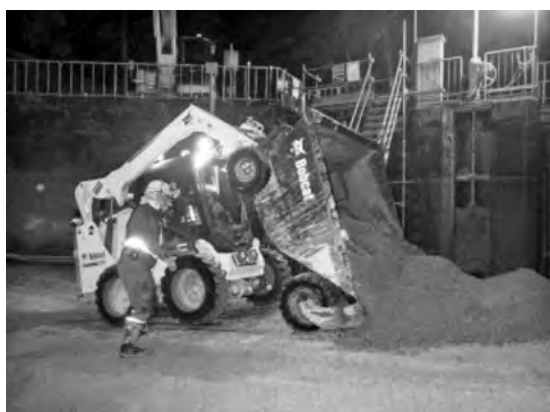
写真一3 コンクリートはつりガラ搬出状況
