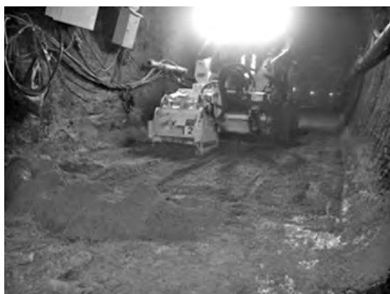
写真一2 切削状況
