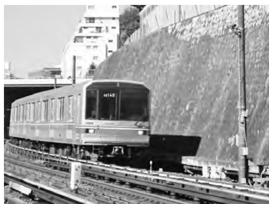
写真-1 現場現況
