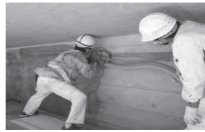
橋梁剥落対策工事
