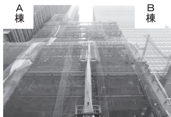
写真—1 A 棟（左）と B 棟（右）とのビル接続部
