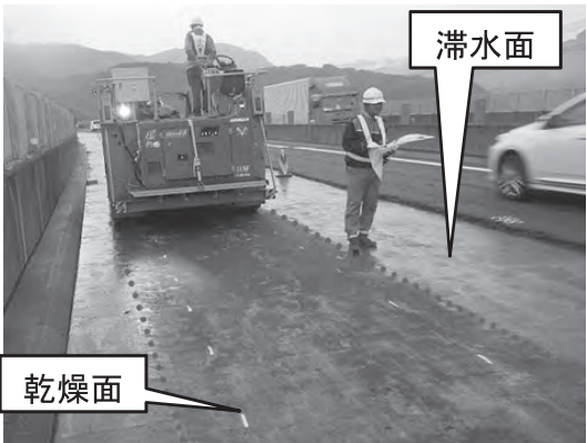
写真一 現場施工後状況
