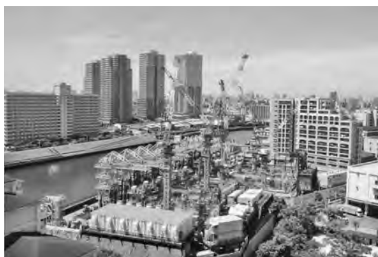
写真—1 現場全景写真
