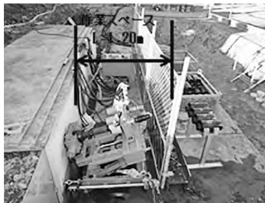
写真—7 試験施工時 状況写真
