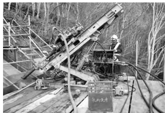
写真—3 ロータリーパーカッション削孔機
