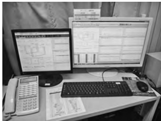
写真-7 情報化施工システム
