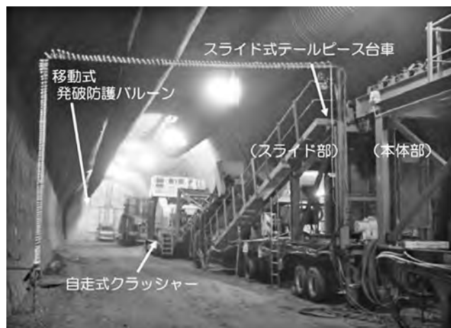
写真—1 高速ずり搬出システム
