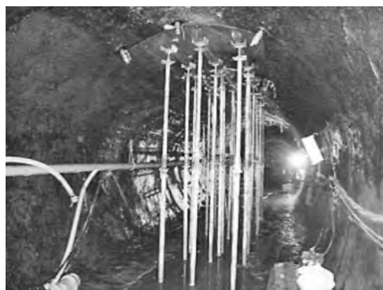
写真一4 覆工仮受け状況
