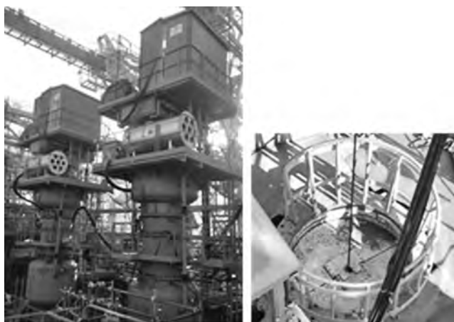
写真-6 騒音対策型マテリアルロック
