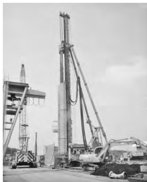
写真―2 柱列式施工機械
