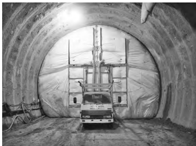
写真—2 移動式発破防護バルーン
