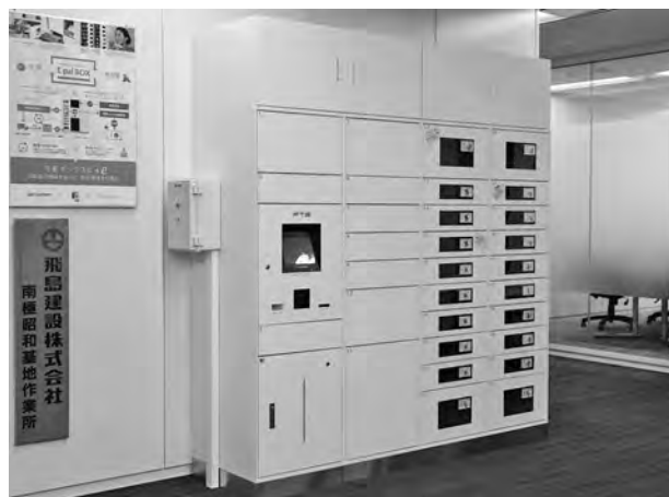
写真ー1 設置状況
