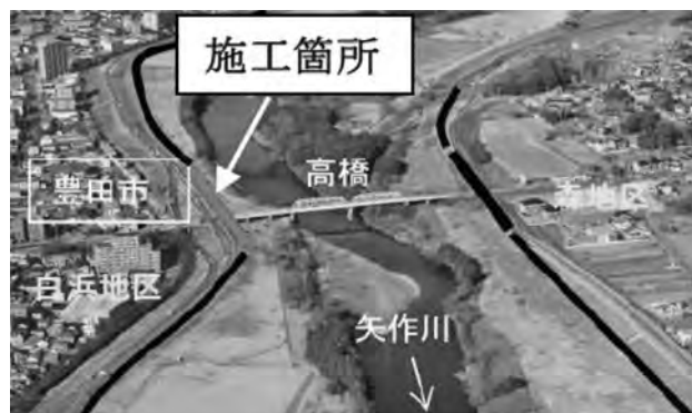
写真一5 施工位置 5)
