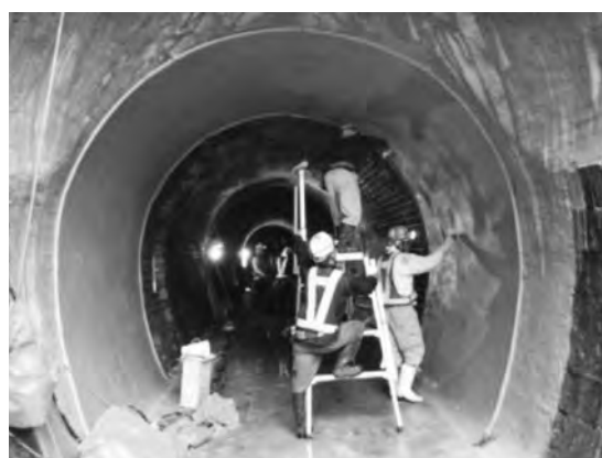
写真一5 全断面補修工 施工状況
