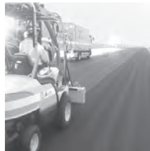
空港滑走路ゴム除去工事
