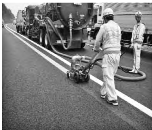
写真一 区画線消去工
