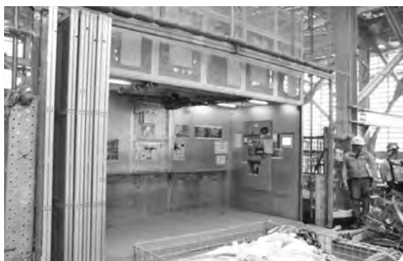
写真—2 工事用エレベータ（左=停止時, 右=動作時）
