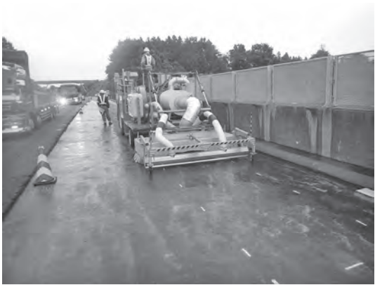
写真一 現場施工前状況
