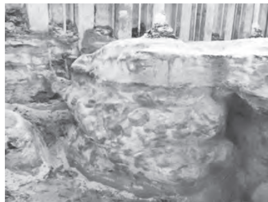
写真一 3 改良体（振動あり）
