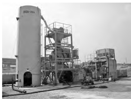
写真―3 材料供給機械
