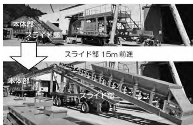
写真—3 スライド式テールピース台車のスライド状況
