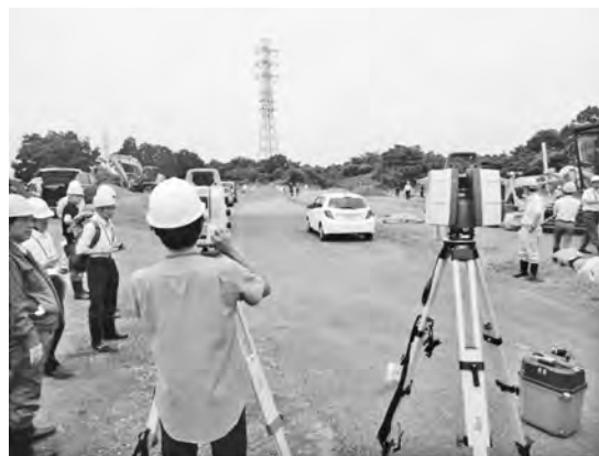
写真—1 TLS計測時(起工面)
