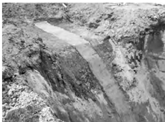
写真一4 等厚式の改良状況
