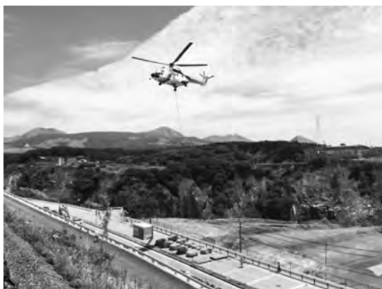
写真ー3 送り出し基地
