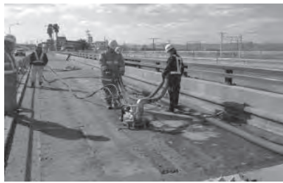
橋梁防水補修工事
