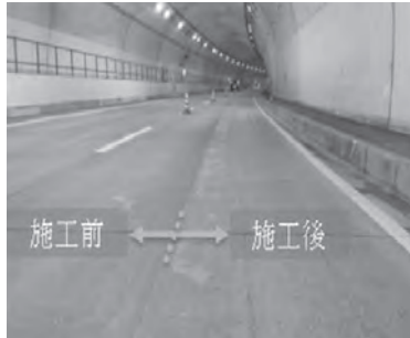
CO路面研掃工
