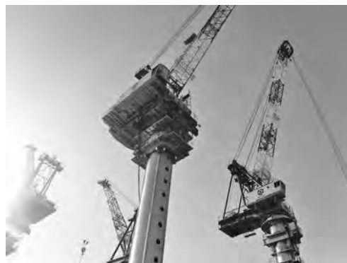
写真—3 最上階から見上げたタワークレーン
