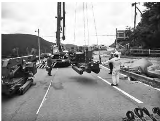
写真一8 カニクレーンの分解作業
