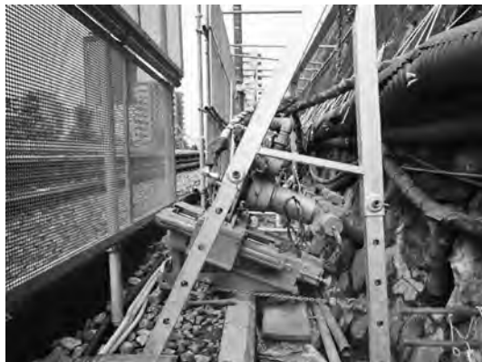
写真—8 施工状況
