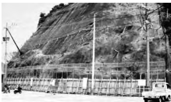
写真—1 吹付のり面における事例の現地状況
