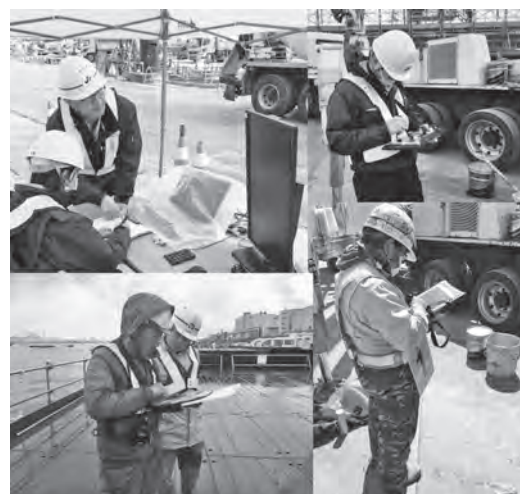
写真ー3 打設現場での運用状況 (受入れ登録, 打設情報確認)
