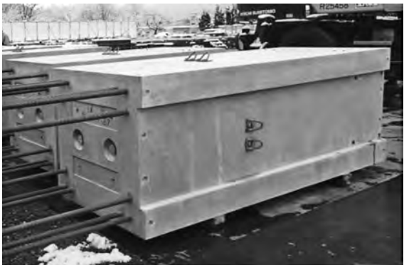
写真—4 柱部材の突起形状
