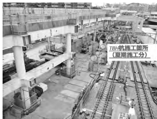
写真—5 TBH 杭施工箇所
