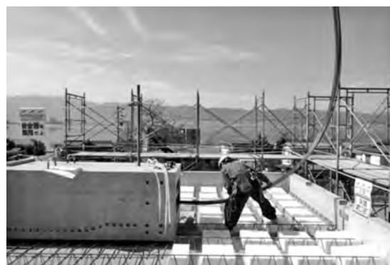
写真-9 PC 鋼線挿入状況
