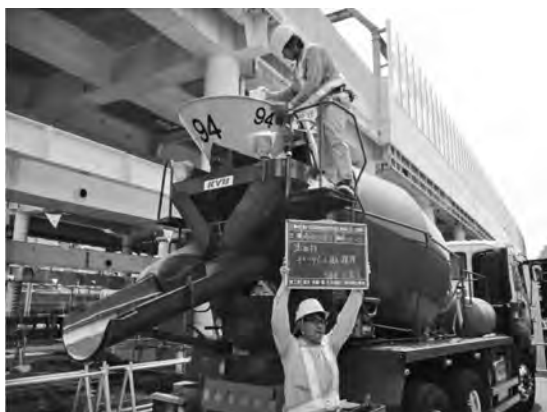
写真—7 本混和剤添加状況
