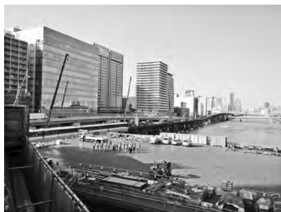
写真—5 大井 JCT 構台箇所見学
