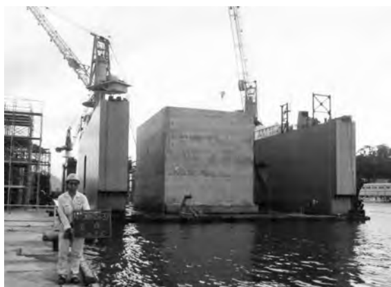
写真一3 フローティングドックと完成したケーソン
