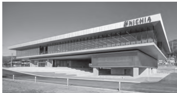
写真—1 建物全景
