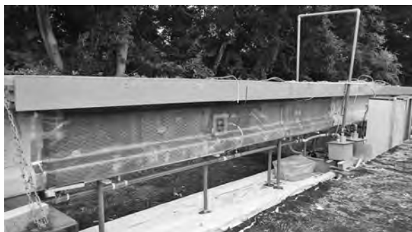
写真—1 I型PC桁に対する施工実験状況
