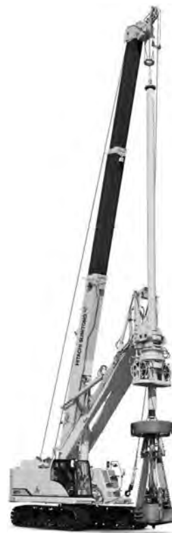
写真—5 日立住友重機械建機クレーン SDX407-2 アースドリル
