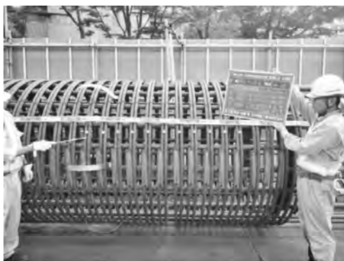
写真—6 杭頭部高密度配筋部
