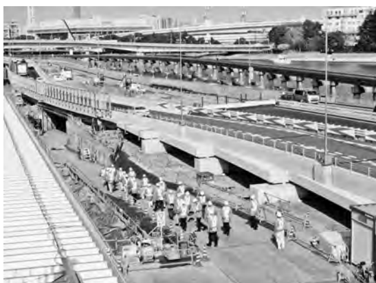
写真ー1 鮫洲埋立部の全景（迂回路）
