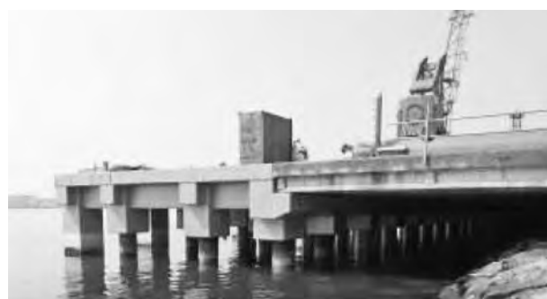
写真—4 現場B（栈橋）
