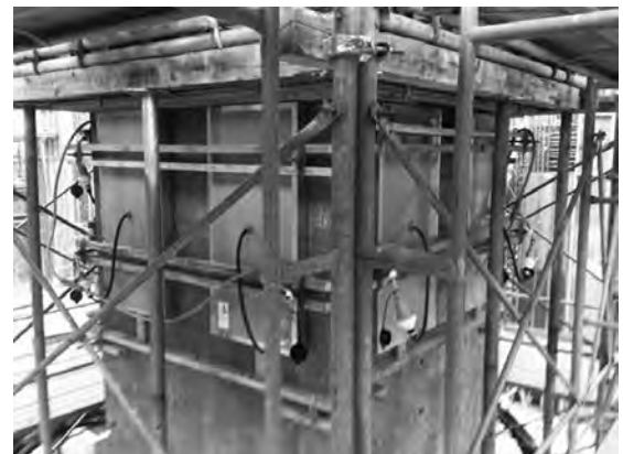
写真一 6 柱梁接合部のパネルヒータ設置状況
