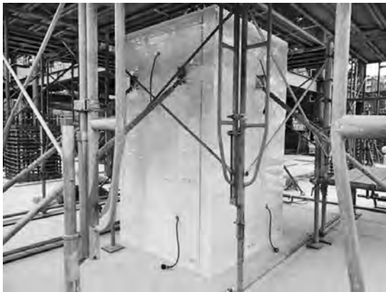
写真一 3 1階柱外観
