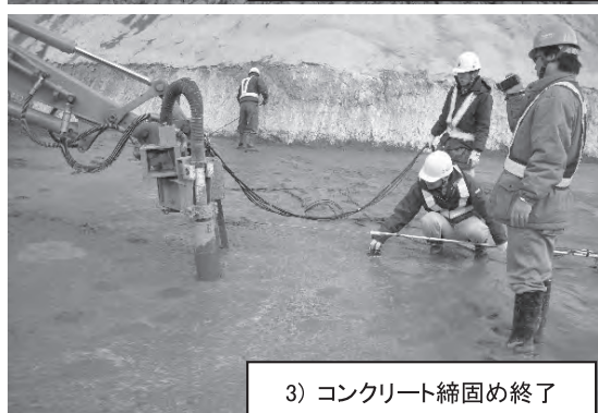
図—1 ダムコンクリートの締固め状況変化
