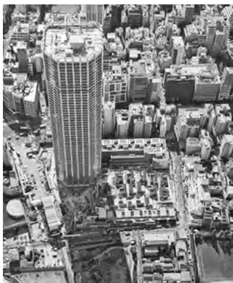
写真—1 建物全景
