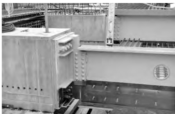
写真-7 PCaPC 梁と鉄骨部材の取合い
