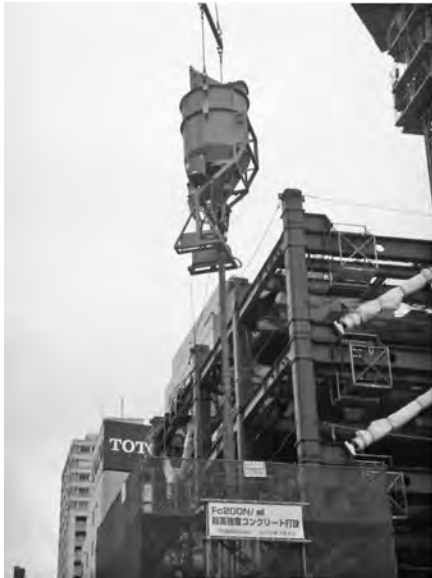
写真一 2 1階柱施工状況
