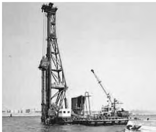
写真一4 杭打船
