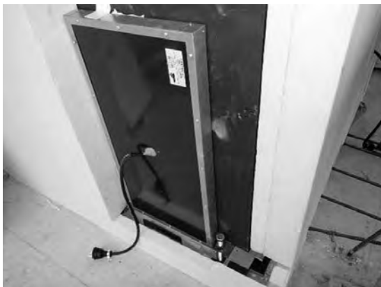
写真一 4 1階柱のパネルヒータ設置状況
