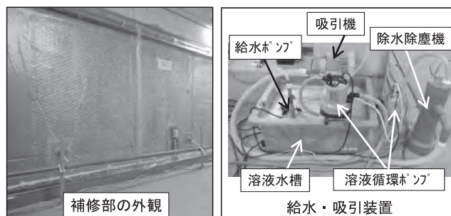
写真—4 建築物の屋内壁面に対する施工状況
