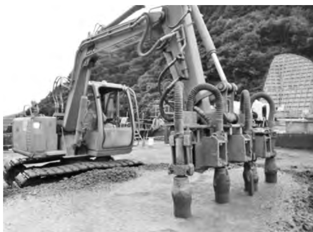
写真—1 ダムコンクリート締固め状況
