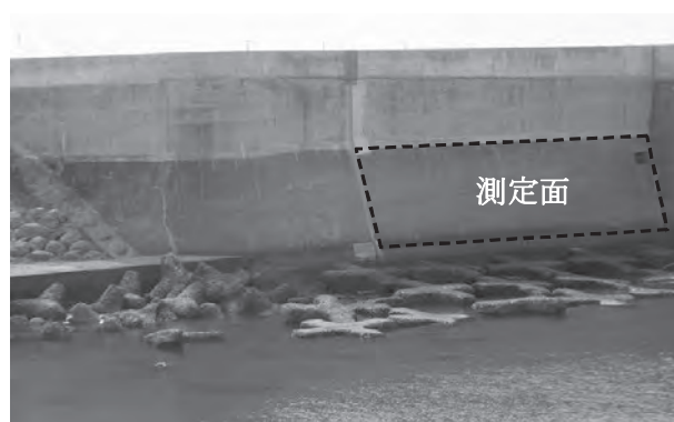
写真—3 現場A（河川護岸構造物）
