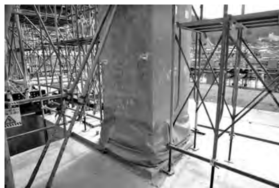
写真—6 PCa柱脚部採暖養生
