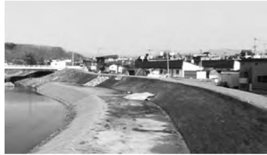
写真一六 堤防の整備事例 (雨煙別川)
