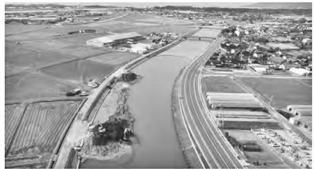
写真—11 新内藤川の河道掘削工事の状況
