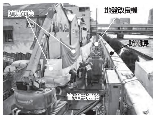
写真—2 地盤改良施工状況
