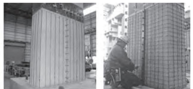
(a) 軸方向鉄筋の設置
