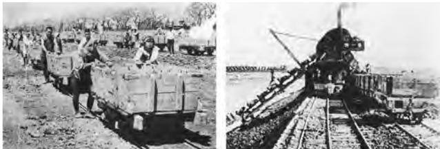
写真一 九 人力掘削と機械掘削
