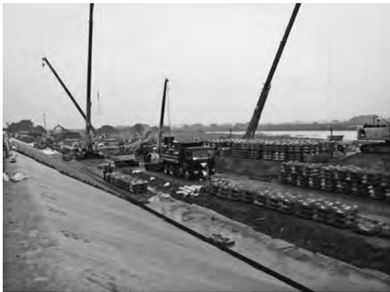
写真一2 資材の仮置き状況 (連節ブロック)
