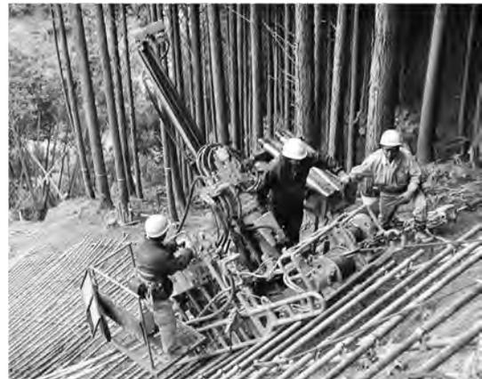
写真一 法面補強での削孔と補強のためのロックボルト打ち込み
