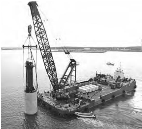
写真—4 FC船による吊り曳航
