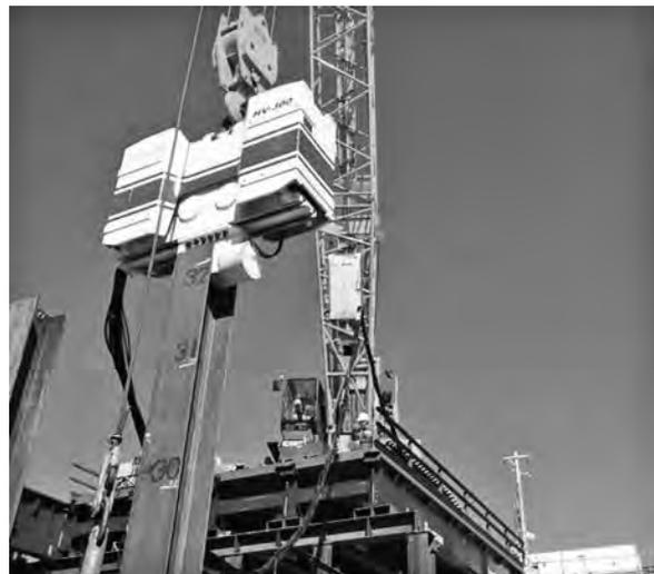
写真-3 調和工業 HV-300 バイブロハンマ (シングルチャック)
