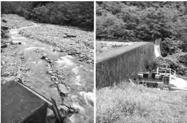
写真—1 取水口（左）・取水槽（右中央）
