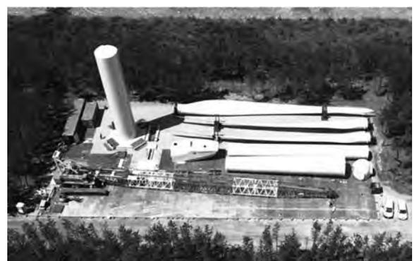
写真-2 風車部材仮置状況
