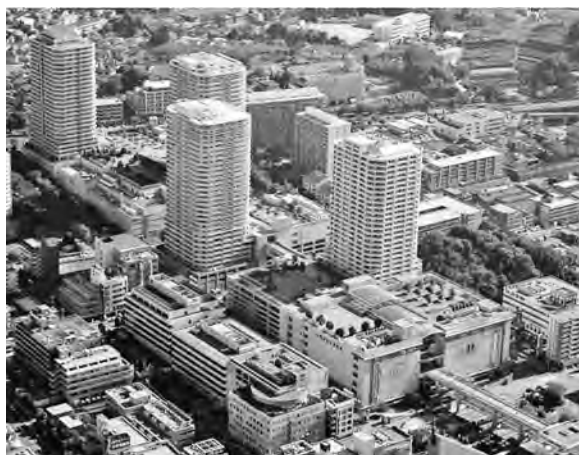
写真—1 東戸塚駅東口開発完成鳥瞰写真
