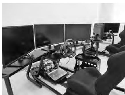
(b) 管制・遠隔操縦設備
