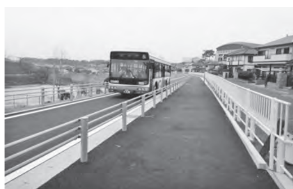
写真—1 BRT専用道
