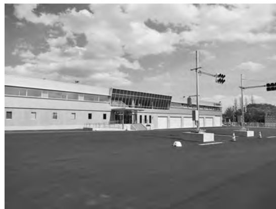
写真—6 次世代モビリティ社会実装研究センターの外見と試験路
