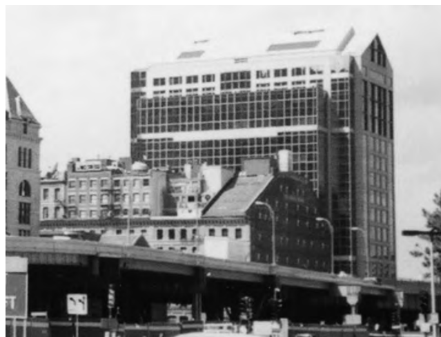
写真—2 2000年8月 高架道路を供用しつつ、地下トンネル工事が進められた。（著者撮影）
