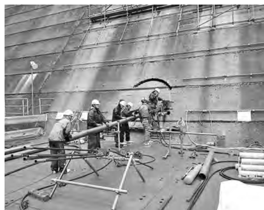
写真ー1 コアボーリング施工状況
