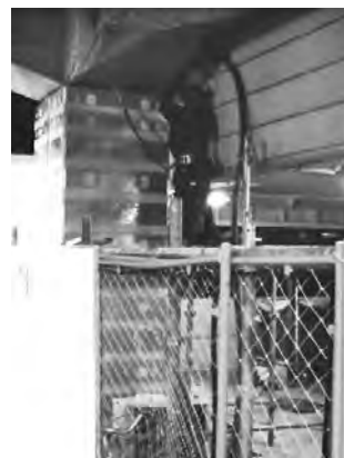
写真—5 モルタル充填状況
