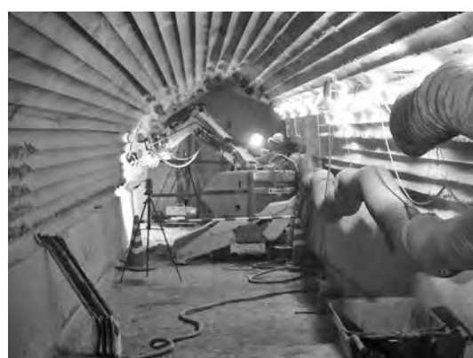
写真一 13 側壁切削状況
