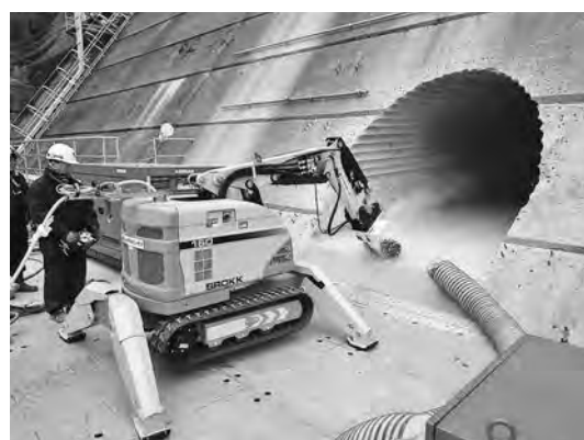
写真一 11 底盤切削状況
