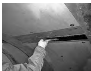
②接合パネル設置
