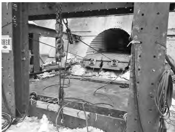
写真-4 コンクリートブロック引出状況（下半部）
