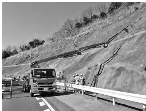
写真—6 法面への適用状況
