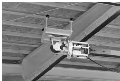
写真一2 アタッチメント取付け状況
