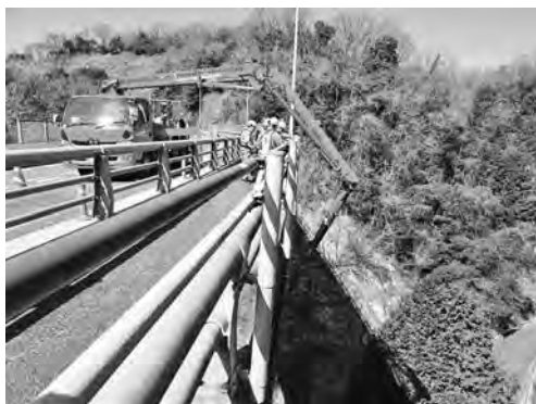
写真—3 ブームの操作状況（橋梁上部）
