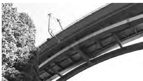
写真—4 ブーム先端の取り回し状況
