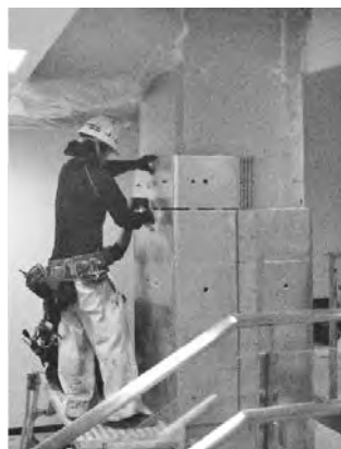
写真—4 鋼板組立状況
