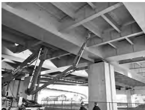
写真—5 ブームの操作状況（橋梁下）
