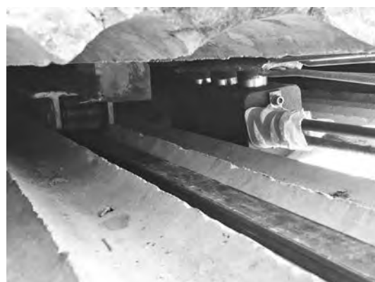
写真ー2 割裂状況 (バスター工法)
