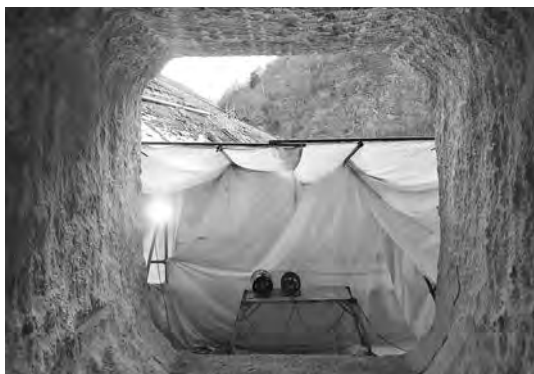
写真—14 切削完了（呑口部）
