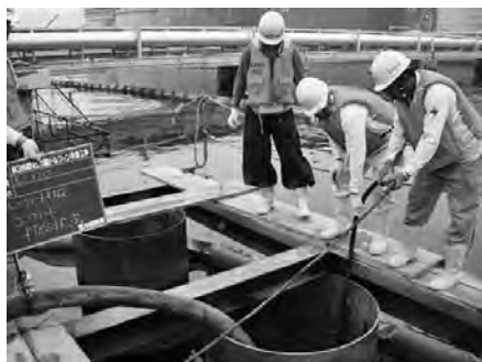
写真一 4 中詰コンクリート打設
