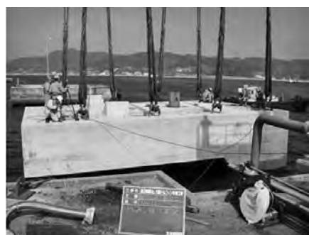
写真一 5 PCa 上部工架設
