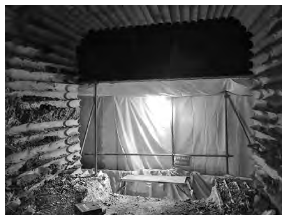
写真-8 貫通部（呑口部）
