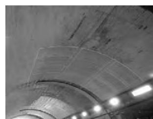
④施工完了
