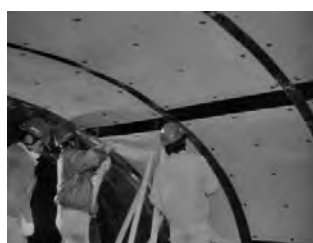
①本体パネル設置
