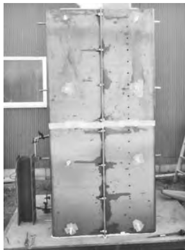
写真—1 モックアップ試験体
