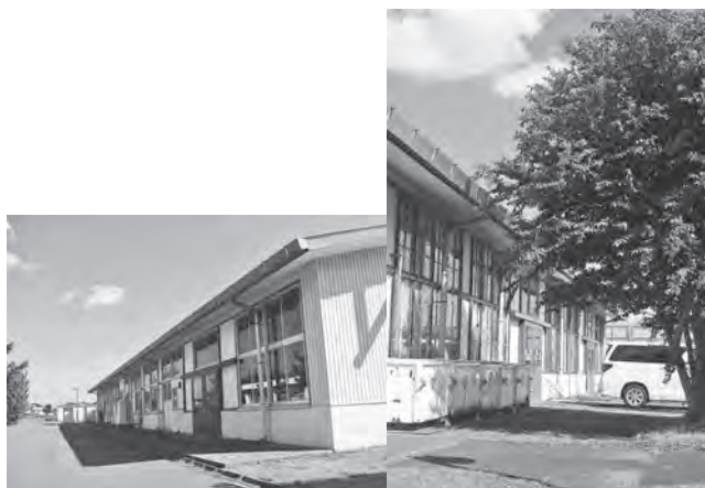
軒の状況 (北側)
