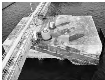
写真一 9 着工前
