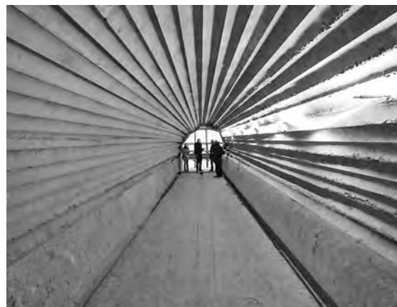
写真-7 貫通後（坑内）
