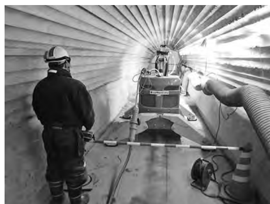
写真一 12 坑内配置状況
