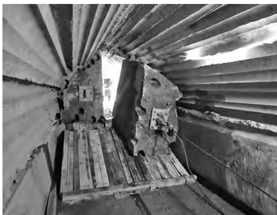
写真-5 貫通部引出状況
