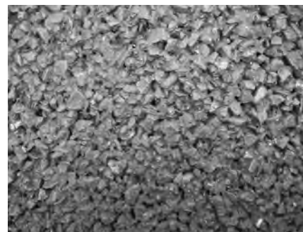
写真—9 路面状況
