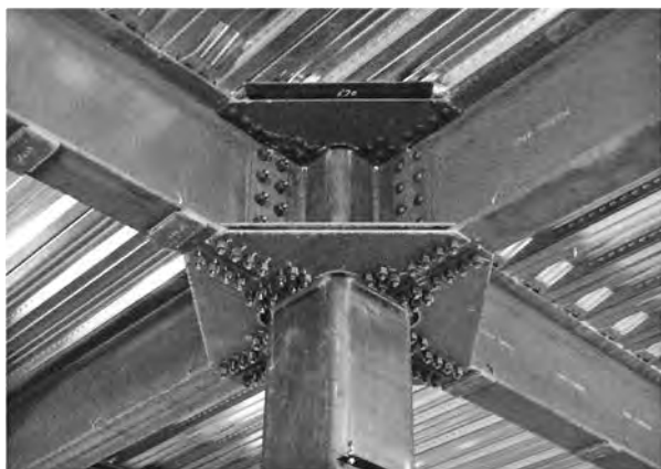
写真—1 本工法を用いた柱梁接合部
