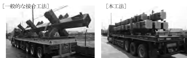
写真—2 一般的な接合法と本工法による接合部の運搬例
