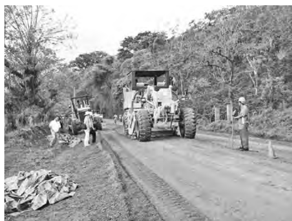
写真-9 セメントによる処理
