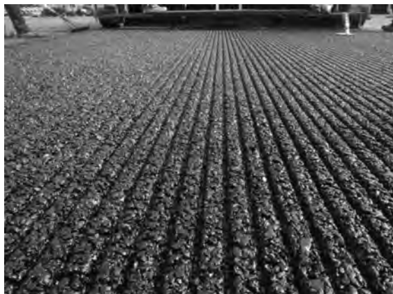
写真-1 縦溝粗面仕上げの例
