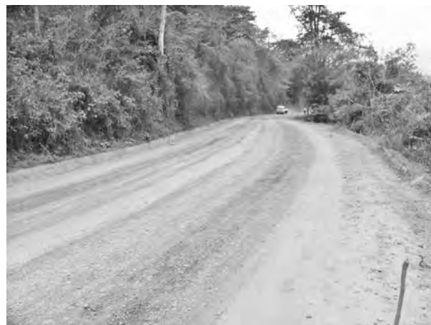
写真-8 施工前 (砂利道)
