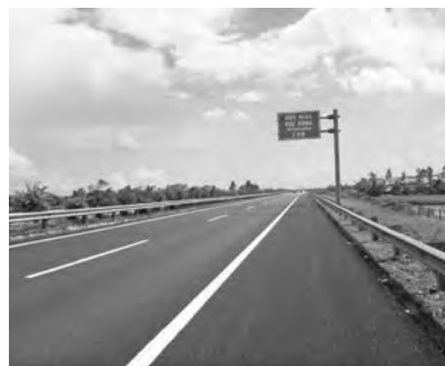
写真—5 完成後の路面
