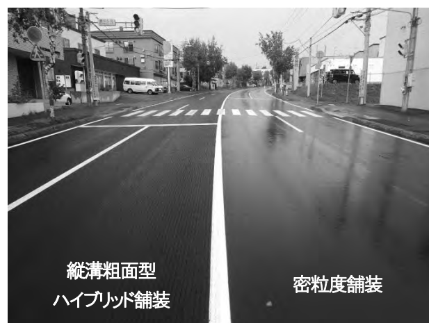
写真—8 施工直後浮き水抑制状況
