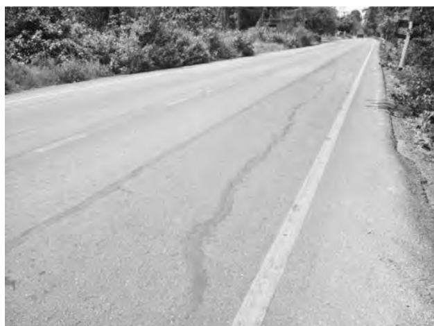
写真—11 タイの地方道における縦断方向のひび割れ施工後2年・クラックシール済
