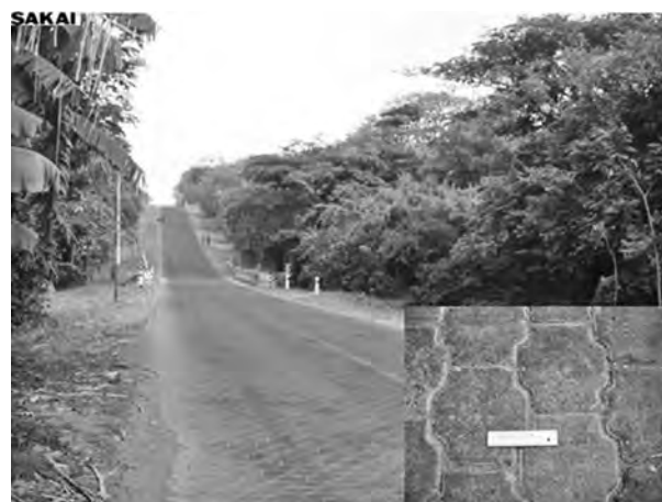
写真-10 完成したインターロッキングブロック舗装
