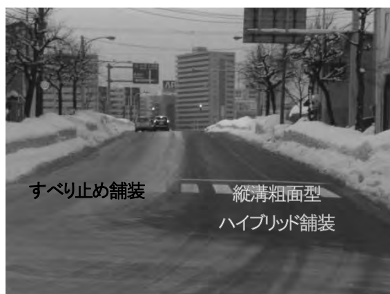
写真—5 施工直後路面露出状況
