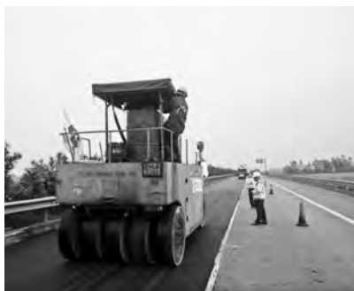
写真—4 二次転圧
