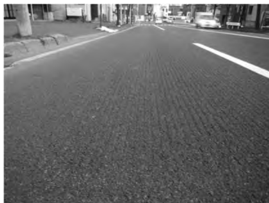
写真-3 施工2年後のFFP路面（札幌市内）
