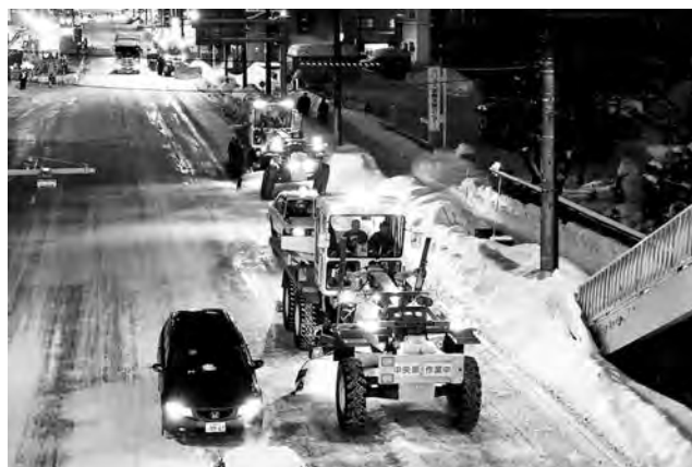
写真—2 路面整正作業
