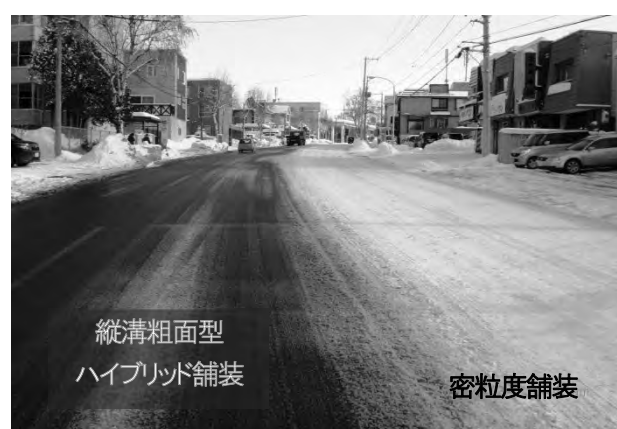
写真—9 施工直後路面露出状況
