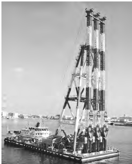
写真—6 不動テトラ サンドコンパクション船 ばいおにあ第30 フドウ丸
