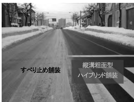
写真—6 施工直後路面露出状況
