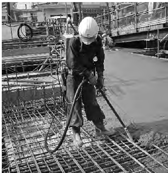
写真—4 本開発機の試適用状況
