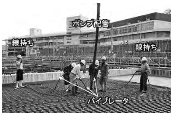
写真—1 従来の一般的な締固め作業
