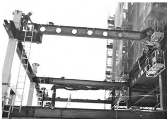
写真一3 建方状況 (左：在来ブラケット工法, 右：本工法)
