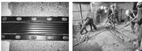
写真—1 後打ちコンクリートと取替え工事
