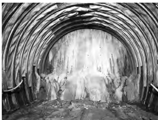
写真—4 トンネル切羽状況 (支保パターンIN)
