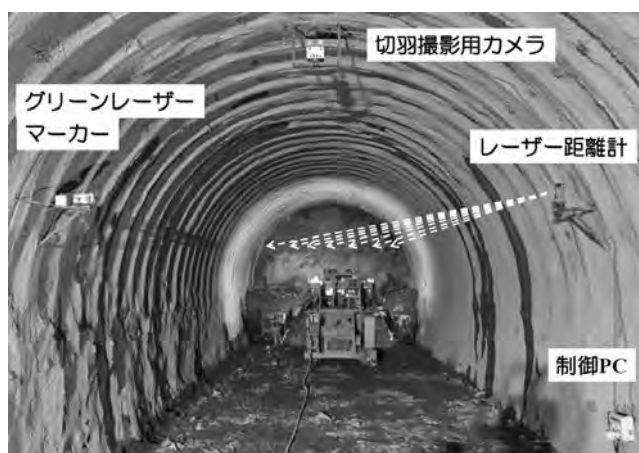
写真－1 現場適用時の機器配置状況 3)
