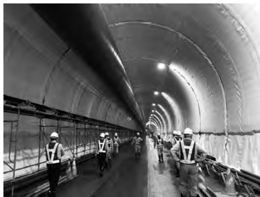
写真—9 防水工区間
