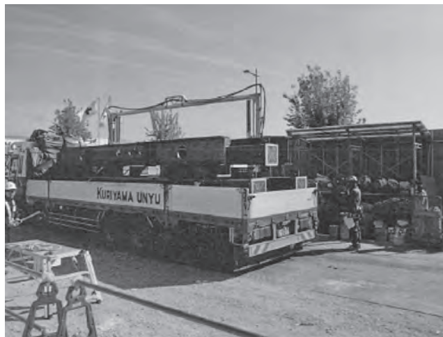
写真—2 本工法 柱部材の積載状況
