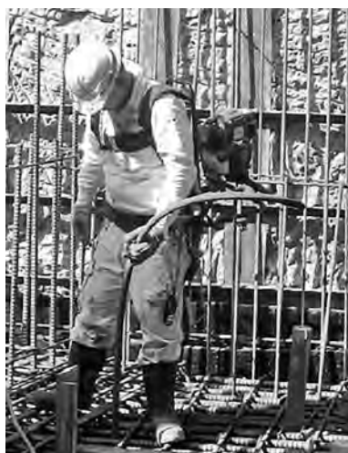
写真—2 海外製エンジン式バイブレータ
