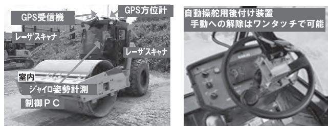
図—2 振動ローラの自動化システム
