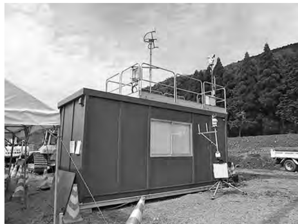
写真—1 高機能遠隔操作室
