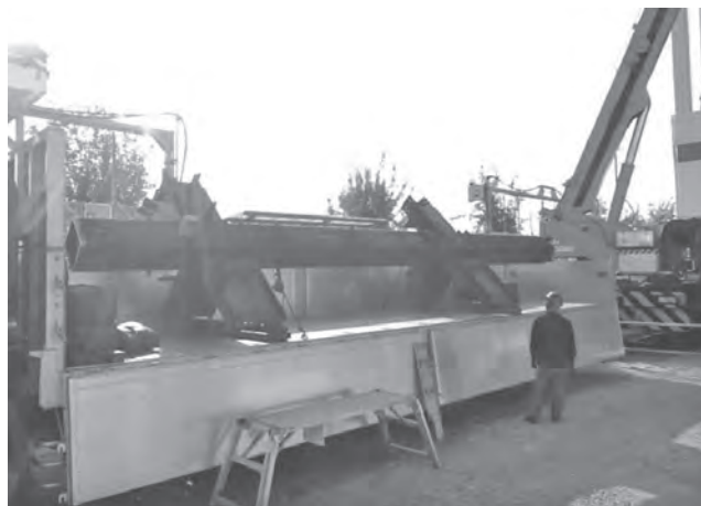
写真—1 在来ブラケット工法 柱部材の積載状況
