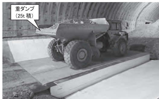
写真二 キュアロードによる養生状況
