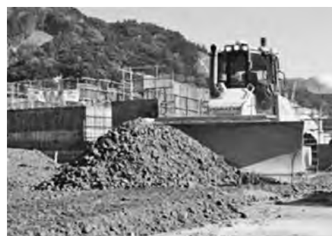
写真三 五ヶ山ダム適用状況
