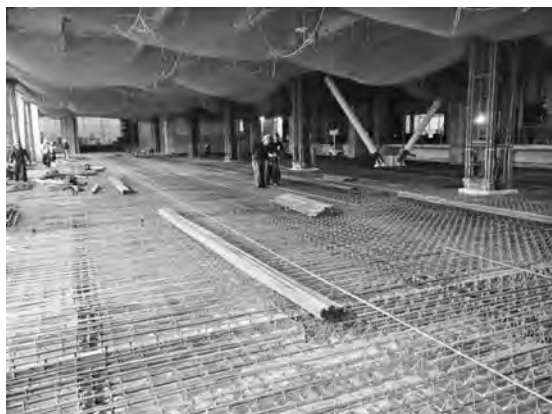
写真一 1 スラブ鉄筋 現場状況
