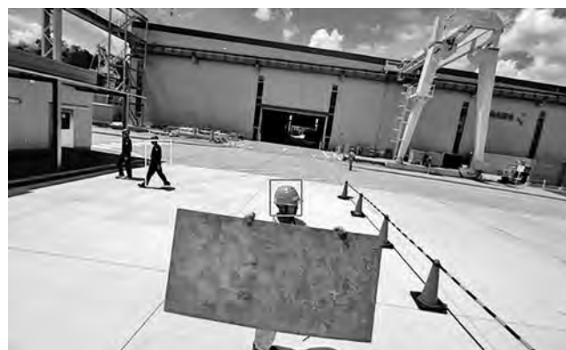
図-4 合板を運搬中の作業員の検出
