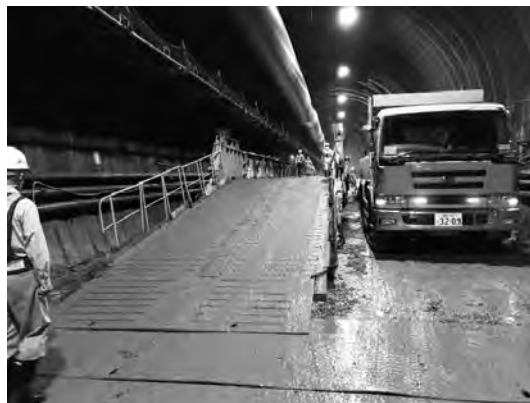
写真—8 インバート栈橋設置状況
