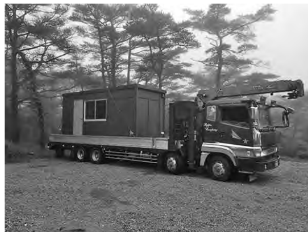
写真一7 拡張型高機能遠隔操作室搬入状況
