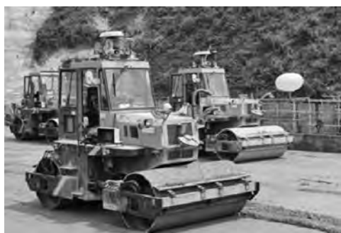
写真一 五ヶ山ダム適用状況
