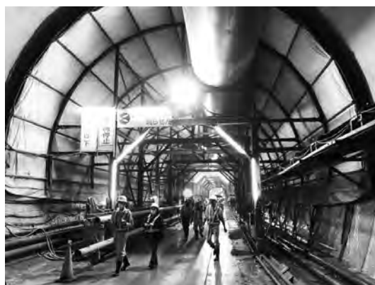
写真—10 覆工コンクリート養生部
