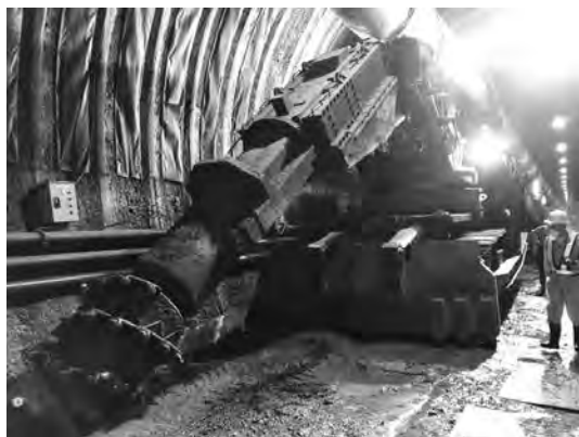
写真—5 ブームヘッダ (カヤバシステムマシナリー(株) RH-250MB-SL)
