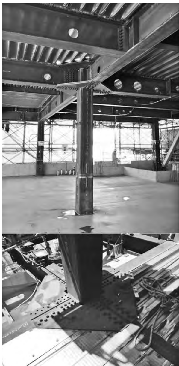
写真一4 本工法設置状況 (上：見上げ, 下：見下げ)
