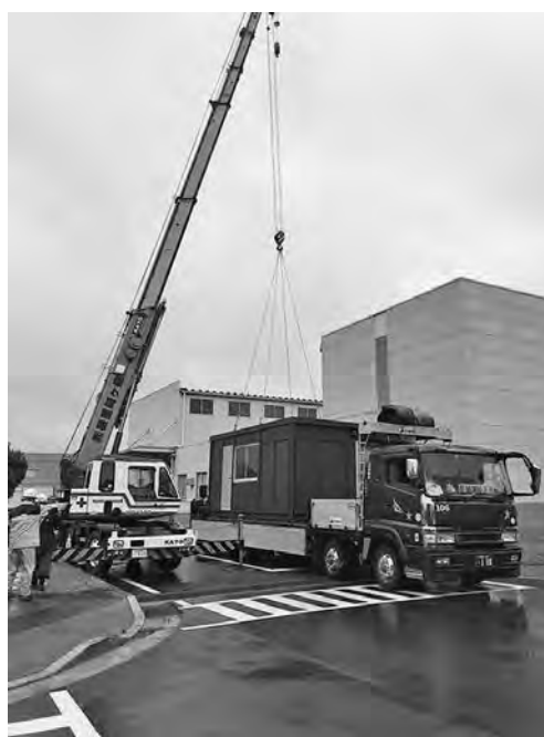
写真一8 拡張型高機能遠隔操作室荷卸状況
