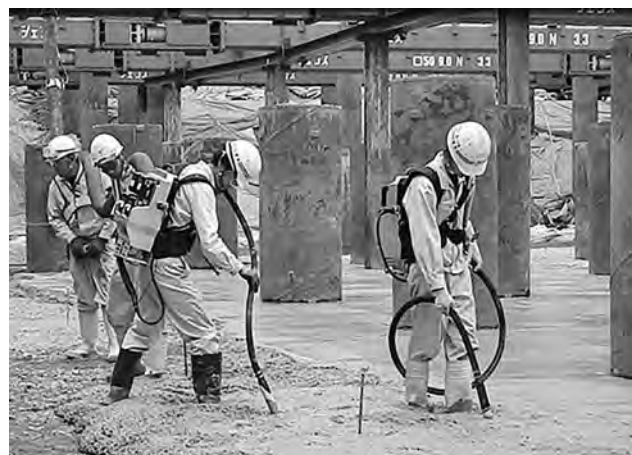
写真—6 改良機の試適用状況
