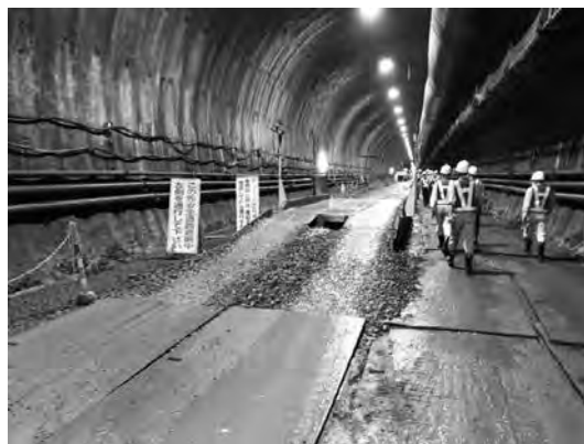
写真—7 ターンテーブル設置状況
