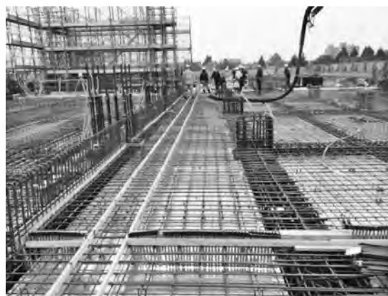
写真-4 実証実験 建築現場
