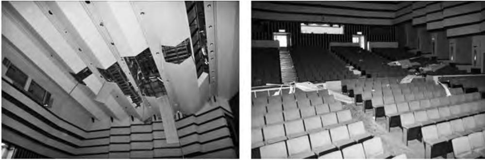
写真—1 天井の被害
