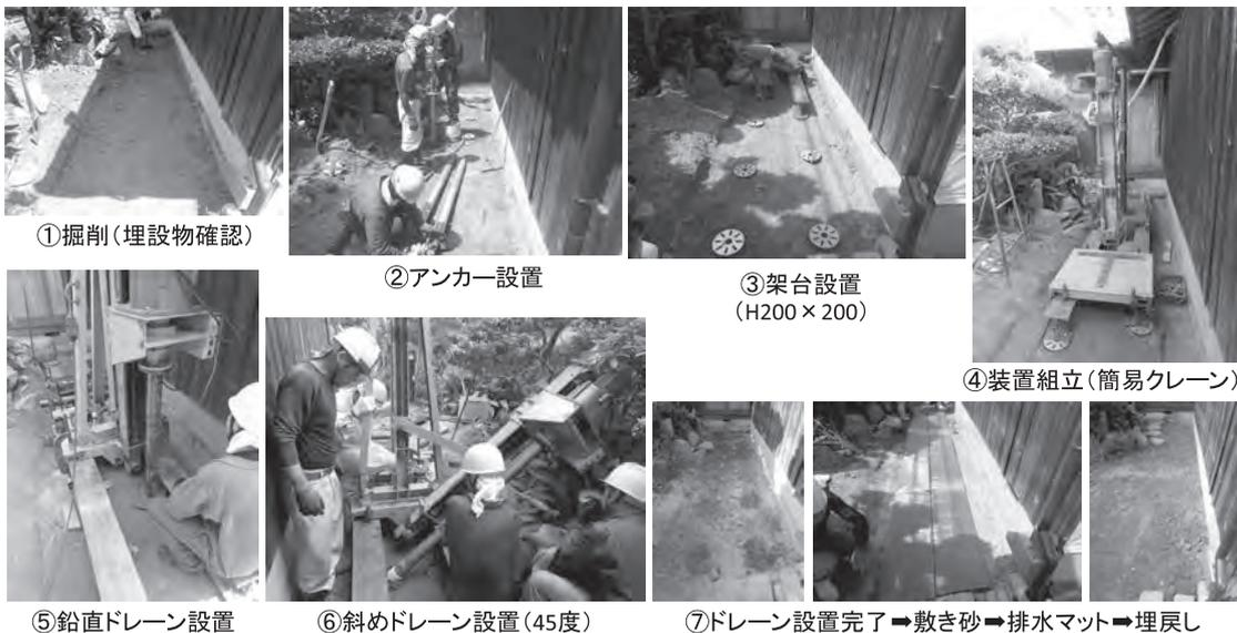
写真一四 作業手順と施工状況
