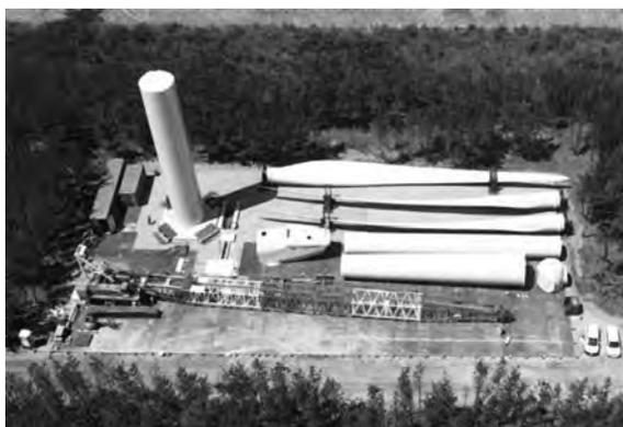
写真一 風車部材仮置状況
