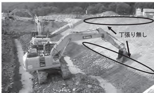
写真一3 ICT建機による掘削
