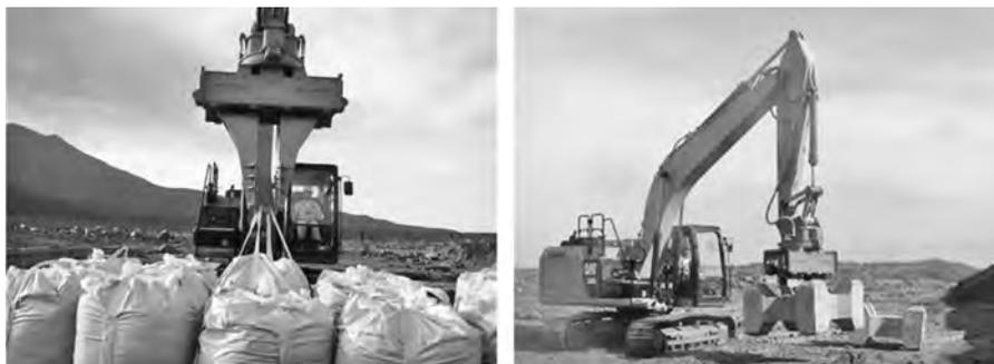
写真一1 新型把持装置による大型土のう設置（左）と根固めブロック設置（右）
