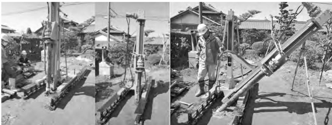
写真—5 低振動低騒音小型回転圧入装置（左：検証実験状況，中央：首振り鉛直施工，右：斜め施工）
