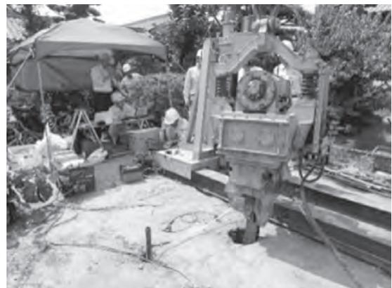
写真一 3 バイブロによる起振状況
