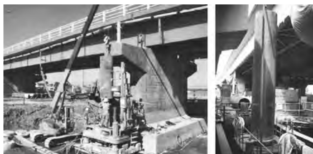
写真一4 鋼管杭増杭基礎の桁下施工例 11)
