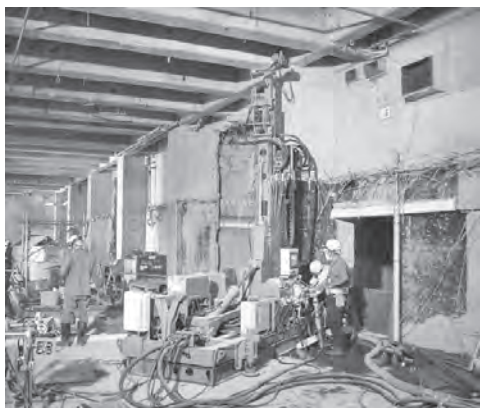
写真-2 建物内での施工状況
