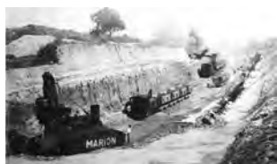
写真-9 烏山頭排水開渠掘削
