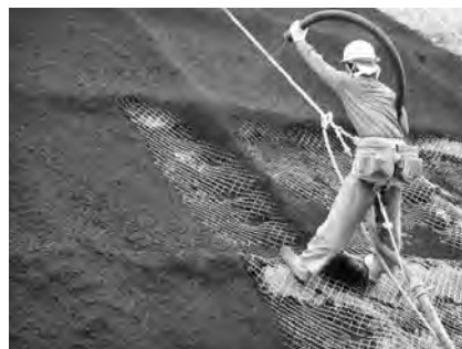
⑥植生基材吹付工
