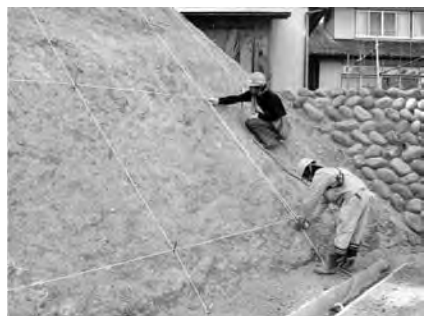
①芯出し工
