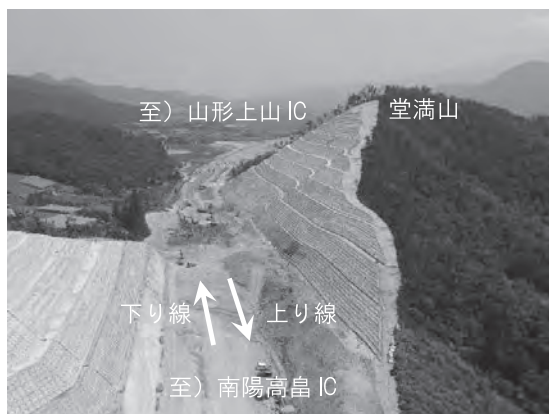
写真一 12段長大切土2段目掘削状況 (平成29年7月撮影)
