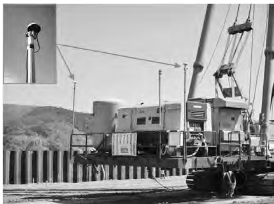
写真一 3 GNSS 受信機設置状況
