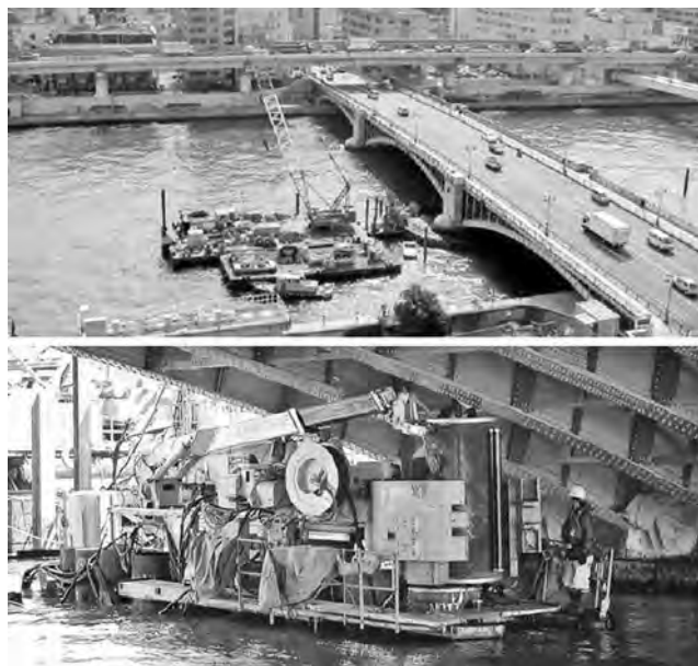
写真一3 圧入工法による桁下施工例 10)
