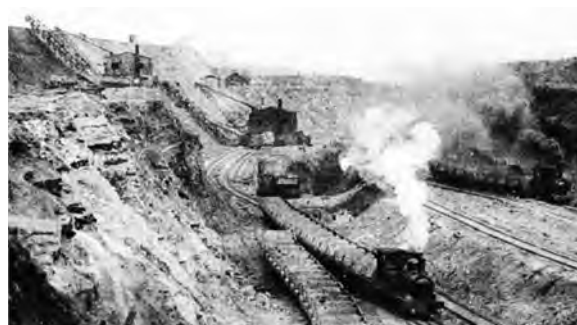
写真－3 高地部掘削のLMG製エキスカと土工機関車
