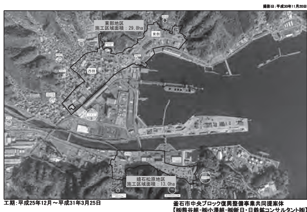
写真—1 中央ブロック全景
