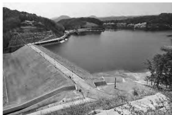
写真—2 藤沼ダム試験湛水状況 (2017年4月)
