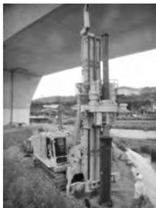
写真一2 空頭制限下での回転杭工法施工例 9)
