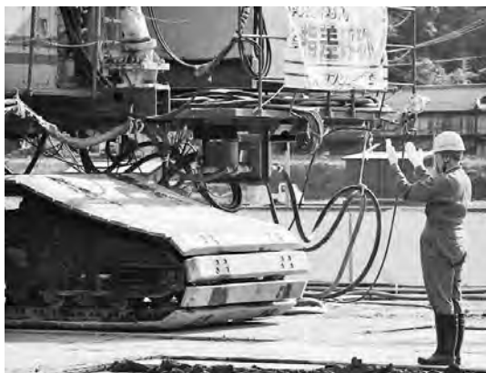
写真一 2 施工機の誘導状況
