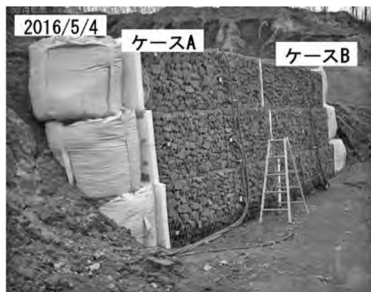
図—12 ギャビオン補強土壁の試験施工例
