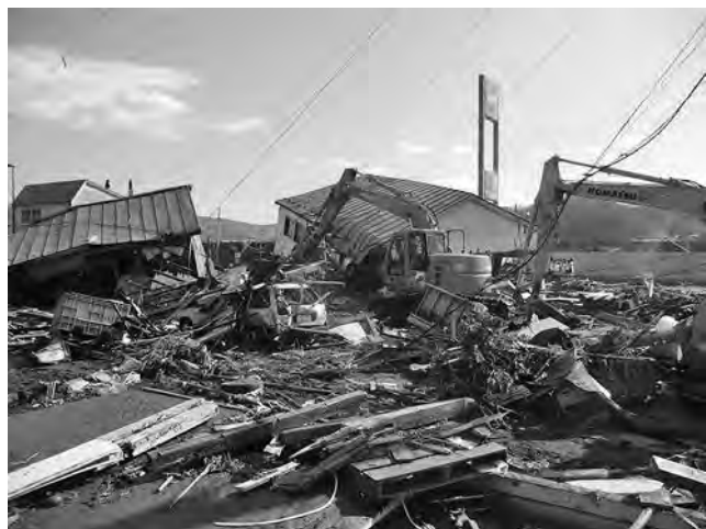
写真—1 東日本大震災での啓開作業
