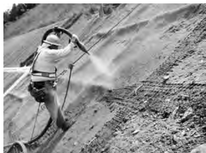
④改良土吹付工
