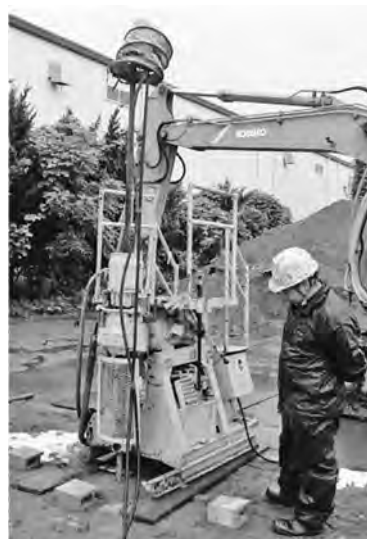
写真—1 注入試験の状況
