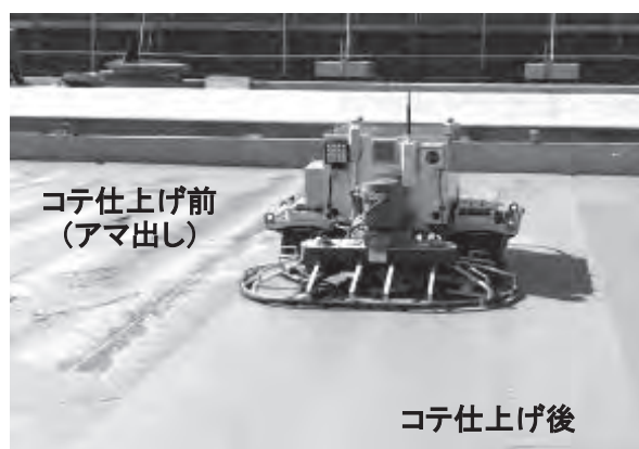
写真二 アマ出し後の金ゴテ作業状況
