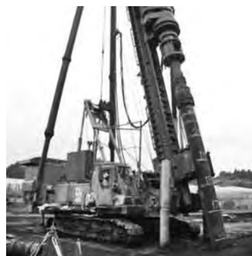
写真—1 斜杭の施工例 6)
