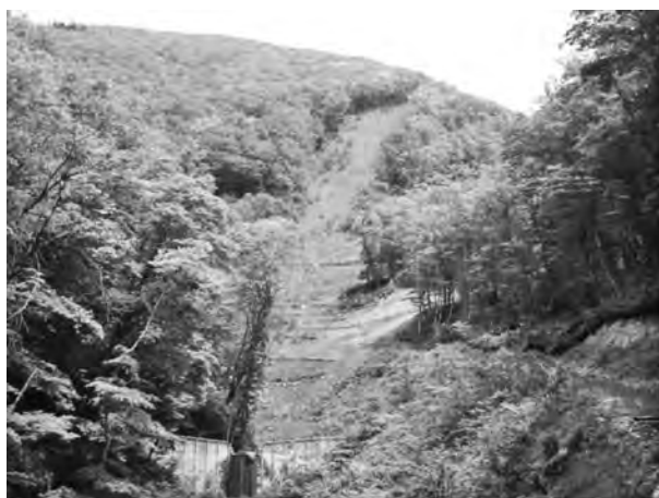
写真—5 高所位置の山腹斜面での施工事例
