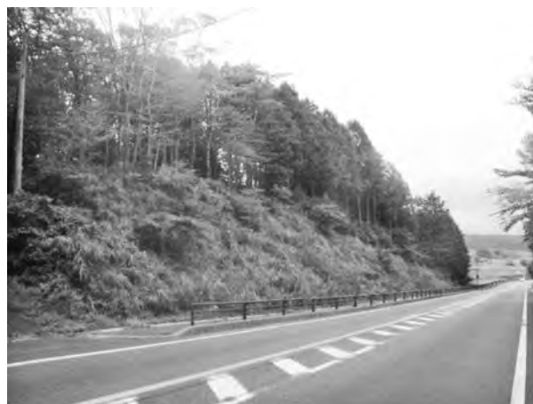
写真-4 周辺環境に配慮した施工事例
