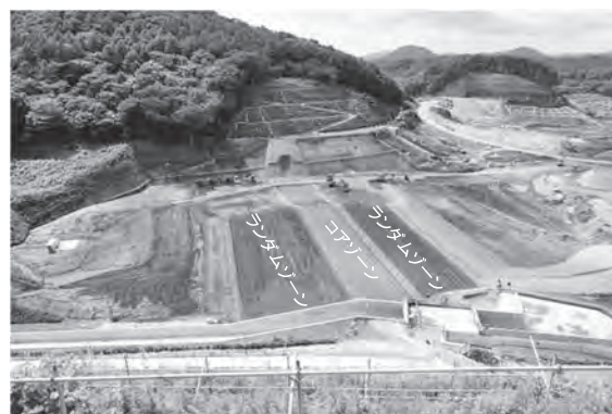
写真—1 本堤の施工状況 (2016年7月)
