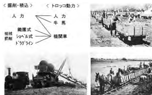
図一7 軌条工法の組合せ
