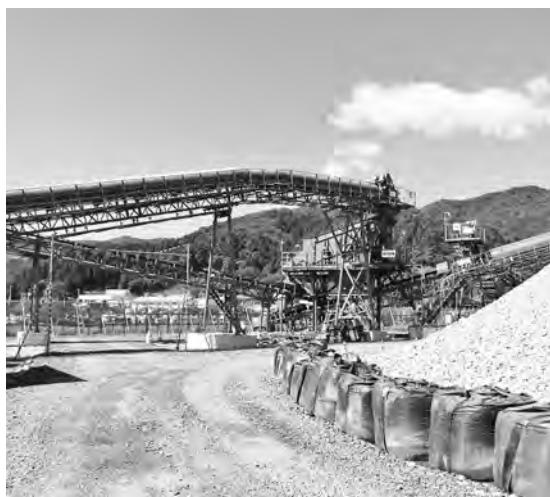
写真—4 通路と設備名称表示
