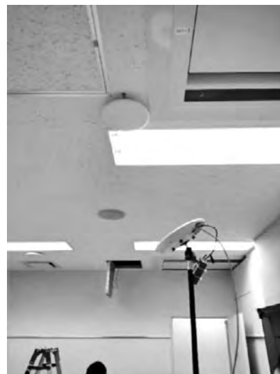
写真—2 専用ロケーターを用いたキャリブレーション作業
