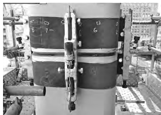
写真一 1 溶接前のコラム外観と仮固定治具
