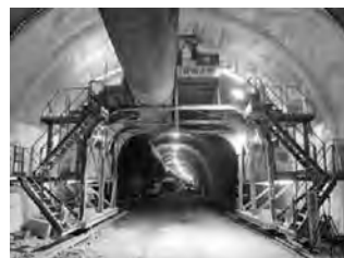
写真—2 吸音材取付前
