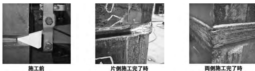
図—6 ボックス柱隅角部用セラミックタブを用いた施工例
