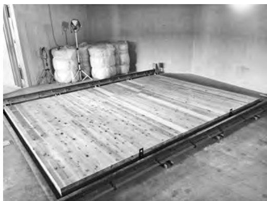
写真—1 CLT 床設置状況
