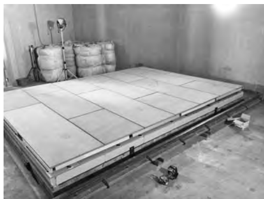
写真—2 二重床設置状況
