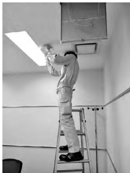
写真—1 ロケーター設置工事
