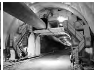
写真—3 吸音材取付後
