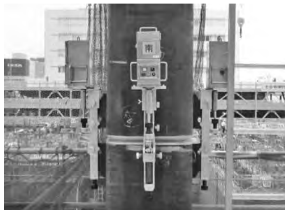
写真一4 自動建入れ制御装置
