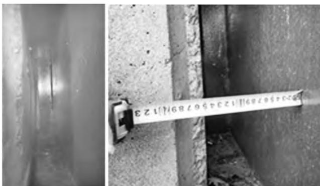
写真一七 建設後 43 年間塗装塗替がされていない部位 (護岸内の桁端部)
