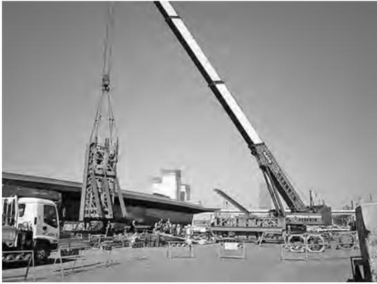
写真一五 200tクレーンによるリフトアップ設備組立
