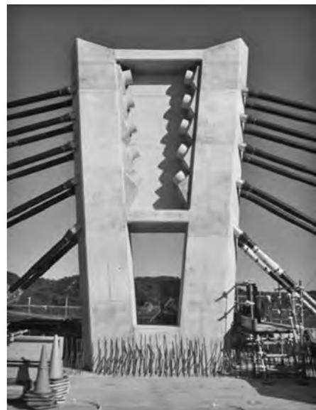
写真一1 鋼・コンクリート複合主塔構造
