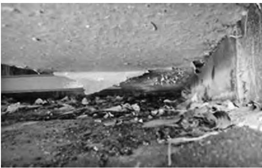
写真一12 護岸に接する主桁下面に発生した防食機能の劣化（建設後35年経過）
