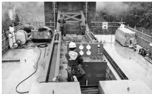
写真—4 アーチリブの角度調整装置
