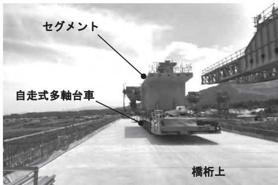
写真一2 自走式多軸台車による橋上運搬状況
