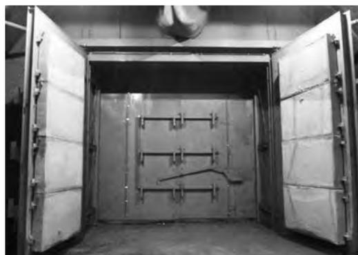
図-2 改造型防音扉の設置状況
