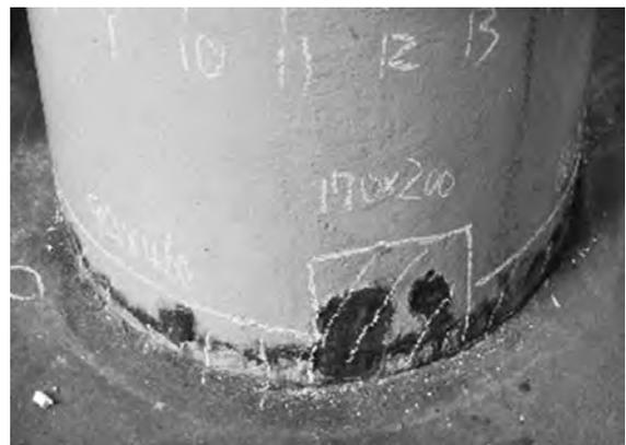
写真-5 塗装塗替11年で歩道橋橋脚基部に発生した腐食
