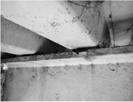
写真一11 波型デッキと主桁上フランジ間に発生した腐食（建設後32年経過）
