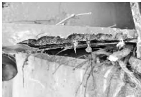
写真-2 塗装塗替5年で下フランジに発生した局部腐食
