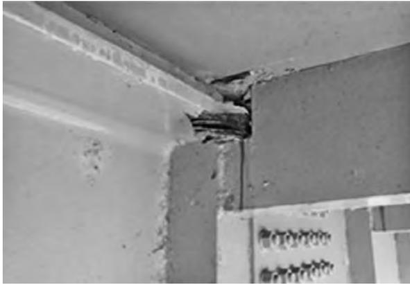
写真一六 塗装塗替 18 年で上フランジに発生した層状腐食 (漏水無し)
