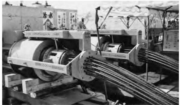
写真-7 ロアリングジャッキシステム
