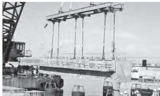
写真-1 プレキャスト上部工の架設状況
