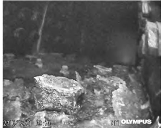
写真一八 建設後 28 年が経過した狭小閉鎖断面修復を有するアーチリブ内部の腐食
