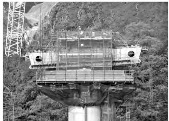
写真—7 ハーフプレキャストによる柱頭部施工
