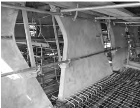
写真—6 バタフライウェブセット完了
