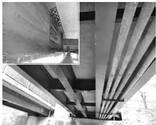
写真一九 添架管により主桁間に侵入が出来ない事例 (左上写真一主桁間は塗装塗替未施工 (建設後 45 年経過))
