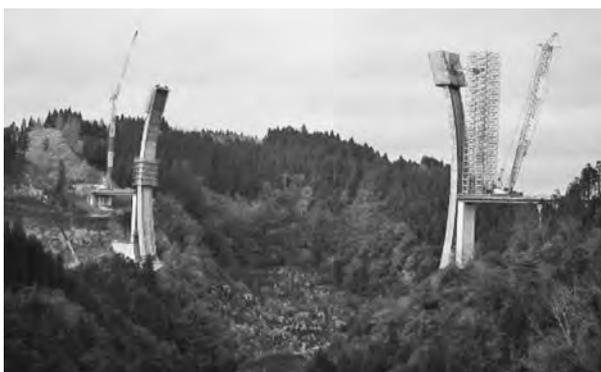
写真—3 アーチリブのクライミング施工状況
