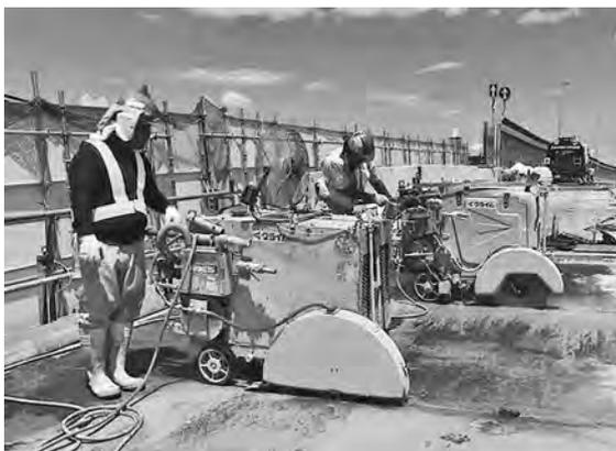
写真—3 複数台による床版切断状況
