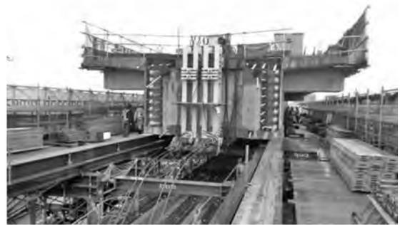
写真-2 押し出し架設状況
