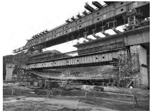
写真一3 最大支間 59m 架設状況
