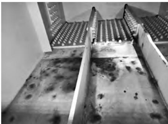
写真-3 塗装塗替1年で箱桁内部に発生した腐食
