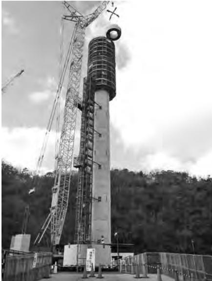
写真一 橋脚の施工状況
