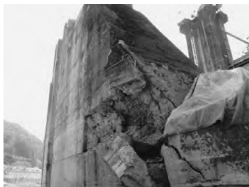
写真-1 発破後の状況
