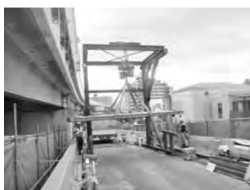
STEP ② UFC 床版吊上げ旋回
