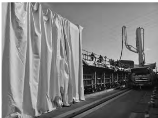
写真—5 U桁打設状況
