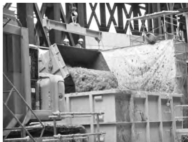
写真-3 ずり出し状況
