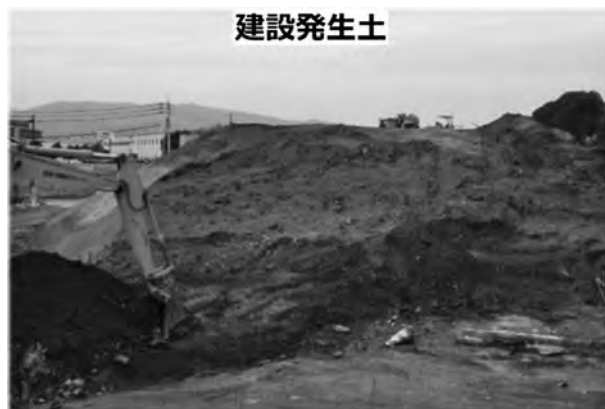
図一3 建設発生土（イメージ）
