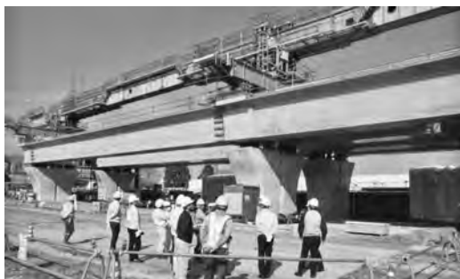
写真—4 リフティングガーダー
