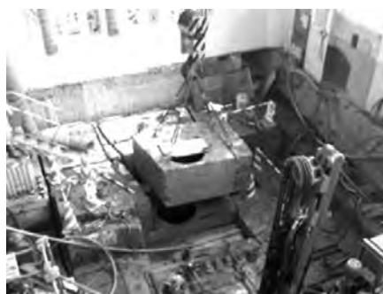
写真—8 ブロック吊上げ
