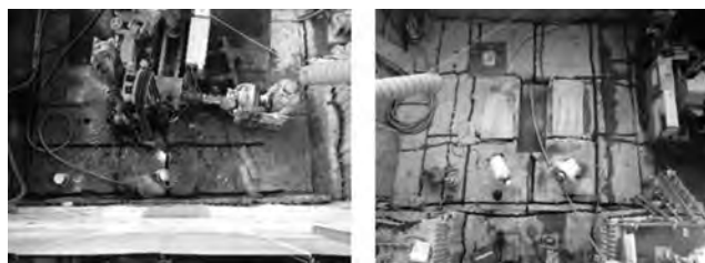
写真—5 分割削孔状況（左）、同完了全景（右）
