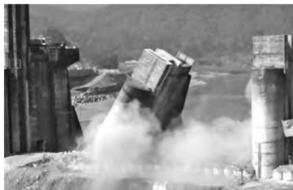
写真-2 発破の状況
