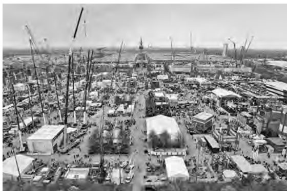
写真—1 展示会場の全景（主催者 HP 掲載写真より）
