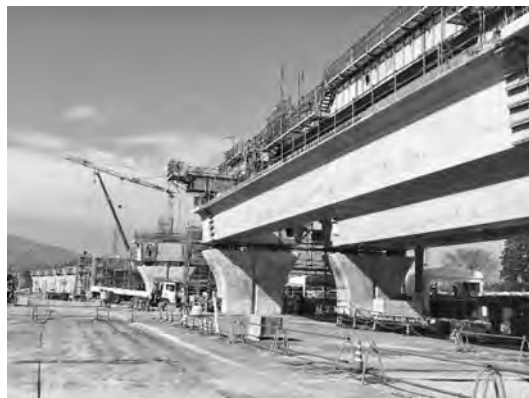
写真—2 現場全景
