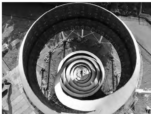
写真—1 本工法施工状況 上空から
