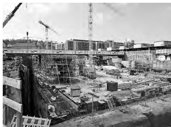
写真—36 工事作業状況
