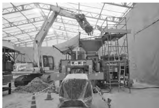
写真-2 圧縮梱包機による畳の中間処理状況
