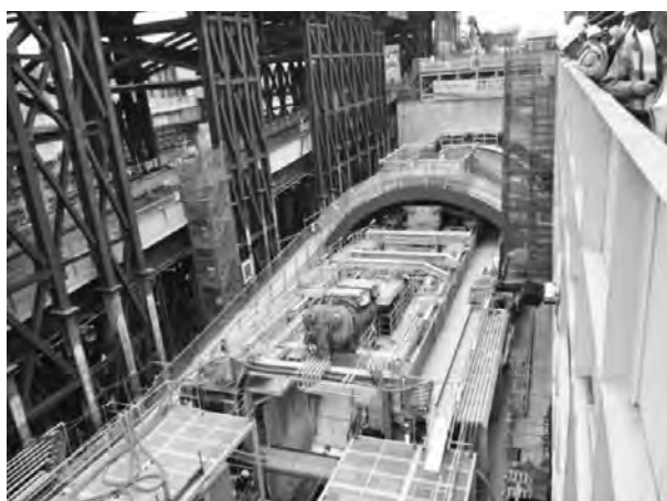
写真-2 シールド機テール部と後続台車
