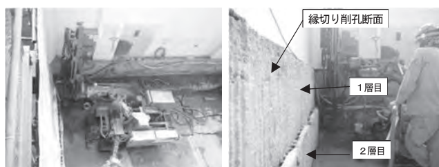
写真—4 外周縁切り削孔全景（左）、同近景（右）
