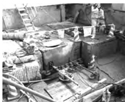
写真—7 ワイヤーソー切断
