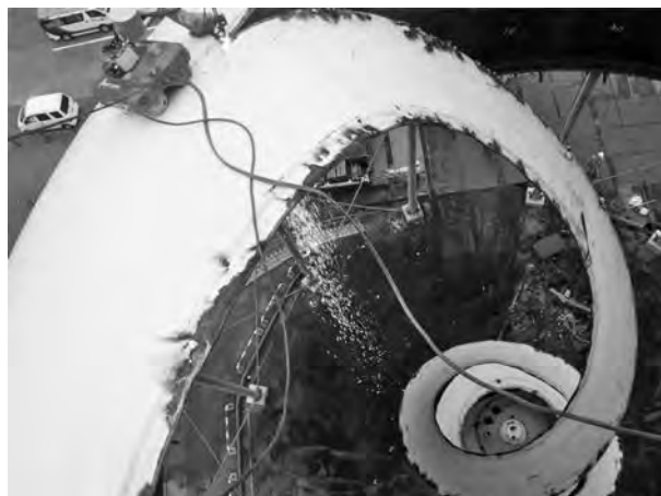
写真－3 本ロボットによる本工法施工状況
