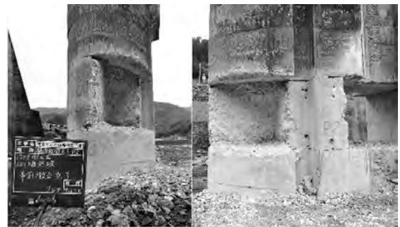
写真—4 転倒方向制御対策の支え部（残柱）
