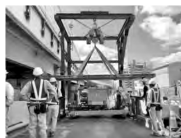
STEP ③ 専用架設機床版下通過
