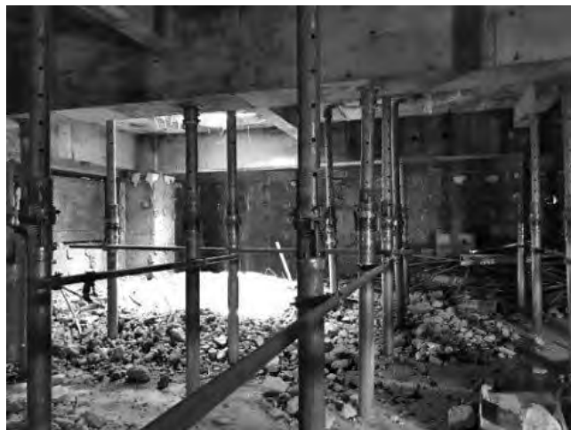
写真—2 上層階を支えるサポート
