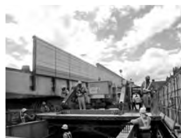
STEP ⑥ UFC 床版架設
