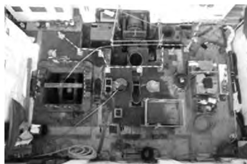
写真—9 基礎コンクリート撤去着手前
