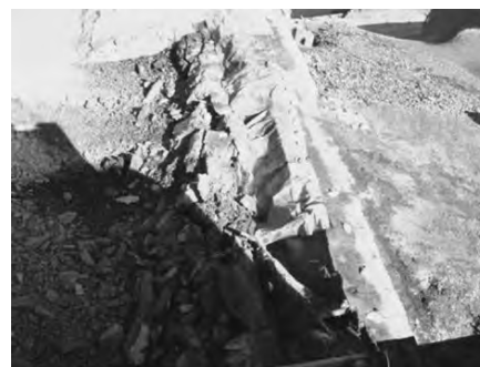
写真－10 パラウェブ・マット設置（発破後）
