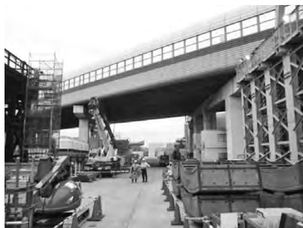
写真-4 セグメント置き場
