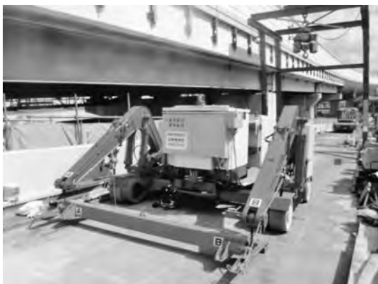
写真—1 専用架設機
