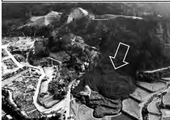
図二 大阪府豊能町での土砂崩落事案
