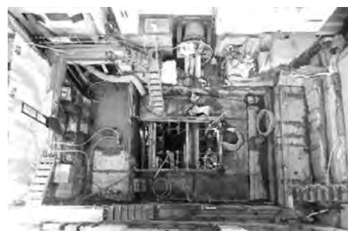
写真—10 基礎コンクリート撤去完了
