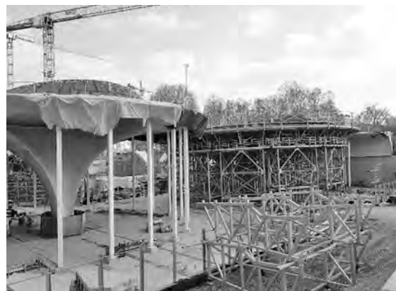
写真—37 中央駅舎の柱建設状況
