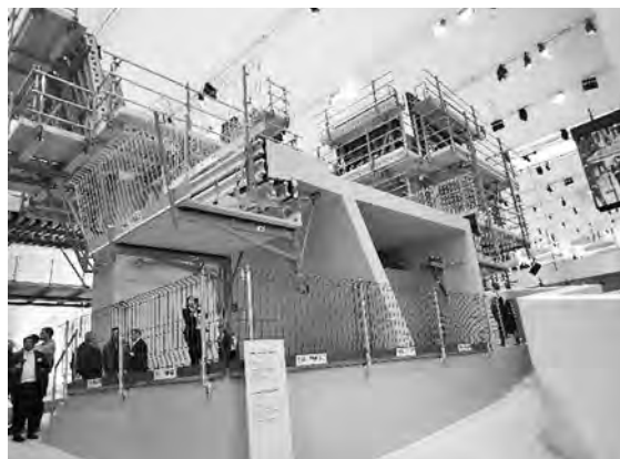
写真-19 作業床 (PERI)
