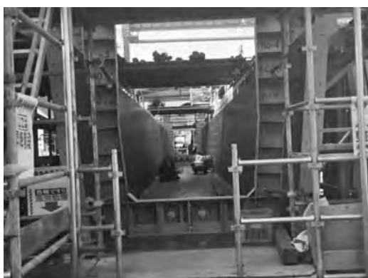
写真—6 剥落防止工
