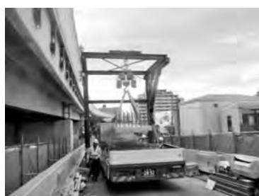
STEP ① UFC 床版搬入荷降し
