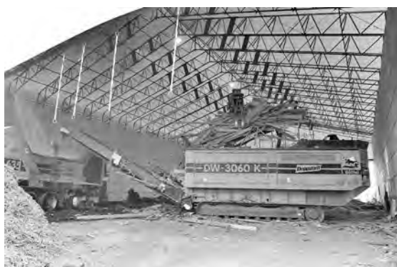
写真-1 粗破砕機と破砕機による木くずの二次破砕状況
