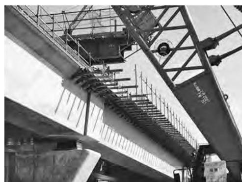
写真—8 高欄施工用張出足場
