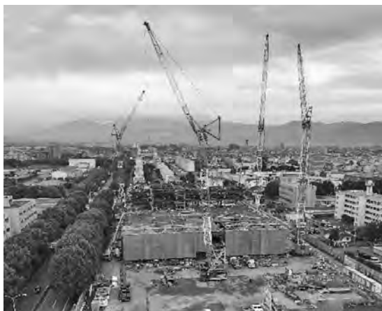
写真—2 鉄骨建方状況
