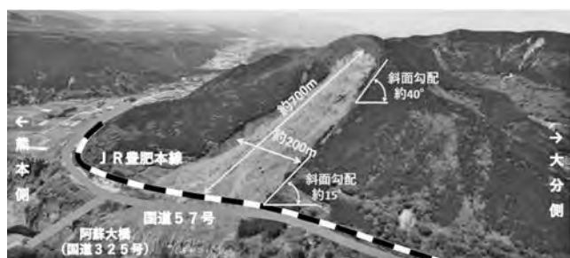
図—1 阿蘇大橋地区の被災状況
