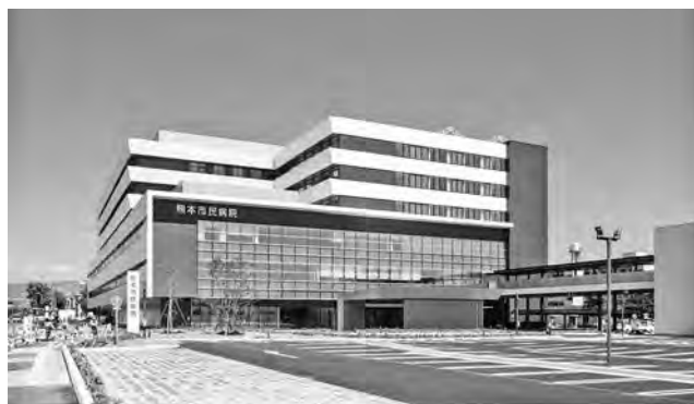
写真—5 完成写真
