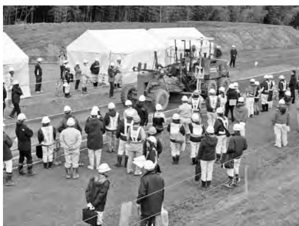
写真—5 ICT 施工見学会の集合写真
