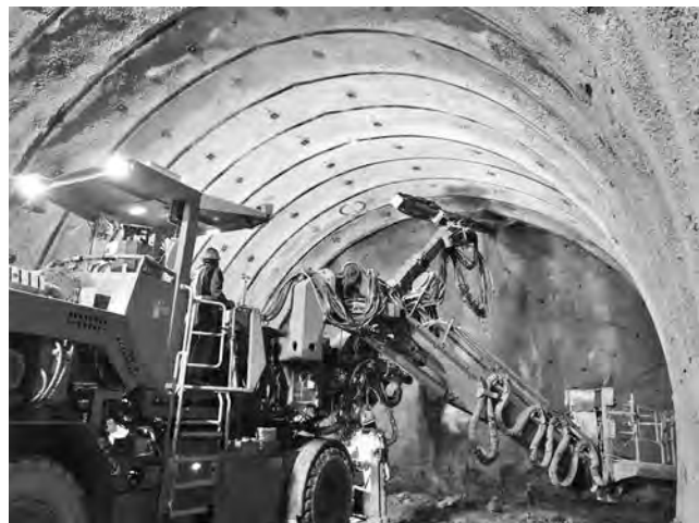
写真—1 SANDVIK社のコンピュータジャンボによる削孔状況
