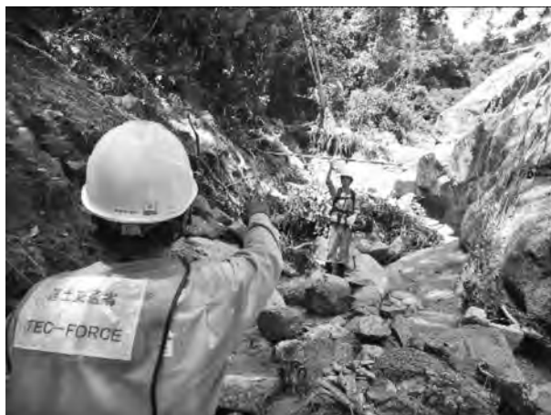
写真—3 地上調査状況
