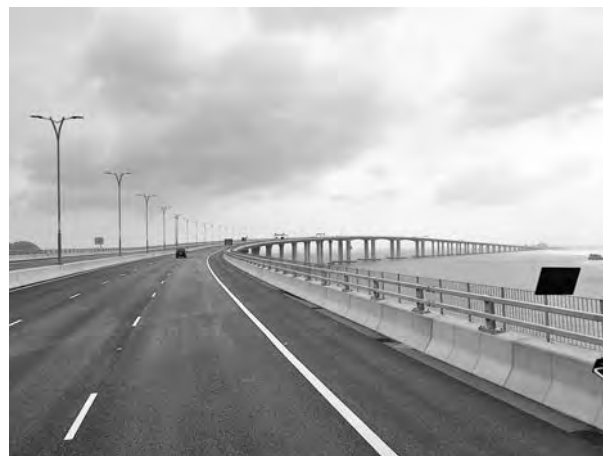
写真-1 港珠澳大橋
