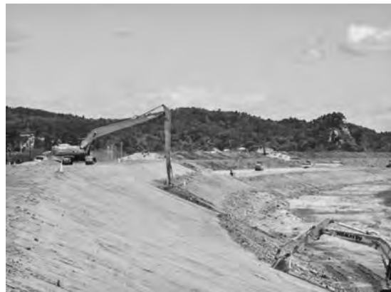
写真—4 法面整形状況
