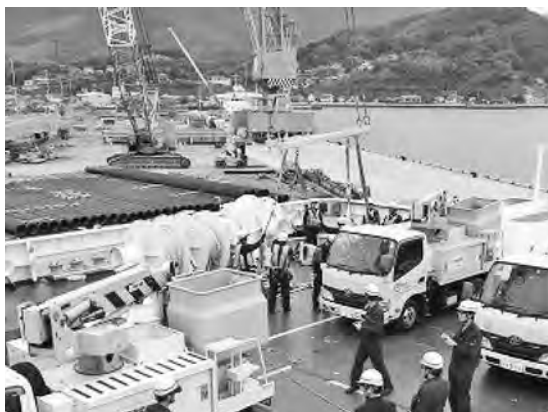
写真—15 作業甲板への車両搭載状況
