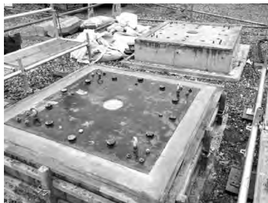
写真-1 免震下部基礎充填試験
