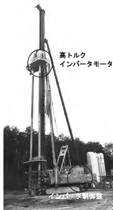
写真一 1 施工機全景
