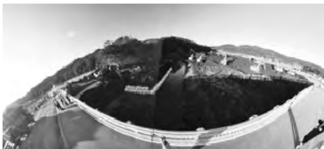
写真—3 北海道胆振東部地震（復旧後）
