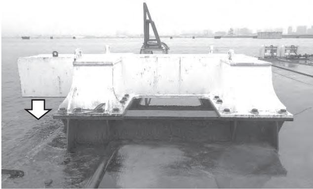
写真-7 微調整ガイドキー (最終函)
