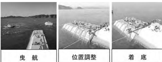
写真-1 ケーソン据付け状況
