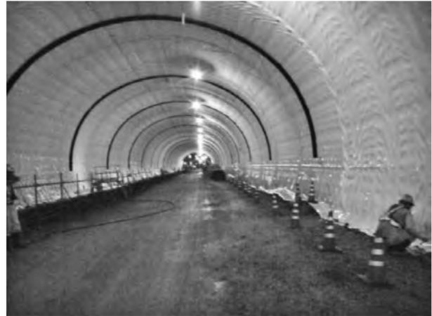
写真三 背面平滑工法防水シート
