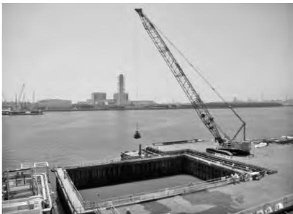
写真-5 築島締切り工の施工
