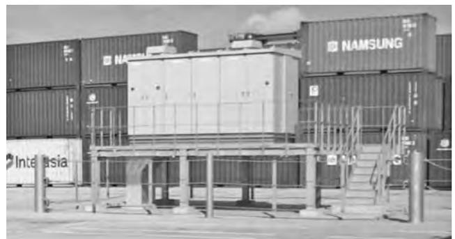
写真—3 電気設備の嵩上げ事例
