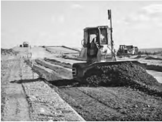
写真一5 7t級ブルドーザ(湿地式)によるCSGの敷き均し
