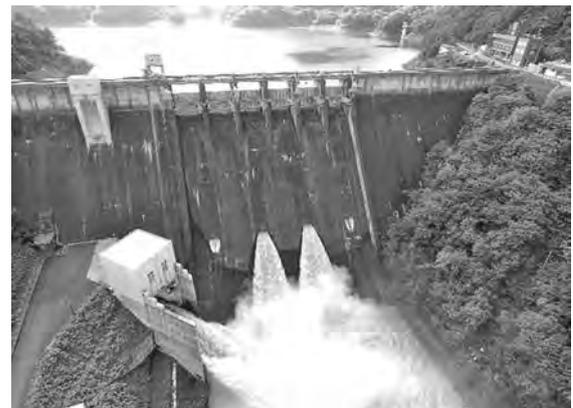
写真一 高圧放流設備による放流
