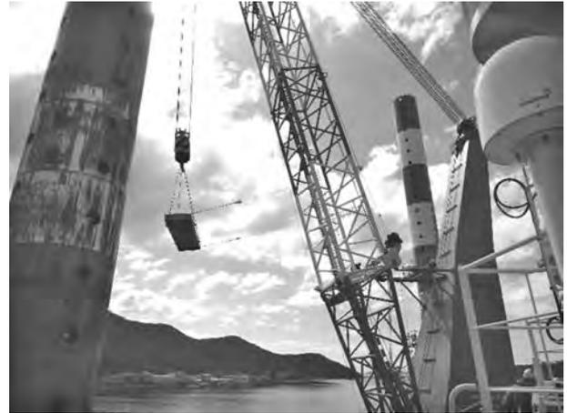
写真—11 タグラインシステム使用状況
