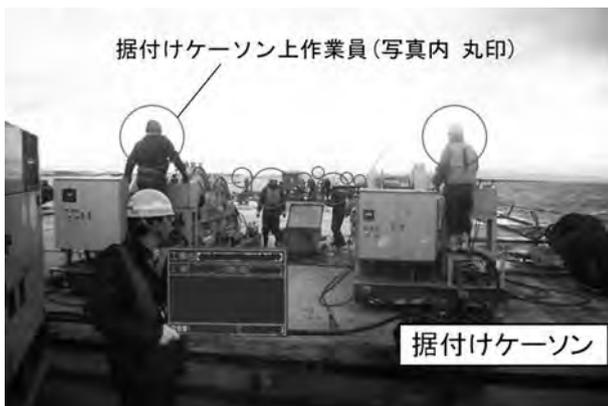
写真-5 従来方法による据付け状況
